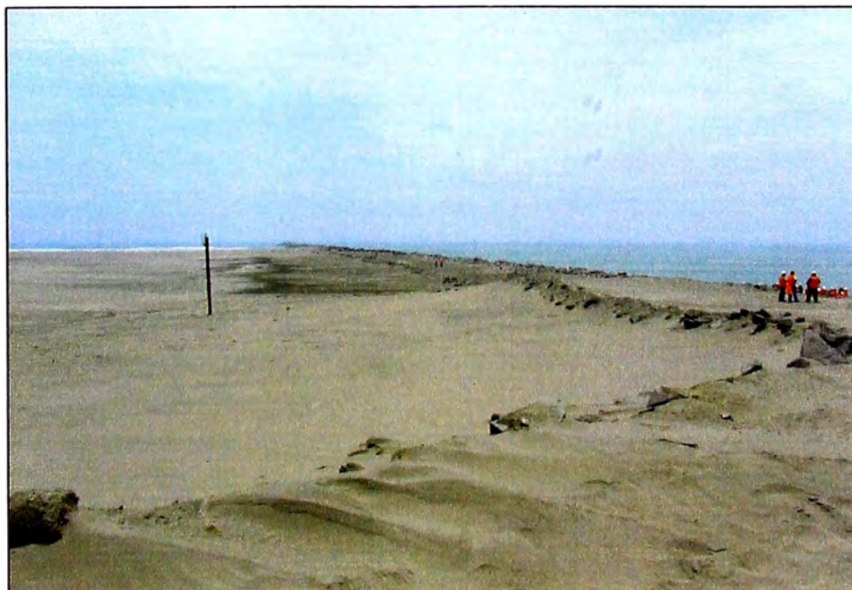
Foto N°2: Vista del lado derecho del molo retenedor que ha sido sedimentado.
