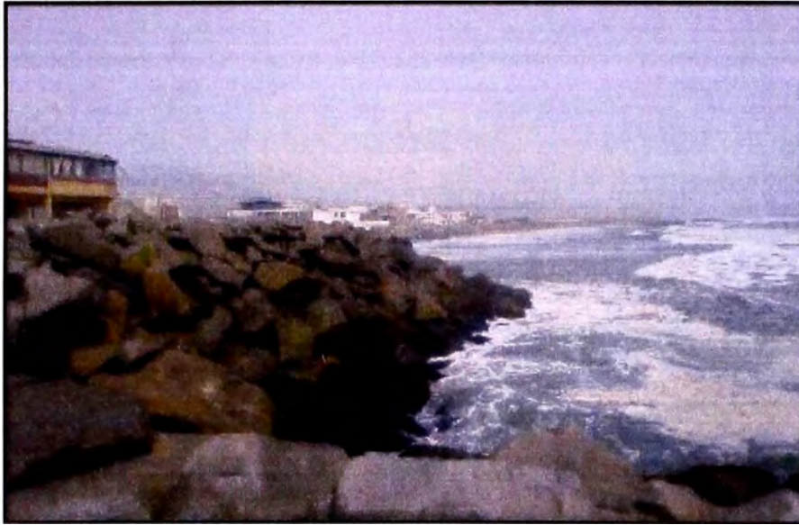
FIGURA N° 1.3: Erosión de la línea costera, formando taludes, pérdida de volumen de arena
