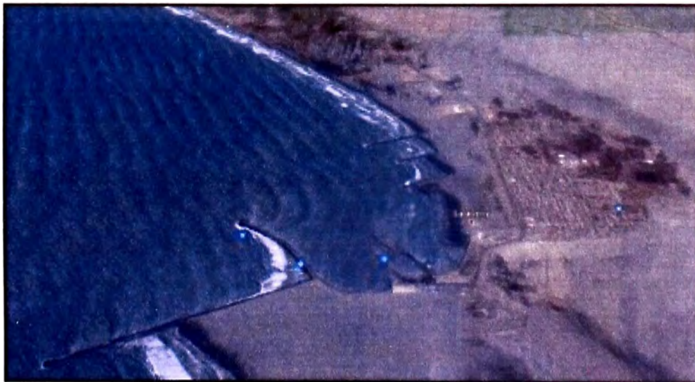
FIGURA N° 1.7: Terminal Portuario de Salaverry en la actualidad
