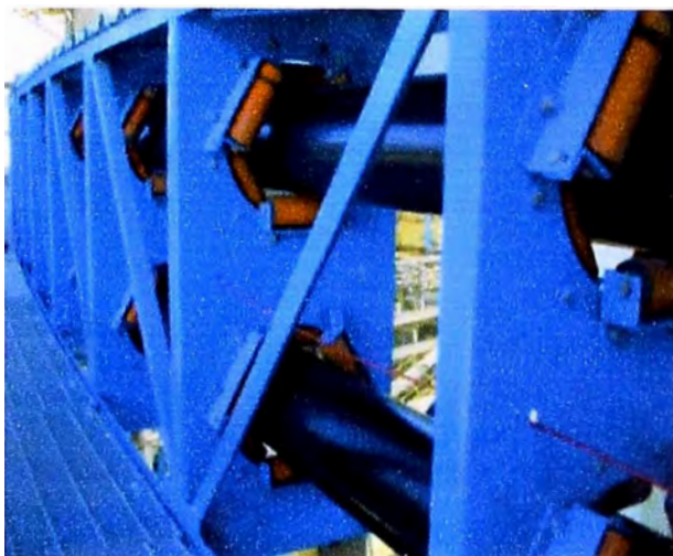
FIGURA N° 3.9: Transporte por Faja tubular
