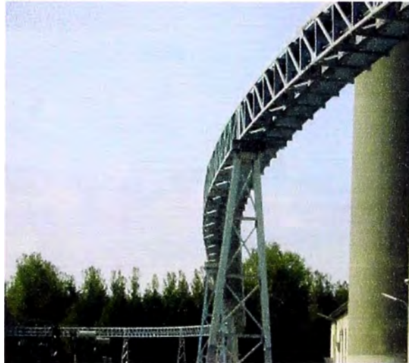
FIGURA N° 3.11: Transporte por Faja tubular
