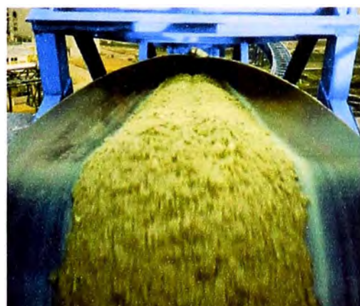
FIGURA N° 3.12: Descarga de Faja tubular
