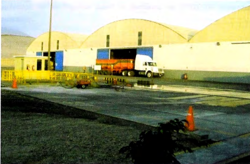
FIGURA N° 2.1: Almacén temporal exterior al TPS
