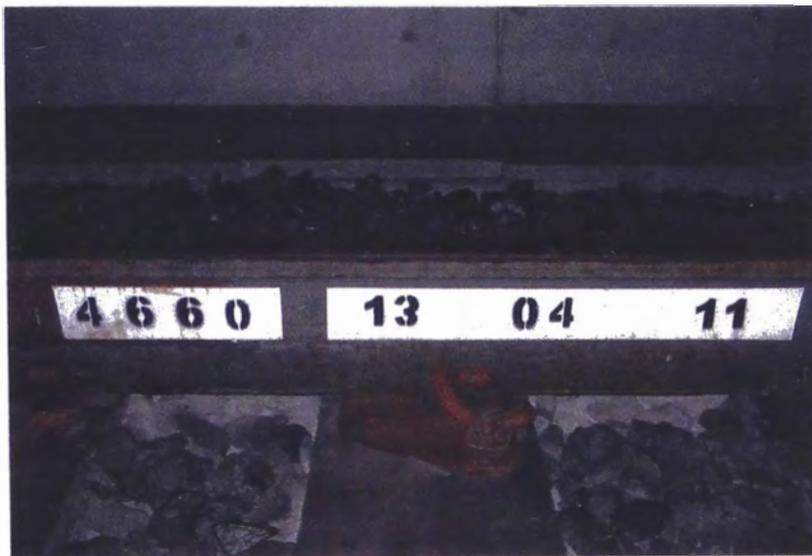
Figura 3.14: Identificación de las soldaduras.
