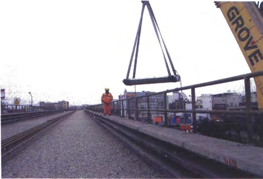
**Figura 4.9: Izaje de los durmientes con eslingas.**
