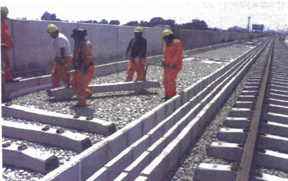
**Figura 4.8:** Alineamiento de los durmientes de concreto
