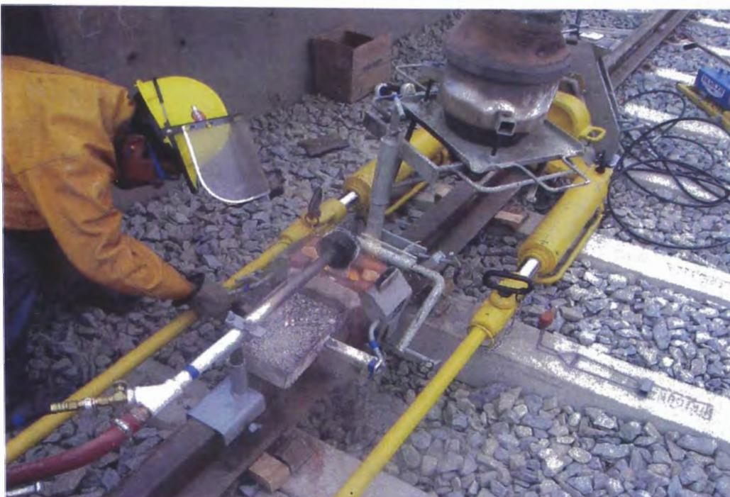
**Figura 3.22: Pre calentamiento del molde de la Soldadura Aluminotérmica**
