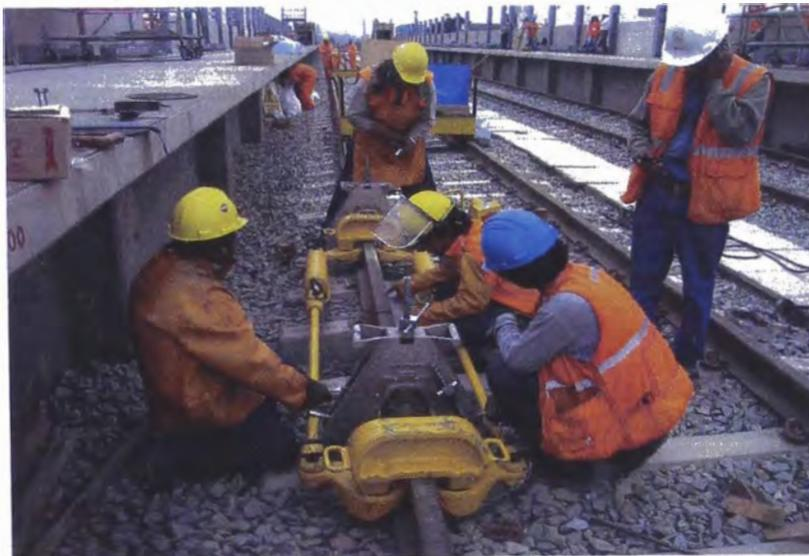
Figura 3.21: Alineamiento de los rieles en la Soldadura Aluminotérmica
