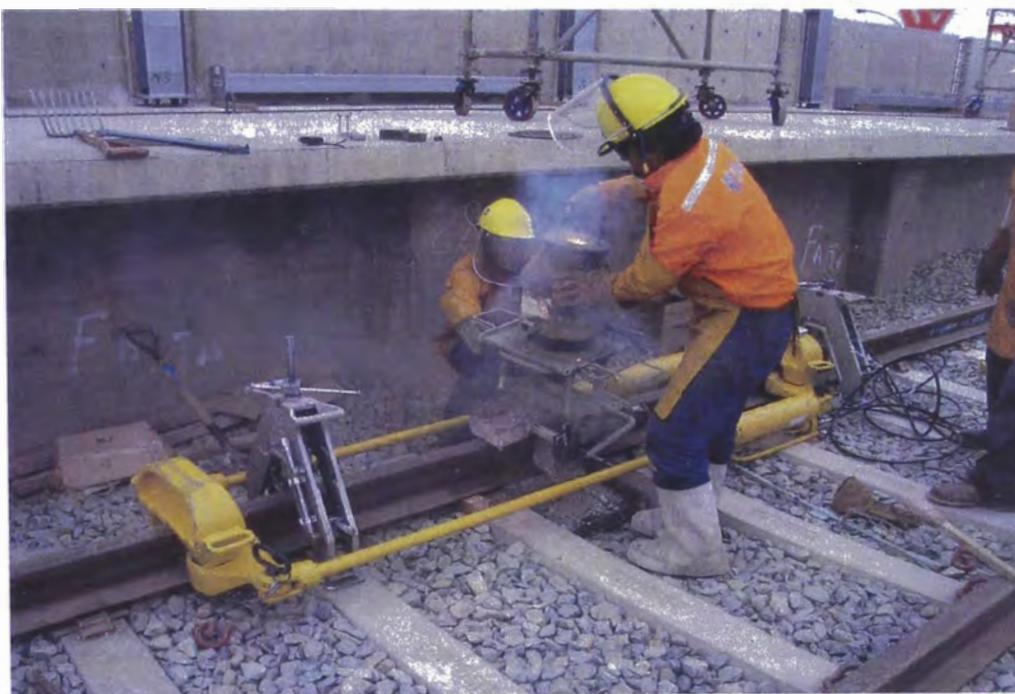
**Figura 3.23: Pre calentamiento del Crisol**
