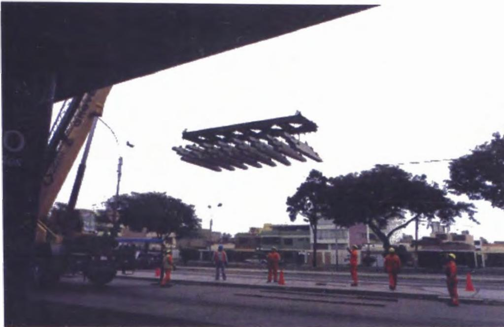
**Figura 4.7:** Izamiento de los durmientes hacia la losa del viaducto.
