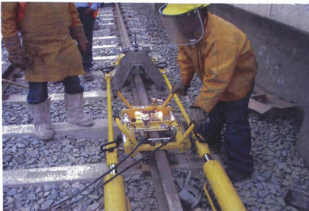
**Figura 3.26: Rebarbadora Hidráulica en la Soldadura Aluminotérmica**
