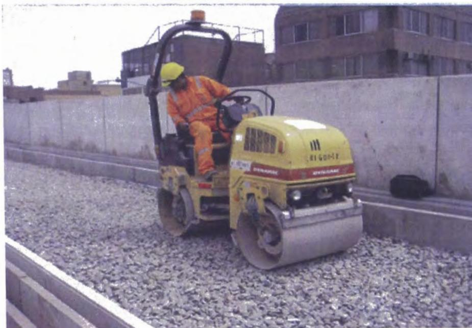
**Figura 4.5: Rodillo Liso compactando el Balasto.**
