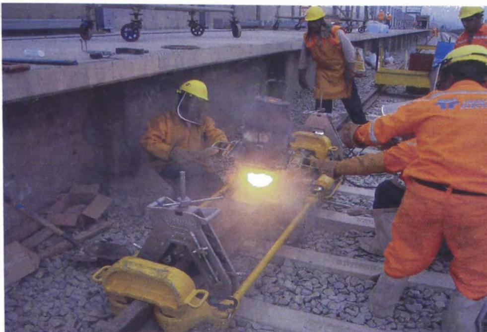
**Figura 3.24: Fundición del material de Ignición**
