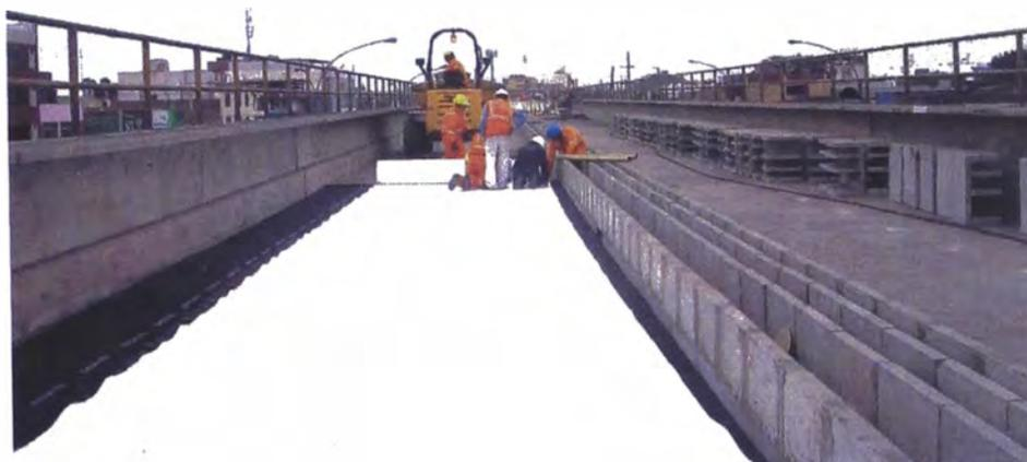
Figura 3.1: Manta elástica (Color negro) y el geotextil (Color blanco).
