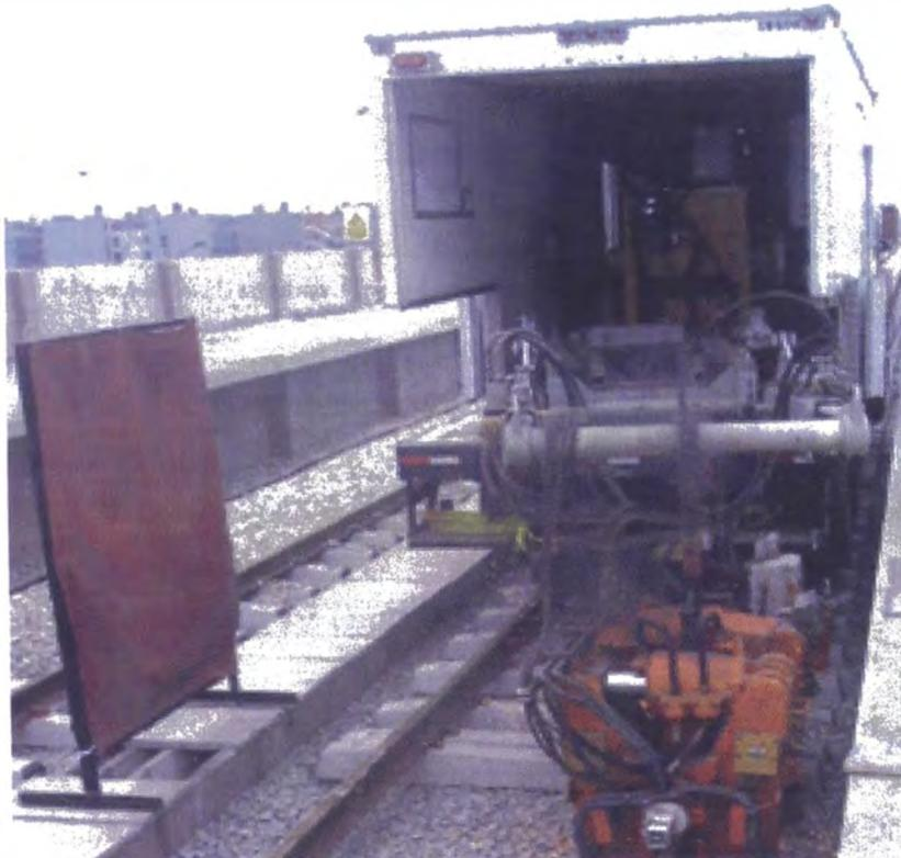
**Figura 4.15: Camión soldador utilizado para la soldadura electrofundición.**
