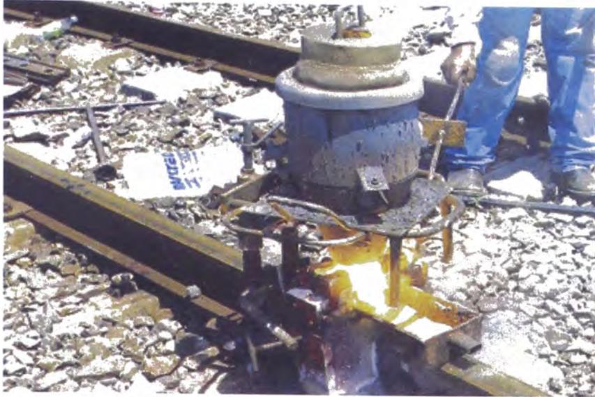
Figura 2.7: Instante en que se realiza la soldadura aluminotérmica.
