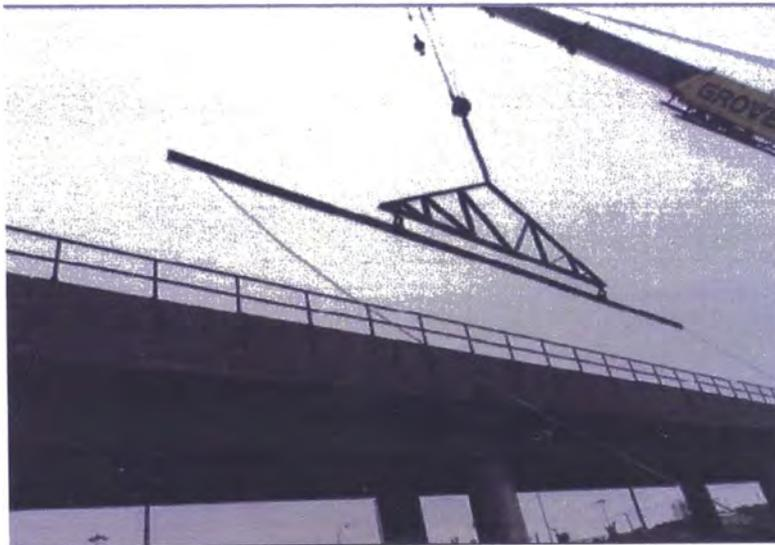
**Figura 4.10: Izaje de Rieles con la Estructura Metálica**
