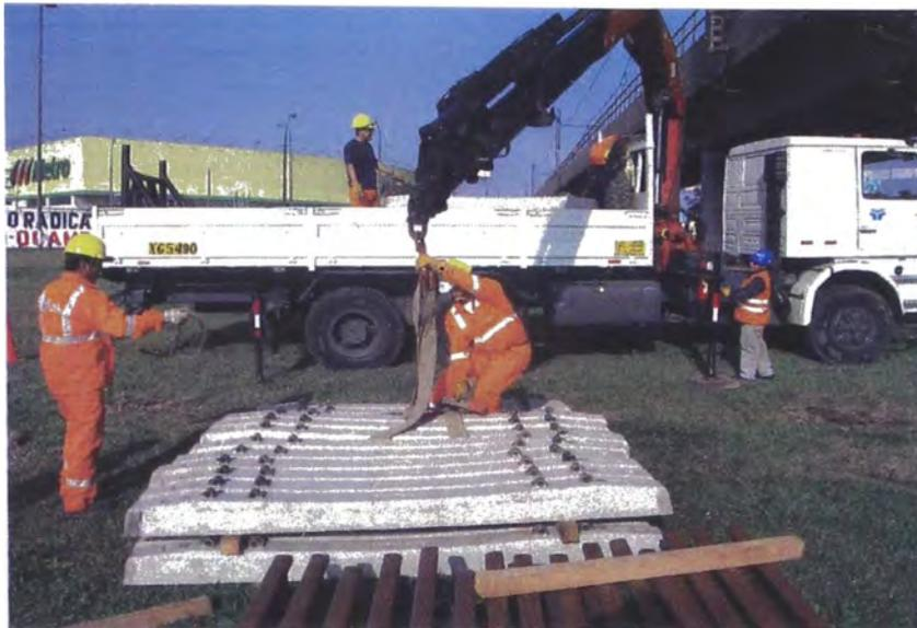
**Figura 4.6: Descarga de los durmientes de Concreto.**
