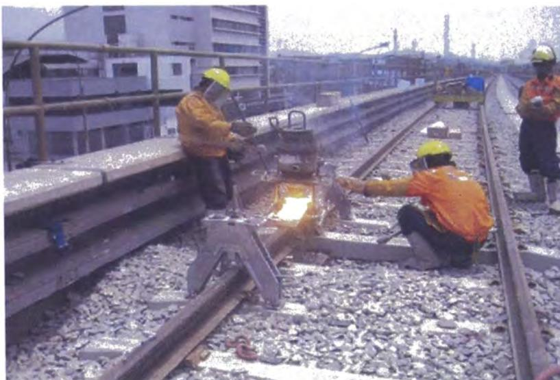
**Figura 4.18: Soldadura aluminotérmica de los rieles.**
