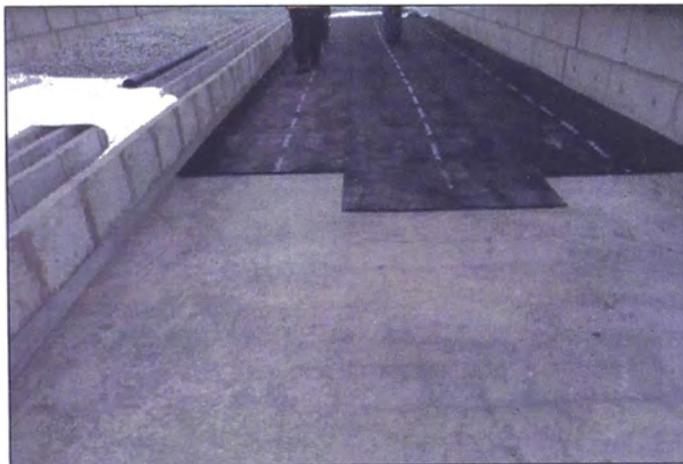
Figura 4.1: Se muestra la colocación la manta de caucho.
