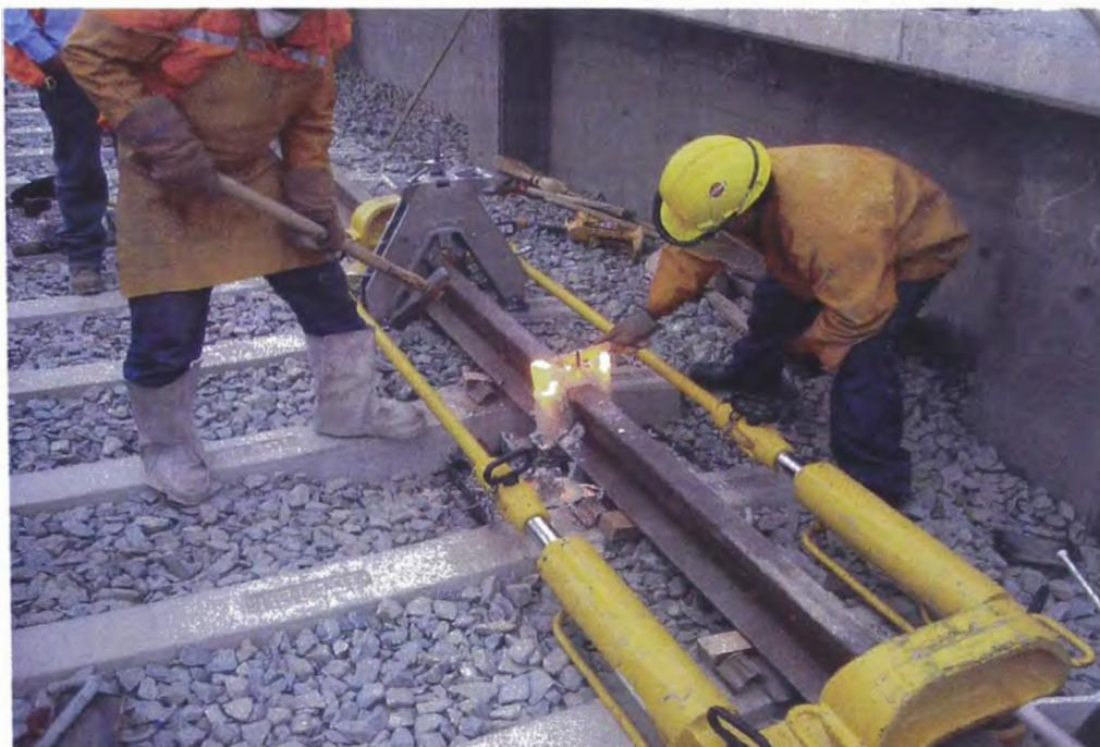
**Figura 3.25: Eliminación de las Rebabas de la Soldadura**
