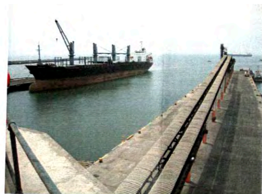
Foto N° 10: Nave de Carga
