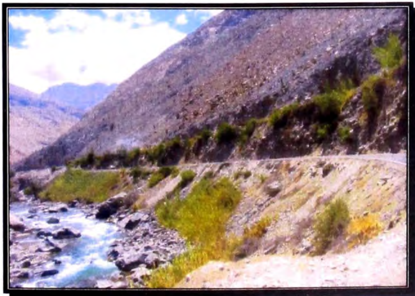
Carretera Media Ladera
