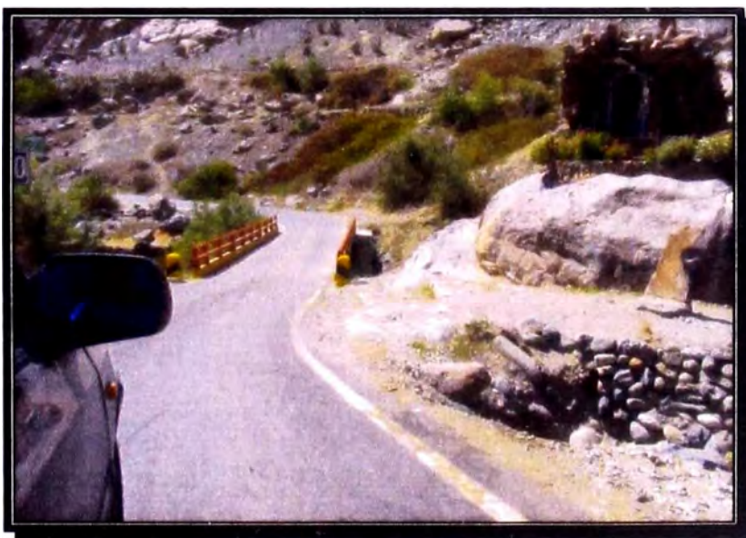
Presencia de Puentes en el Circuito a medir
