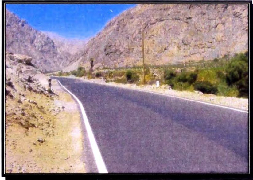
Inicio de Tramo a medir
