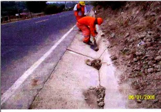
Foto 3.14: Limpieza de cunetas
