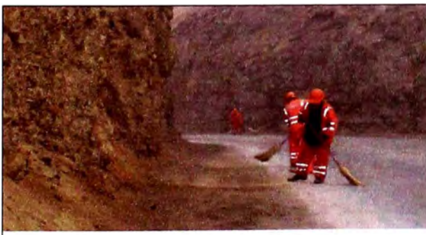
Foto 3.5: Limpieza de cunetas
