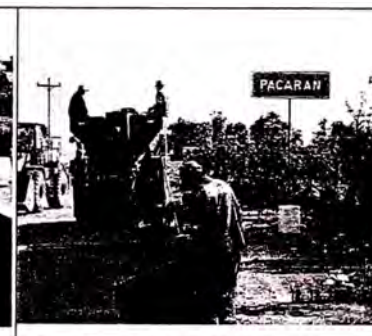
Foto 3.30: Colocación de mortero asfáltico
