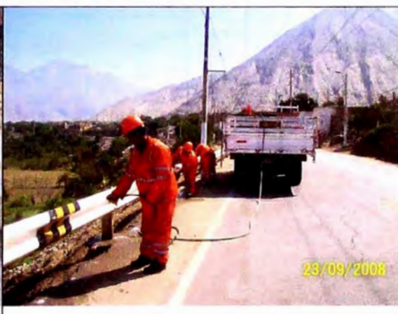
Foto 3.23: Limpieza de guardavías
