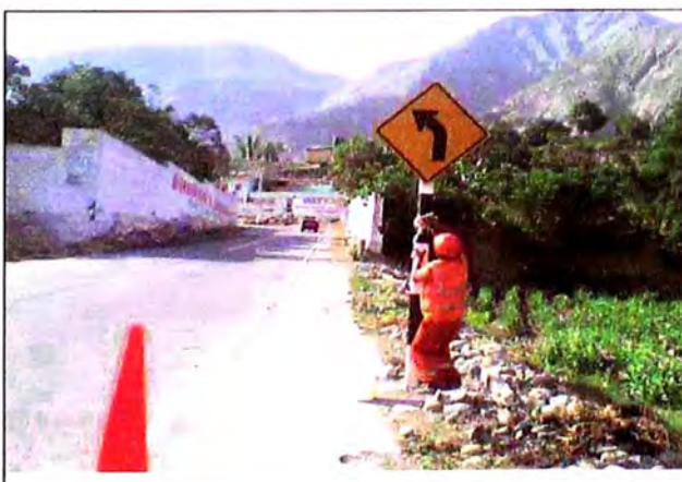
Foto 3.18: Limpieza de señales
