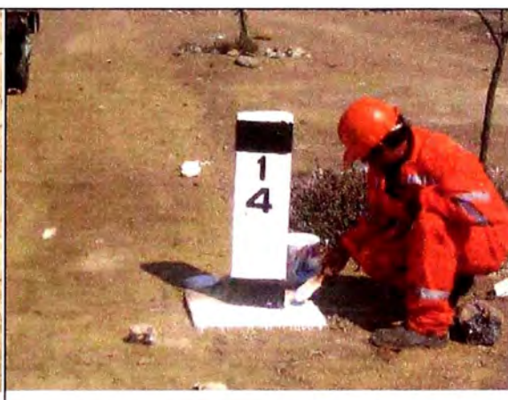
Foto 3.21: Limpieza de hitos
