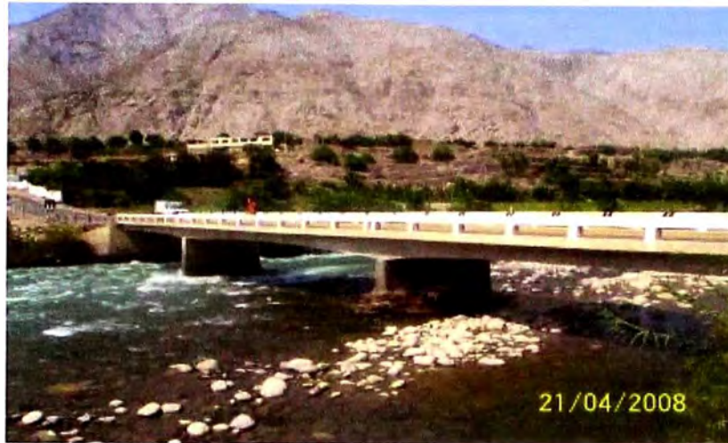
Figura N° 1. 10: Puente viga-losa en buen estado estructural
