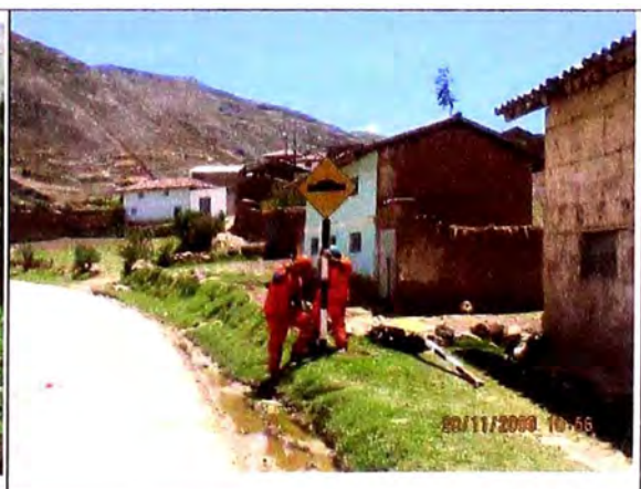
Foto 3.19: Limpieza de señales
