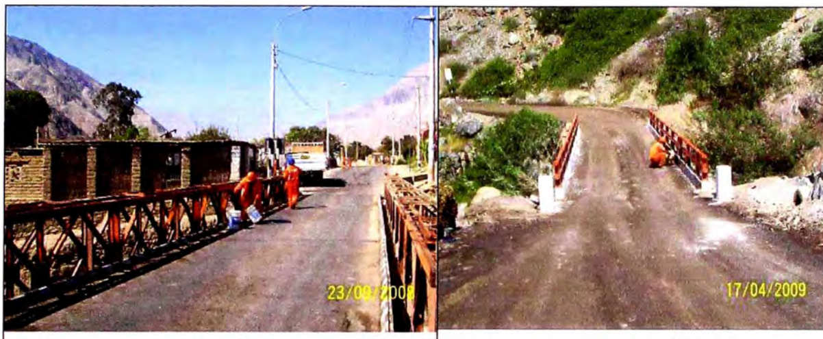
Foto 3.17: Limpieza de puentes
