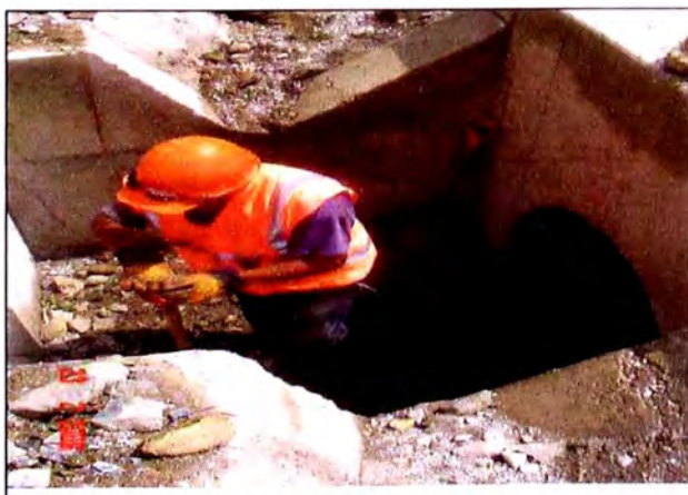
Foto 3.12: Limpieza de cabezales
