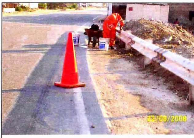
Foto 3.22: Limpieza de guardavías
