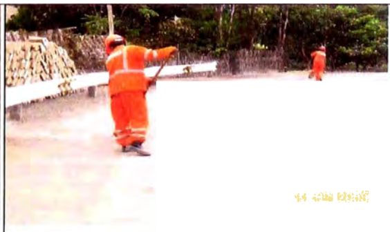
Foto 3.6: Limpieza de plataforma
