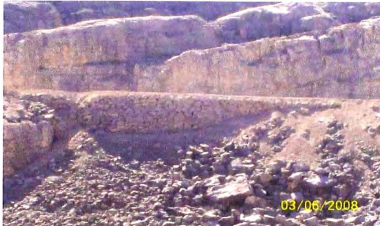
Figura N° 1. 11: Muro de mampostería de piedra seco
