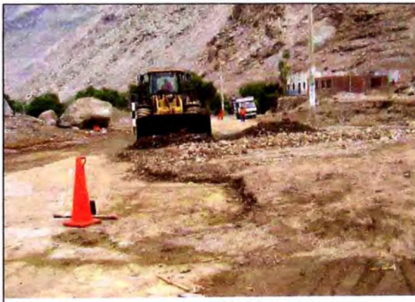
Foto 3.7: Limpieza de derrumbes en la vía
