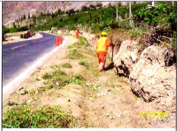
Foto 3.15: Limpieza de cunetas
