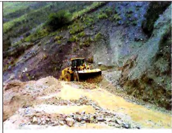
Foto 3.8: Limpieza de derrumbes
