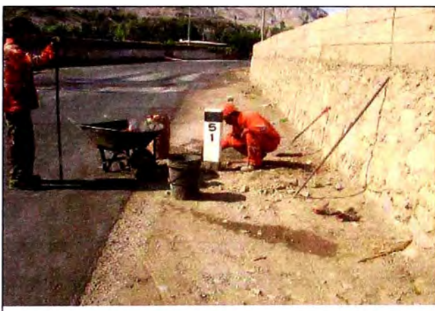
Foto 3.20: Limpieza de hitos
