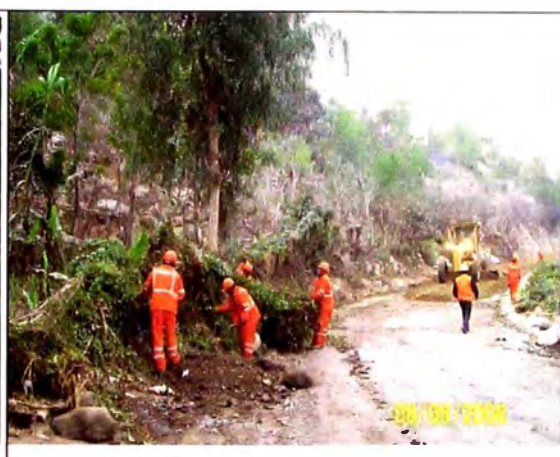
Foto 3.4: Limpieza de malezas en derecho de vía
