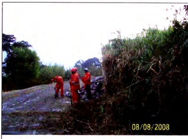
Foto 3.3: Limpieza de malezas en cunetas
