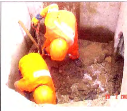
Foto 3.13 Limpieza de alcantarillas
