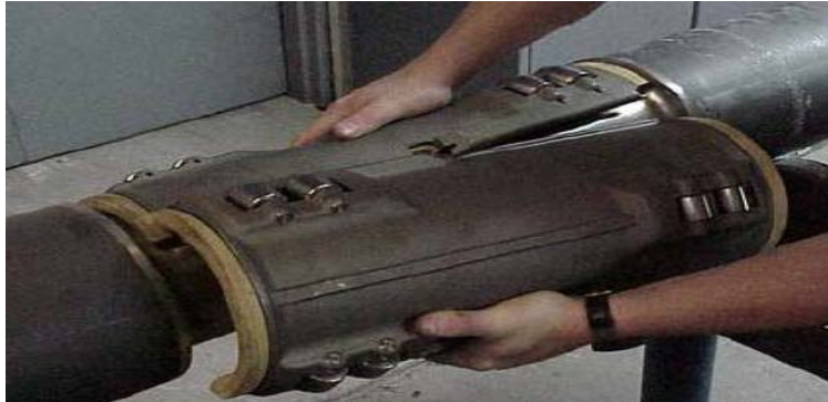
Fig. 6.10 Correcta ubicación de todo el conjunto de piezas en el substituto de tubería
