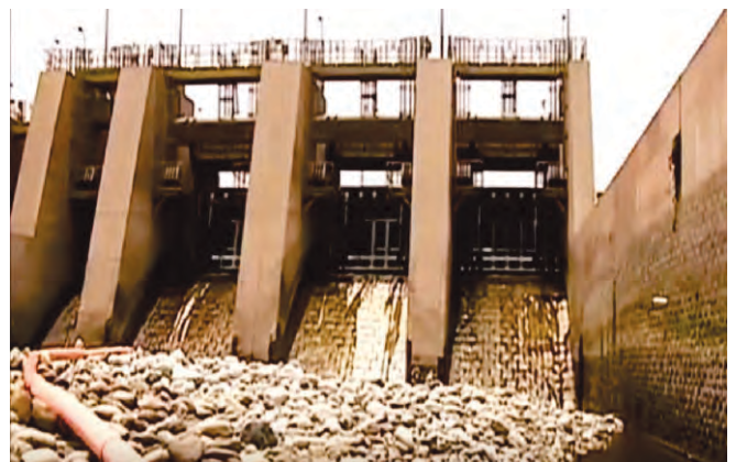
Cuadro N° 9. Planta de agua potable de Huachipa que necesita ser terminada
