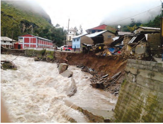
Cuadro N° 3. Colapso de viviendas construidas en las riberas de los ríos
