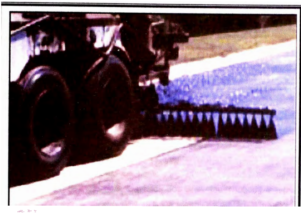
Fot. 4. Imprimación asfáltica realizada con la Emulsión Asfáltica
