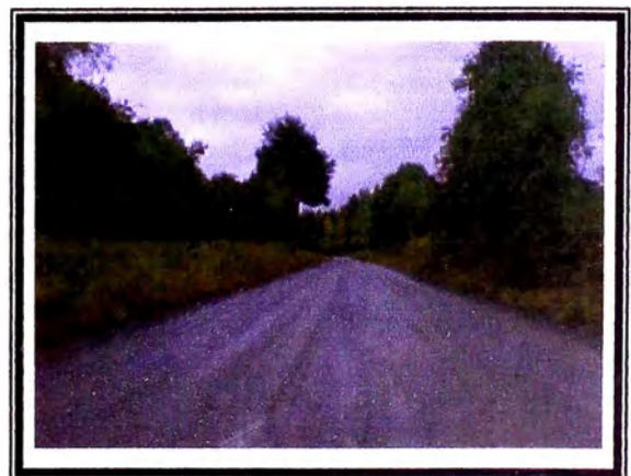
Fot.2 Carretera después del tratamiento con Emulsiones
