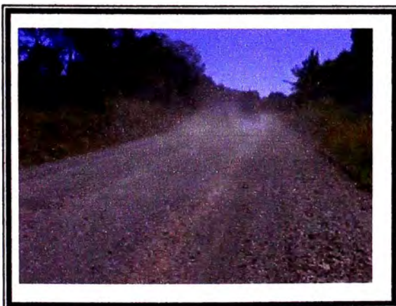
Fot. Carretera antes del tratamiento con Emulsiones
