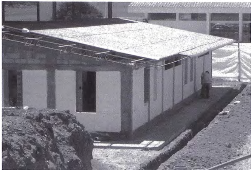
Foto 3.40 Pintura en Exteriores
