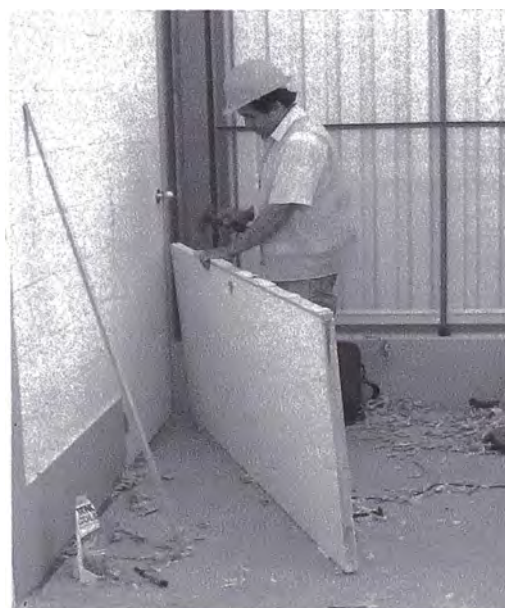
Foto 3.34 Acondicionamiento de Puertas
