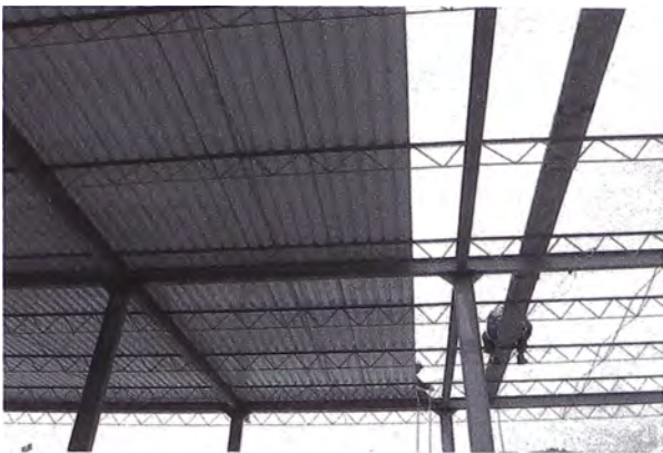
Foto 3.44 Cobertura en Nave Industrial
