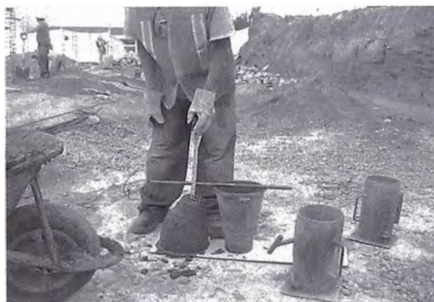
Foto 3.08 Prueba del Slump
