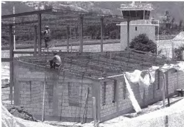
Foto 3.21 Viguetas de Acero Corrugado
