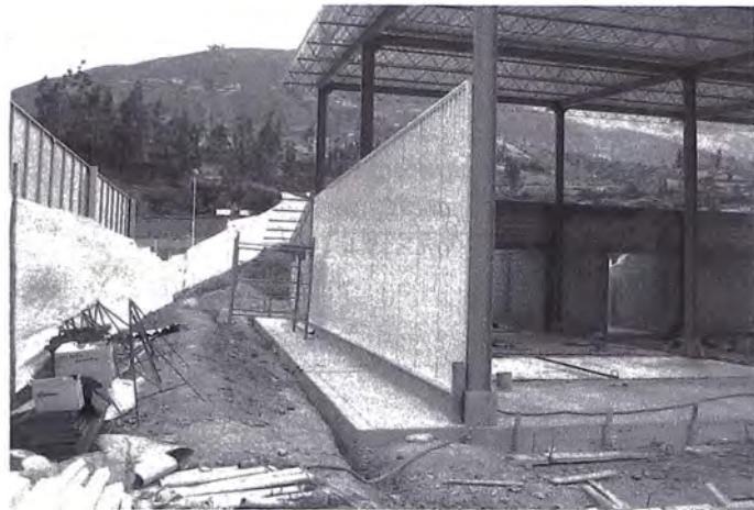
Foto 3.47 Cerramiento Lateral Acabado
