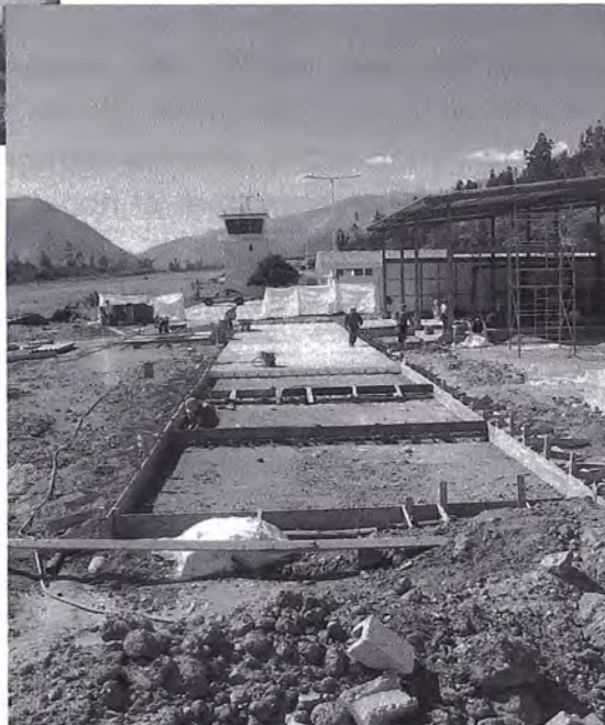
Foto 3.68 Encofrado Losa de Concreto
