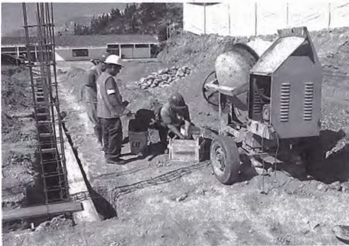
Foto 3.07 Pruebas para mezcla del concreto
