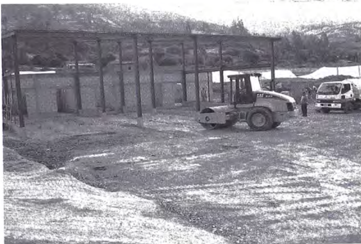
Foto 3.64 Compactación de Base Granular
