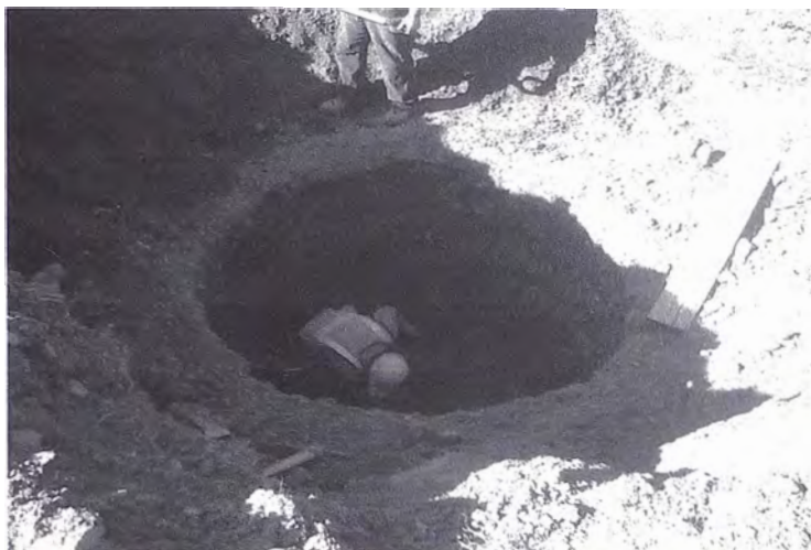
Foto 3.56 Excavación Pozo Percolador
