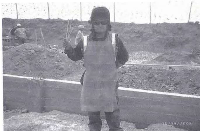
Foto 5.03 Equipo de Protección para Soldar
