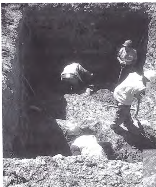
Foto 3.23 Excavación de Cisterna
