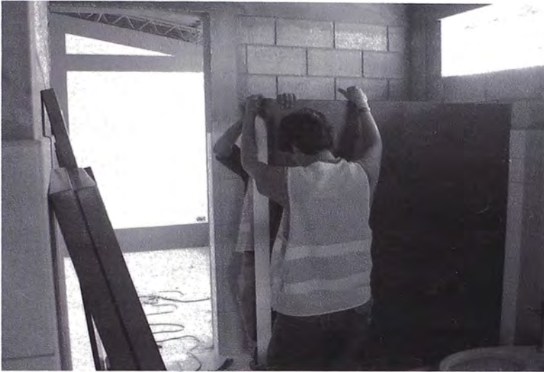
Foto 3.37 Instalación de Divisiones Metálicas
