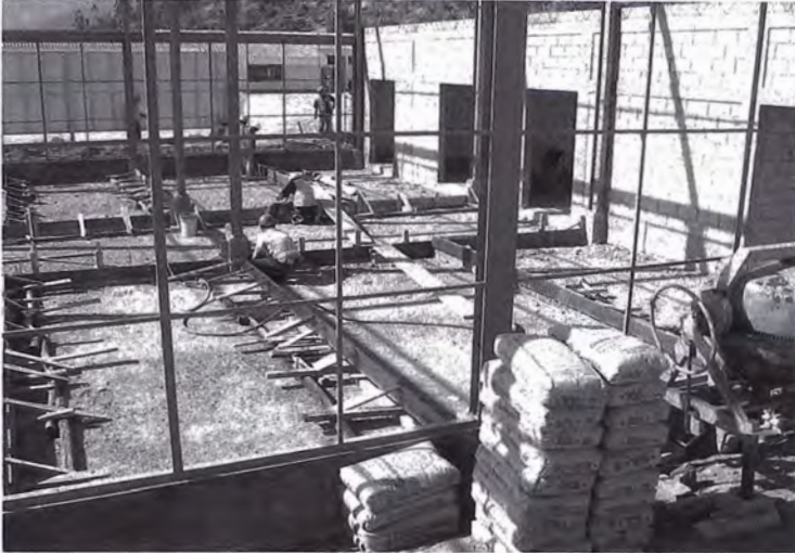
Foto 3.16 Encofrado Losas de Concreto
