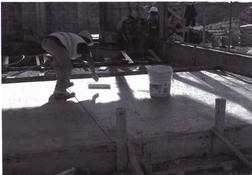
Foto 3.18 Curado de Losas de Concreto
