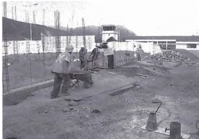
Foto 3.06 Transporte del Concreto
