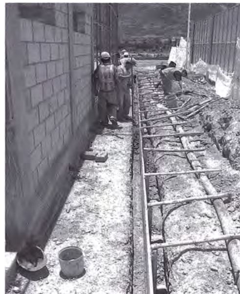
Foto 3.11 Encofrado de Veredas
