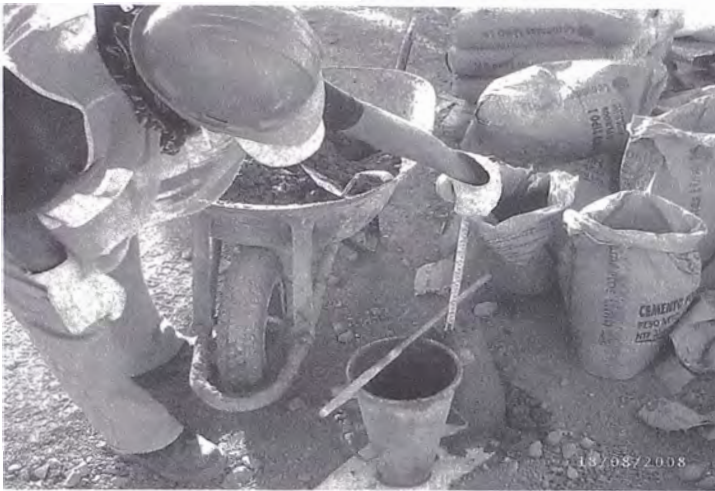
Foto 4.03 Medición del Asentamiento
