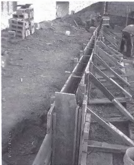
Foto 3.05 Encofrado de Sobrecimiento
