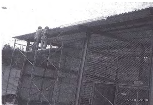
Foto 3.45 Canaleta de Evacuación Aguas de Lluvia
