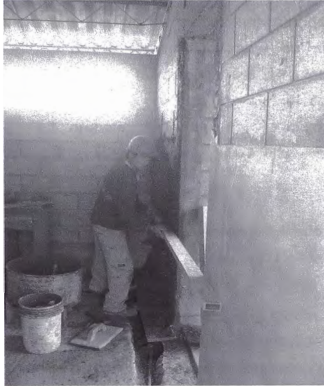
Foto 3.27 Tarrajeo en SS.HH.
