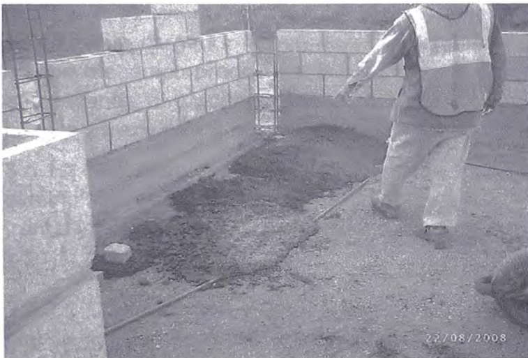
Foto 3.58 Instalación de Tubería Eléctrica.
