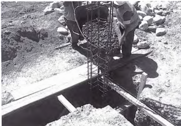
Foto 3.02 Vaciado de Zapatas
