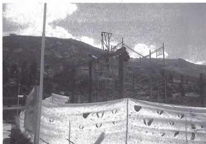
Foto 3.22 Montaje de Viga Metálica
