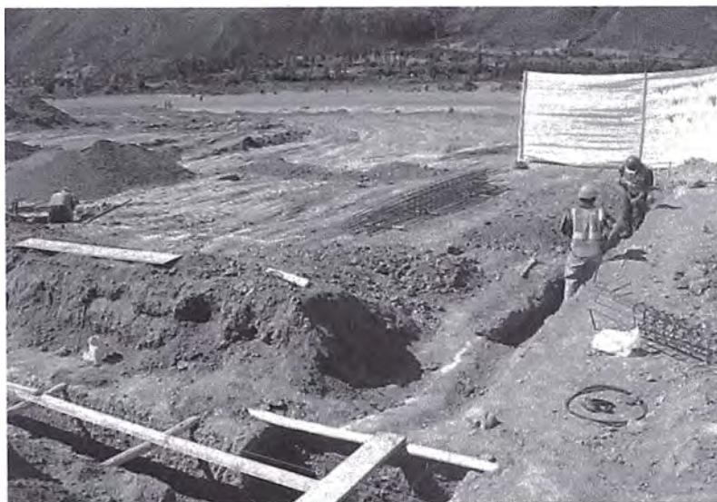
Foto 3.01 Excavación de cimientos corridos
