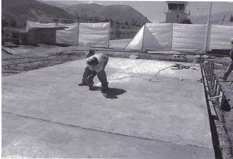
Foto 3.69 Cortado del Pavimento de Concreto
