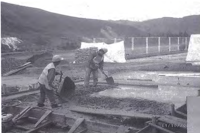
Foto 3.67 Vaciado de Losa de Concreto
