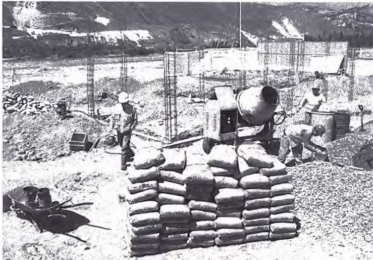
Foto 3.09 Preparación de Mezcla de Concreto
