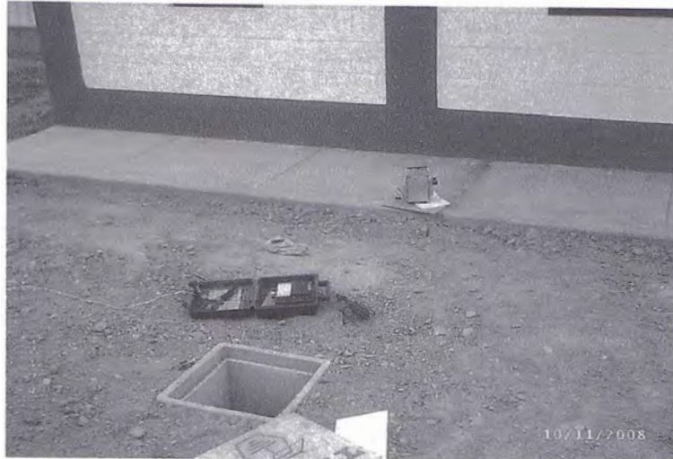
Foto 4.06 Medición de Puesta a Tierra
