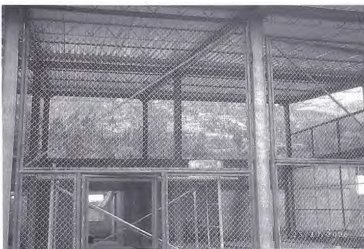
Foto 3.36 Puertas Metálicas Instaladas
