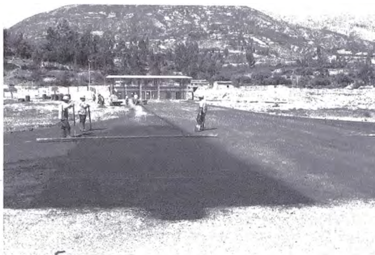
Foto 3.66 Colocación de Mezcla Asfáltica
