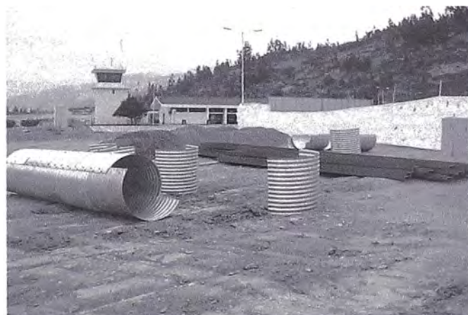
Foto 3.70 Alcantarilla Metálica
