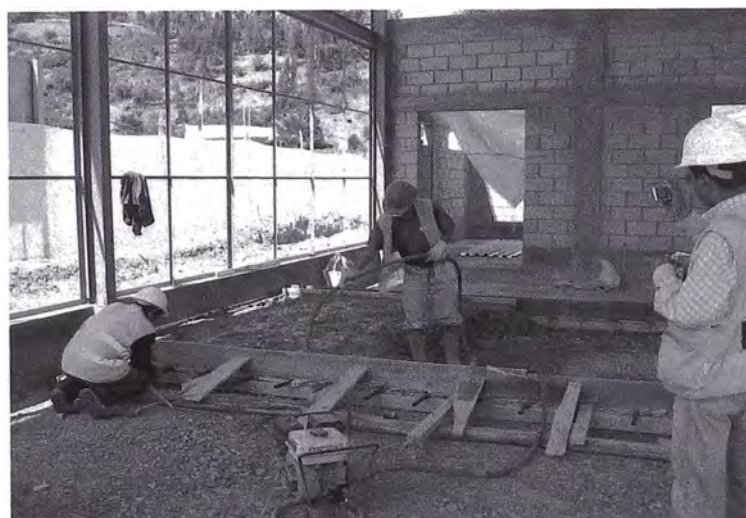
Foto 3.15 Vaciado de Losas de Concreto
