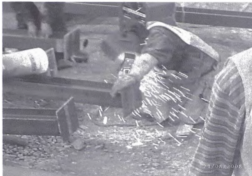
Foto 3.19 Soldando Bases de Columnas Metálicas
