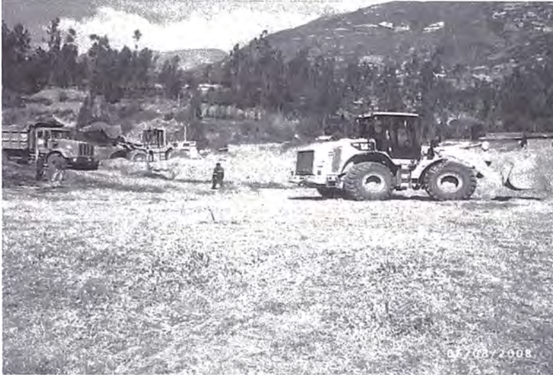
Foto 3.60 Corte del Terreno a nivel de Subrasante
