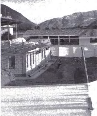
Foto 3.52 Relleno de Zanja Red Exterior Desagüe
