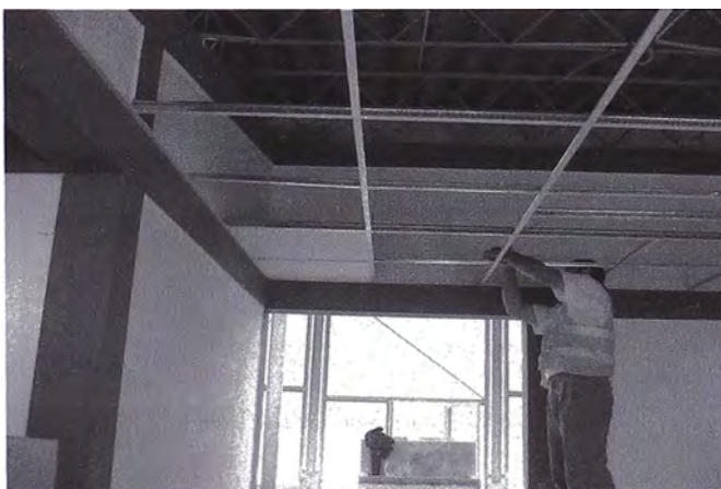
Foto 3.30 Instalación de Elementos de fijación de Cielo Raso
