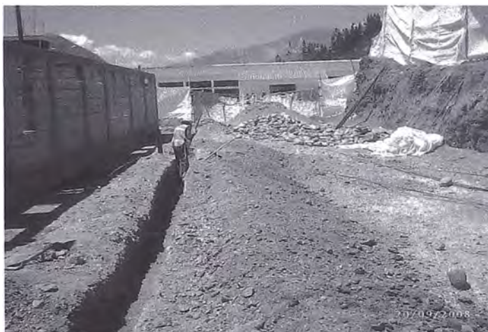
Foto 3.51 Excavación de Zanja para Instalación de Redes Exteriores de Desagüe
