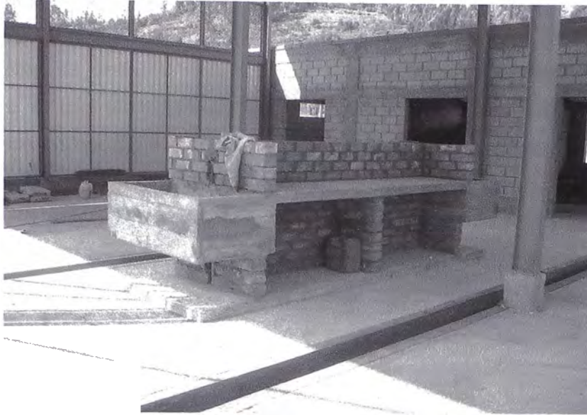
Foto 3.13 Mueble de Albañilería y Concreto
