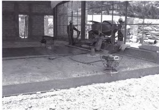
Foto 3.17 Losas de Concreto Zona de Estacionamiento
