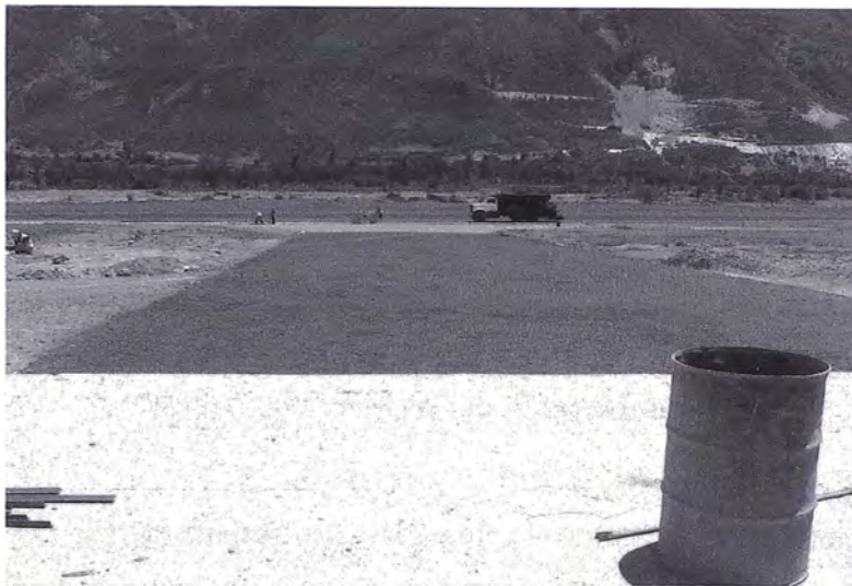
Foto 3.65 Imprimación Asfáltica
