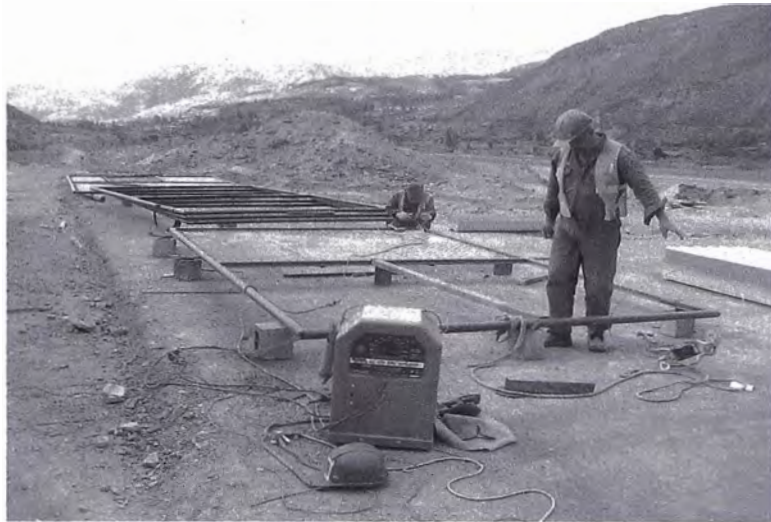
Foto 3.35 Fabricación de Puertas Metálicas
