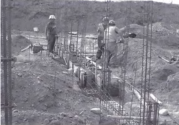
3.10 Vigas de Cimentación
