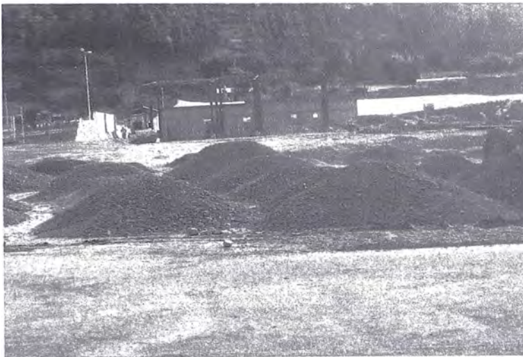
Foto 3.62 Acopio de material granular
