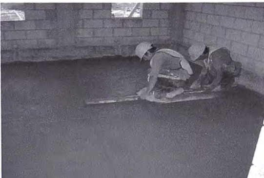
Foto 3.32 Piso de Cemento Frotachado
