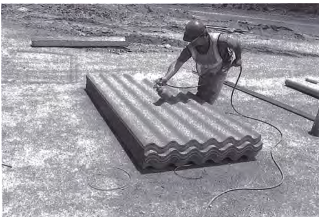
Foto 3.48 Pintado de Planchas Eternit
