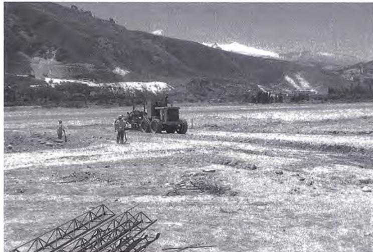
Foto 3.61 Conformación de la Subrasante
