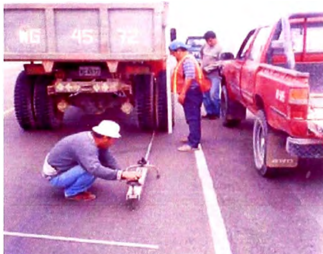
Figura 2.01 Empleo de la viga Benkelman
