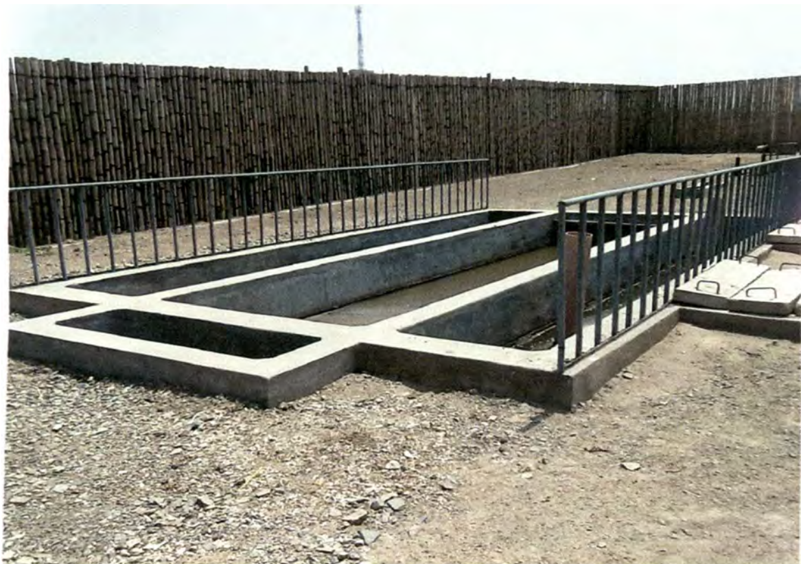
Fotografía N° 08: Tanque Imhoff
