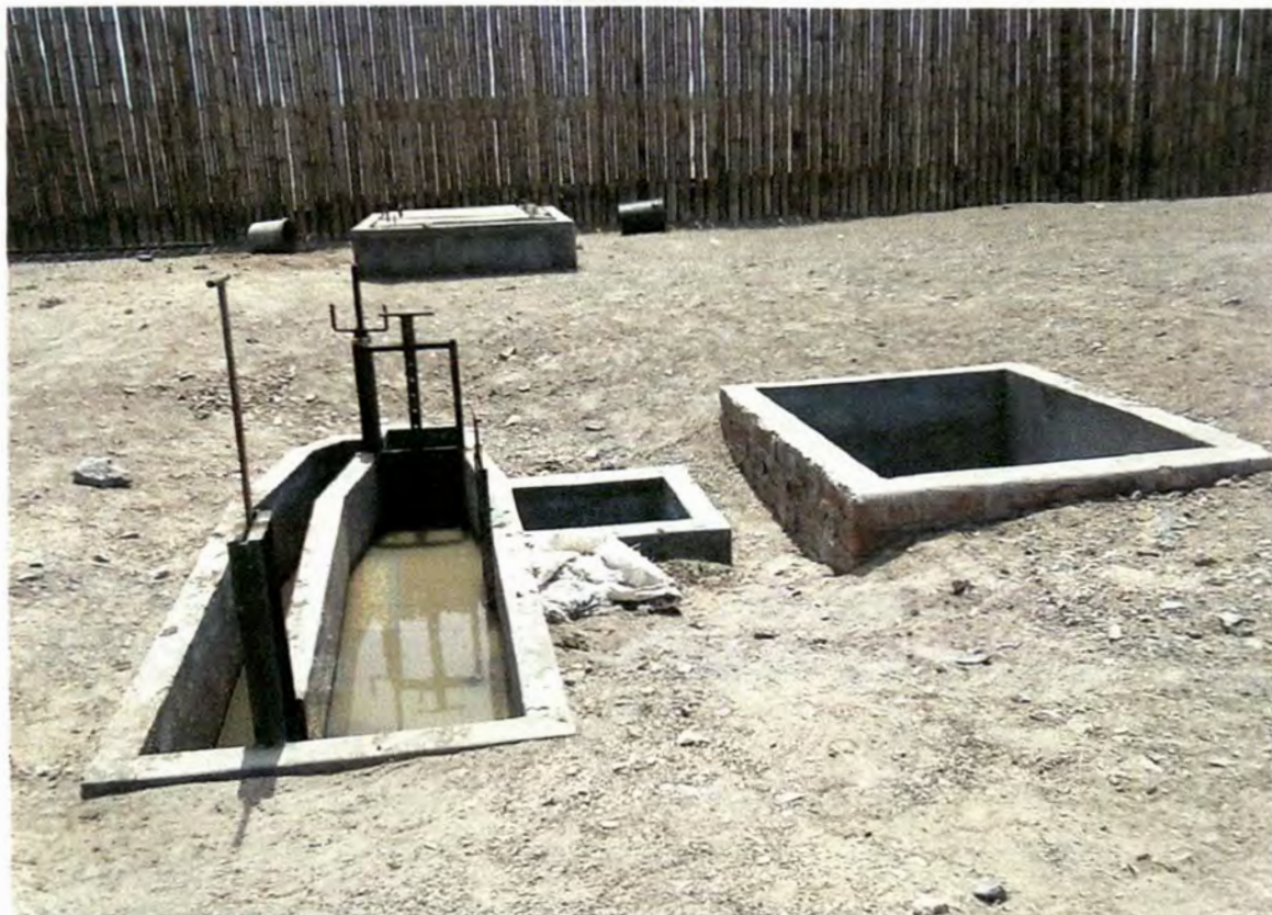
Fotografía N° 06: Desarenador
