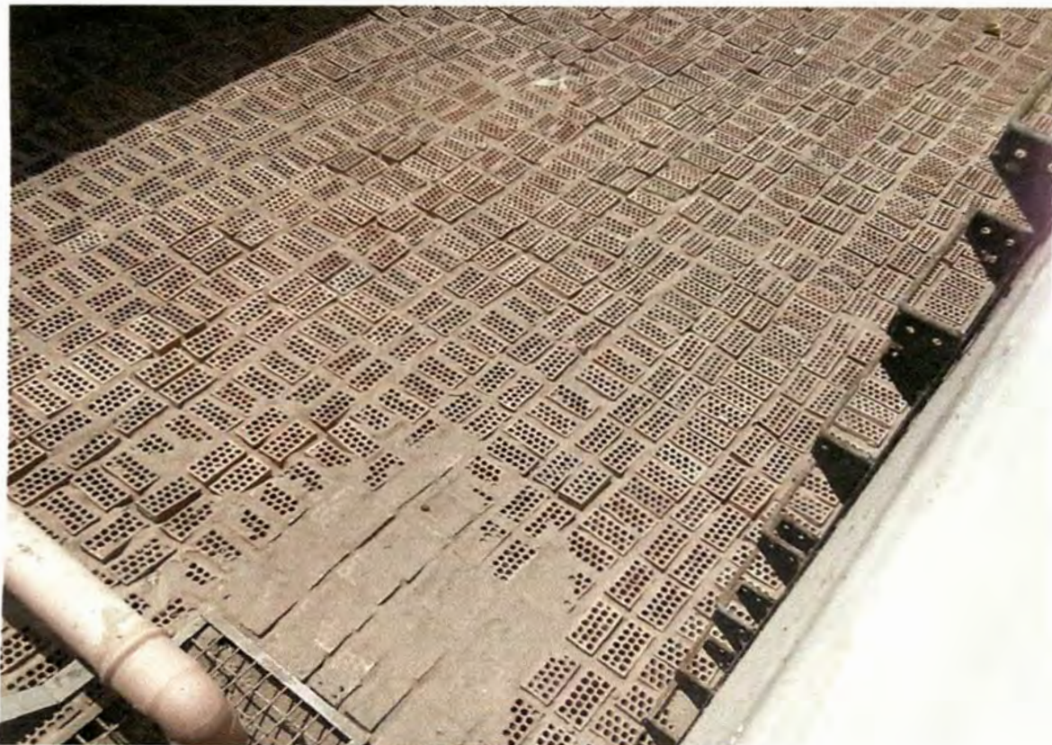
Fotografía N° 09: Lecho de Secados
