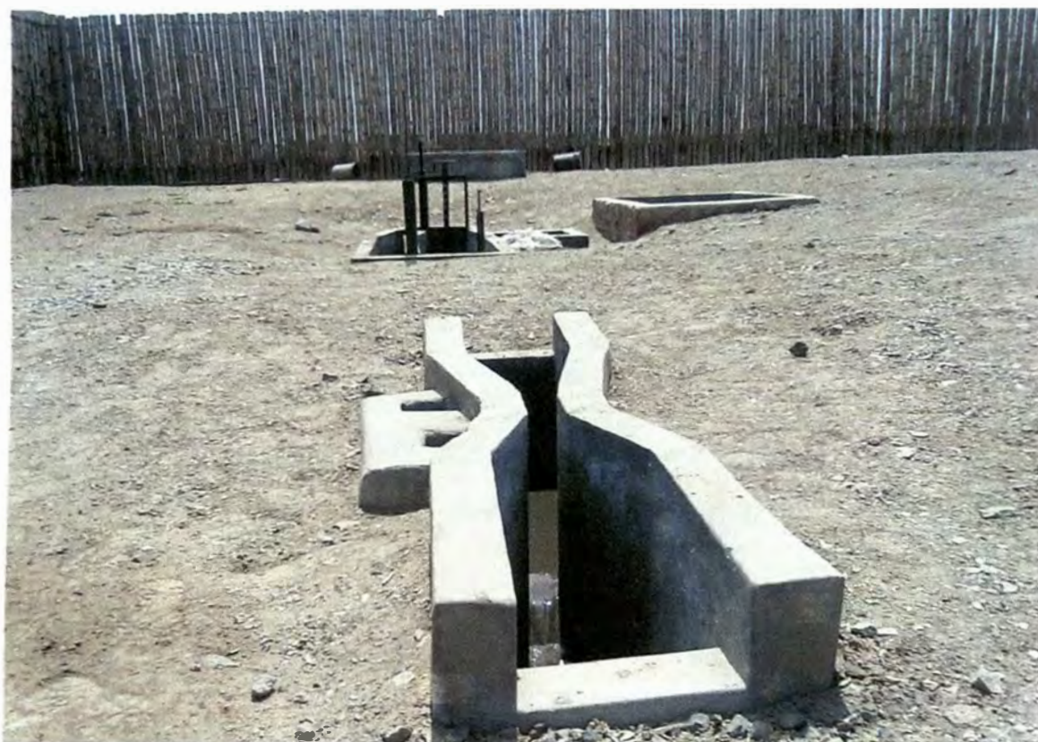
Fotografía N° 07: Medidor Parshall
