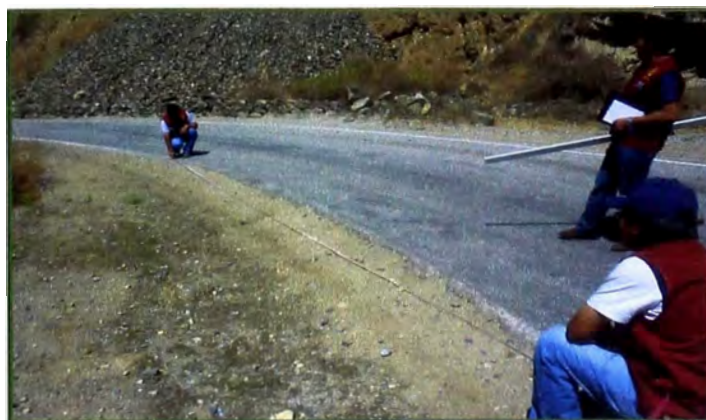
Figura N° 5.05 Falla de Borde.
