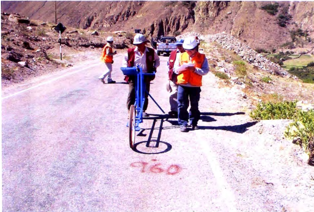
Foto N° 9: Evaluación de la rugosidad con el equipo MERLIN en el subtramo Km. 116+00 al Km. 115+600.
