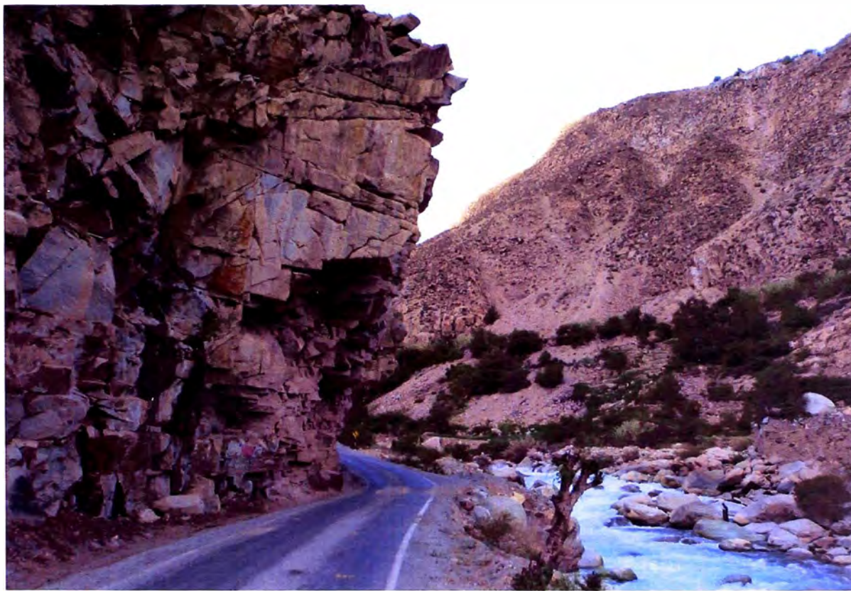
Figura N° 1.02: Vista de la plataforma de la carretera, la cual está ubicada a la margen derecha del río Cañete.
