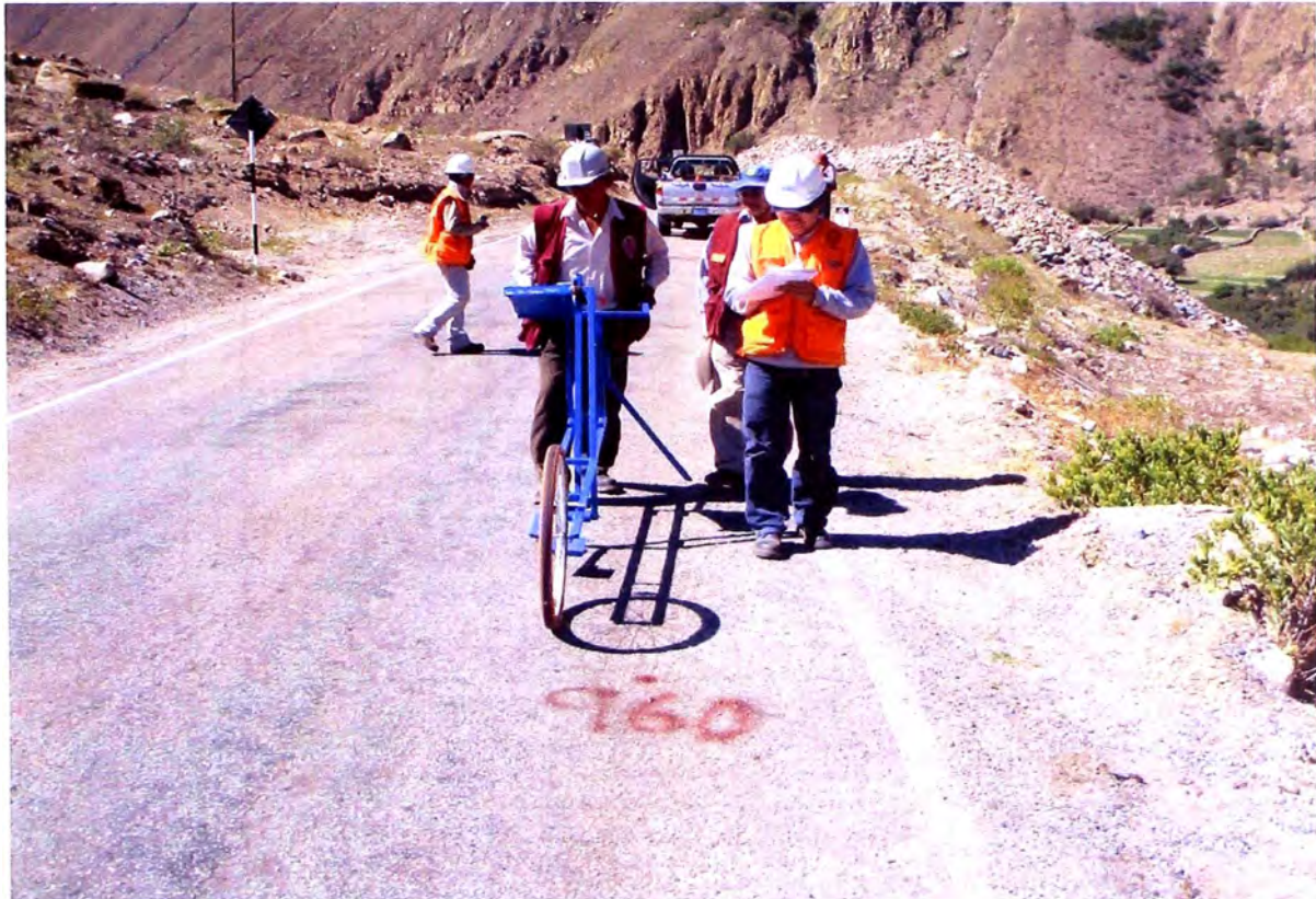
Figura N° 3.02: Vista de la toma de datos con el equipo MERLIN en el sub tramo Km. 116+000 al Km. 115+600.
