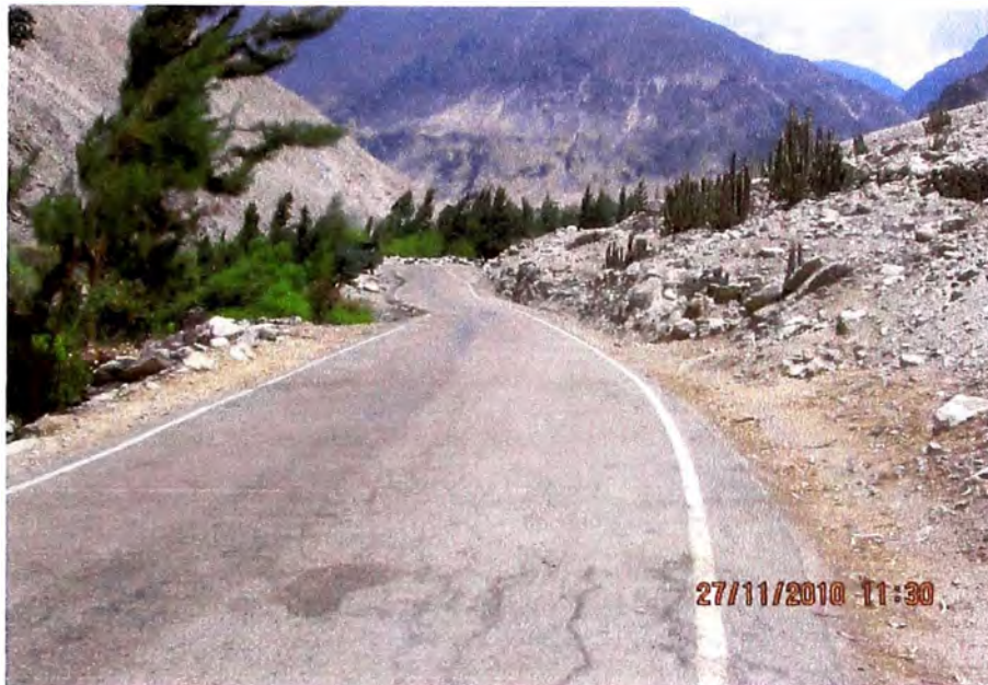
Fig. 5.13: Fotografía de la progresiva Km 76+500, se observa la variación de los anchos de la carretera, esto puede ocasionar accidentes.
