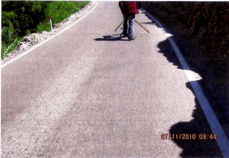
Fig. 5.11: Fotografía de la progresiva Km 75+400, se observa que la carpeta de rodadura está en buen estado, esto se comprueba con los datos obtenidos.
