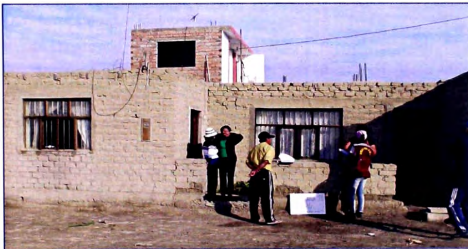
Figura No 3.3 Vivienda Típica de adobe de 1 piso
