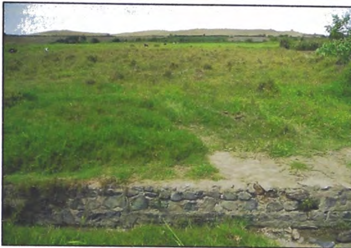
Figura N° 30: Vista panorámica de la zona de emplazamiento de la galería
