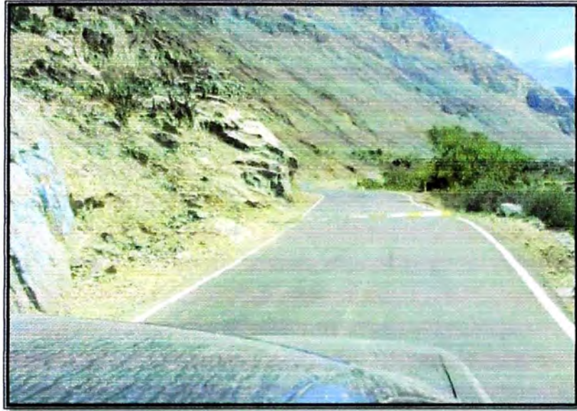
Presencia de Gibas en partes de las Vías, dificultan la medición.
