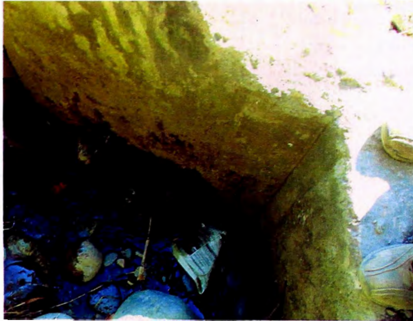
Foto N° A.9 – Alcantarilla km34+329
