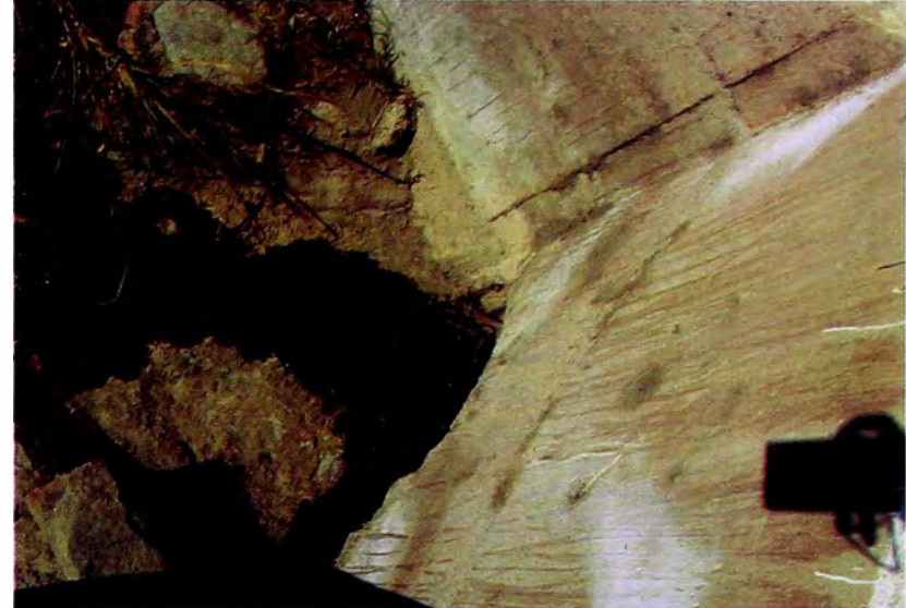
Foto N° A.6 – Alcantarilla km33+581
