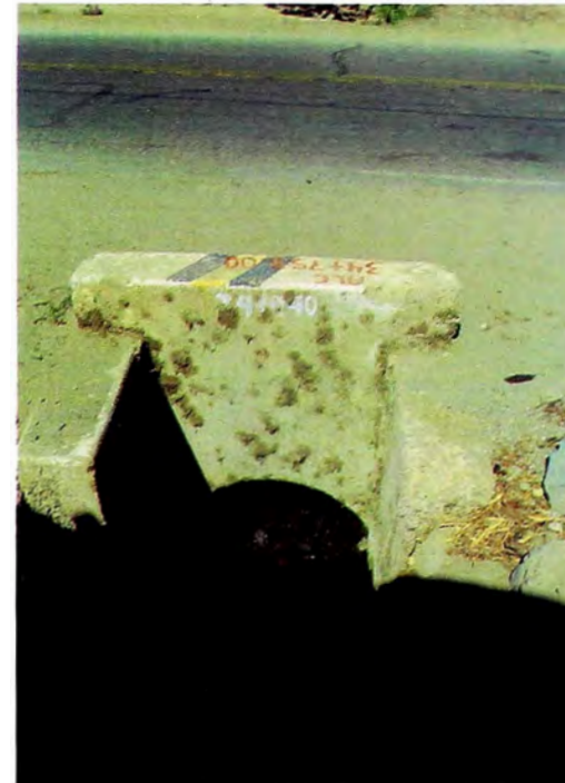
Foto N° A.12 – Alcantarilla km34+625
