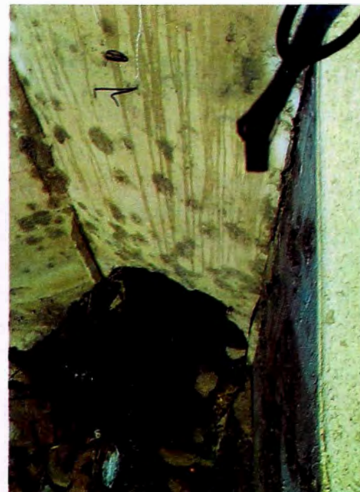
Foto N° A.8 – Alcantarilla km34+026 (salida)
