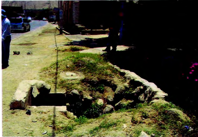
Foto N° A.5 – Alcantarilla km33+405
