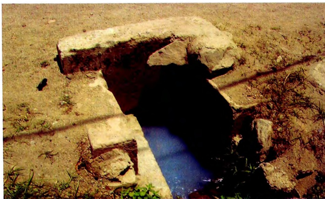
Foto N° 3.1. km 33 + 405 se puede apreciar la alcantarilla transportando agua residual proveniente de las zonas urbanas existentes a lo largo de la vía.
