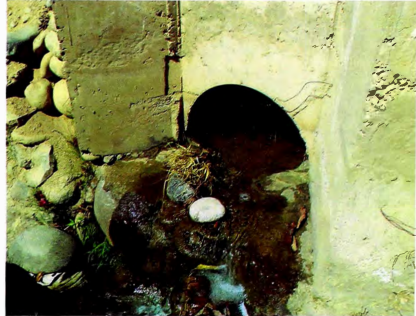
Foto N° A.10 – Alcantarilla km34+456
