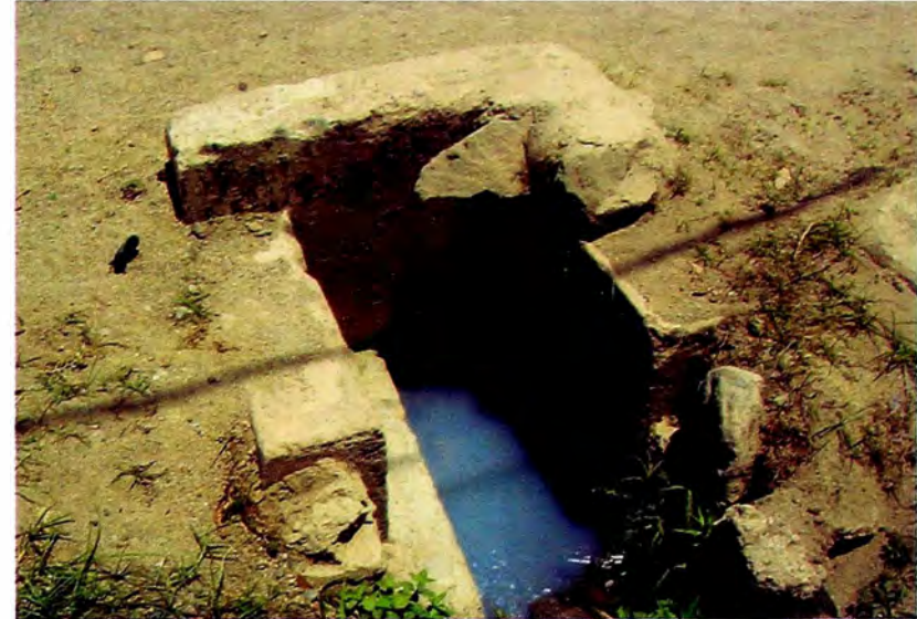
Foto N° A.4 – Alcantarilla km33+405
