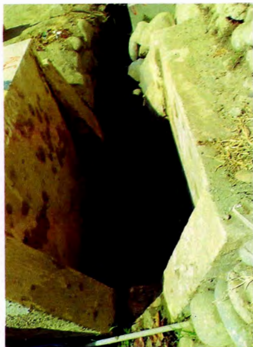
Foto N° A.7 – Alcantarilla km34+026 (entrada)
