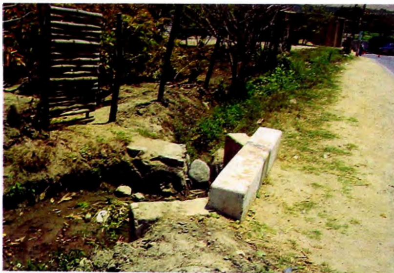
Foto N° A.1 – Alcantarilla km33+144
