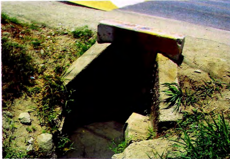
Foto N° A.3 – Alcantarilla km33+355
