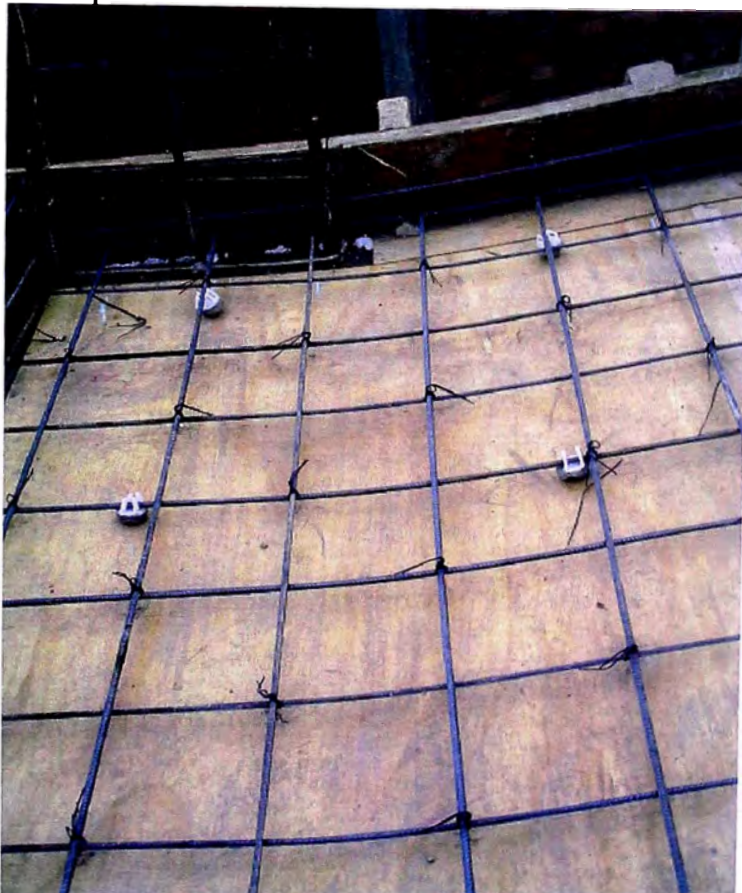
Fotografía N° 06. Colocado de separadores en losa. Garantizando el recubrimiento. Ver Fig. N° 18.
