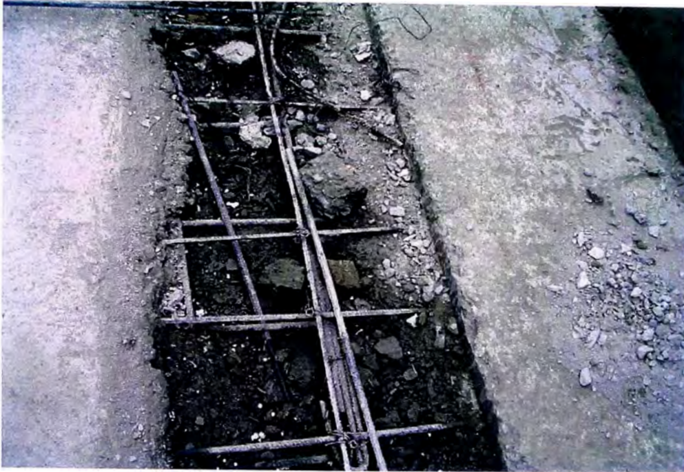
Fotografía N° 01. Junta dejada para la dilatación del concreto. Ver Plan Constructivo .
