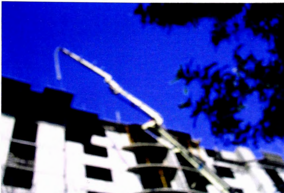
Fotografía N° 13. Vaciado de concreto en el piso 11.Losa
