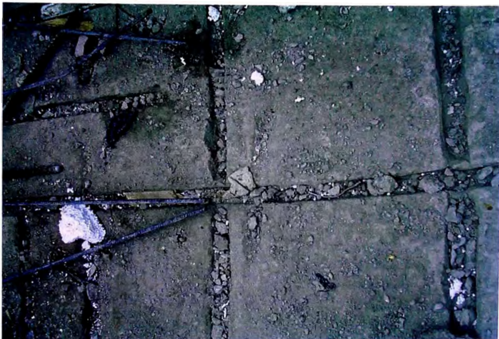
Fotografía N° 01. Junta dejada para la dilatación del concreto. Ver Plan Constructivo .
