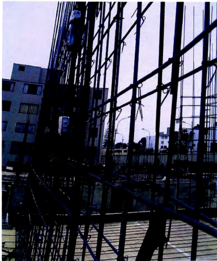
Fotografía N° 10. Detalle de la colocación del "Abridor". Se observa que envuelve al refuerzo. Ver Fig. N° 27
