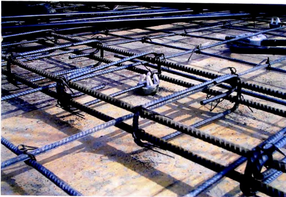
Fotografía N° 11. Detalle de amarre entre el acero de la losa y la viga. Observe como el refuerzo se ubica entre las varillas de la viga. Ver Fig. N° 29
