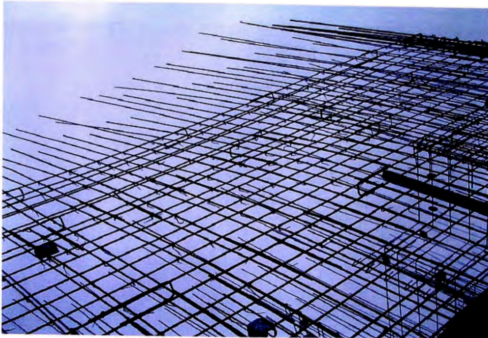
Fotografía N° 07.- Placa 4. Vista del colocado del “abridores”. Ver Fig. N° 27
