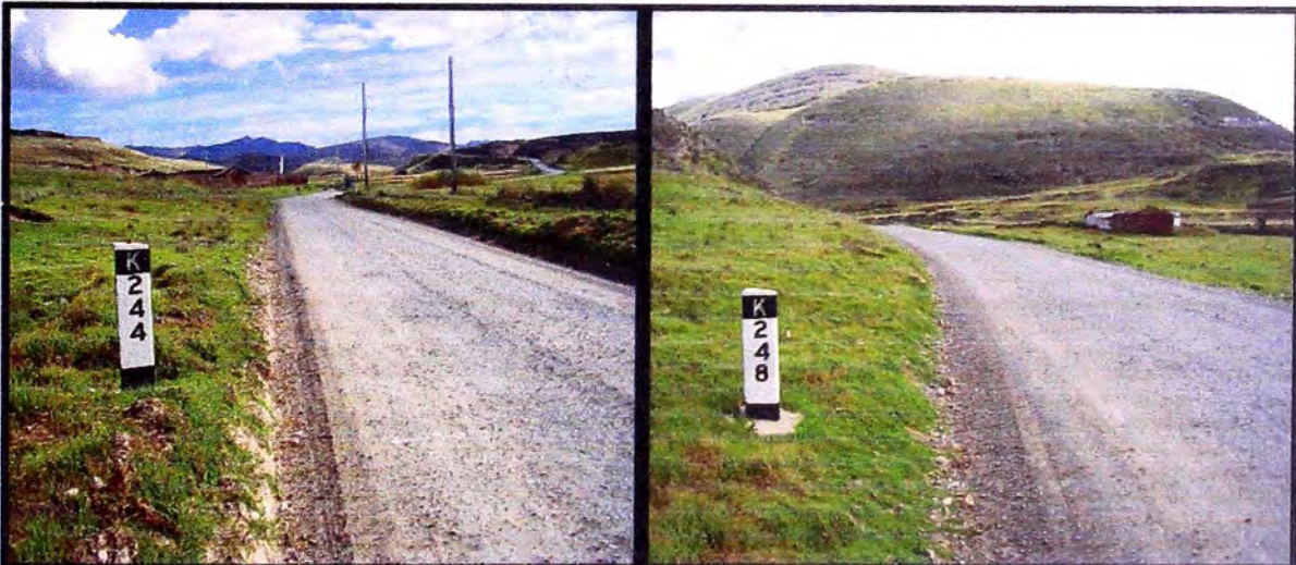
Foto N°3: Superficie de Rodadura Km.244+000
