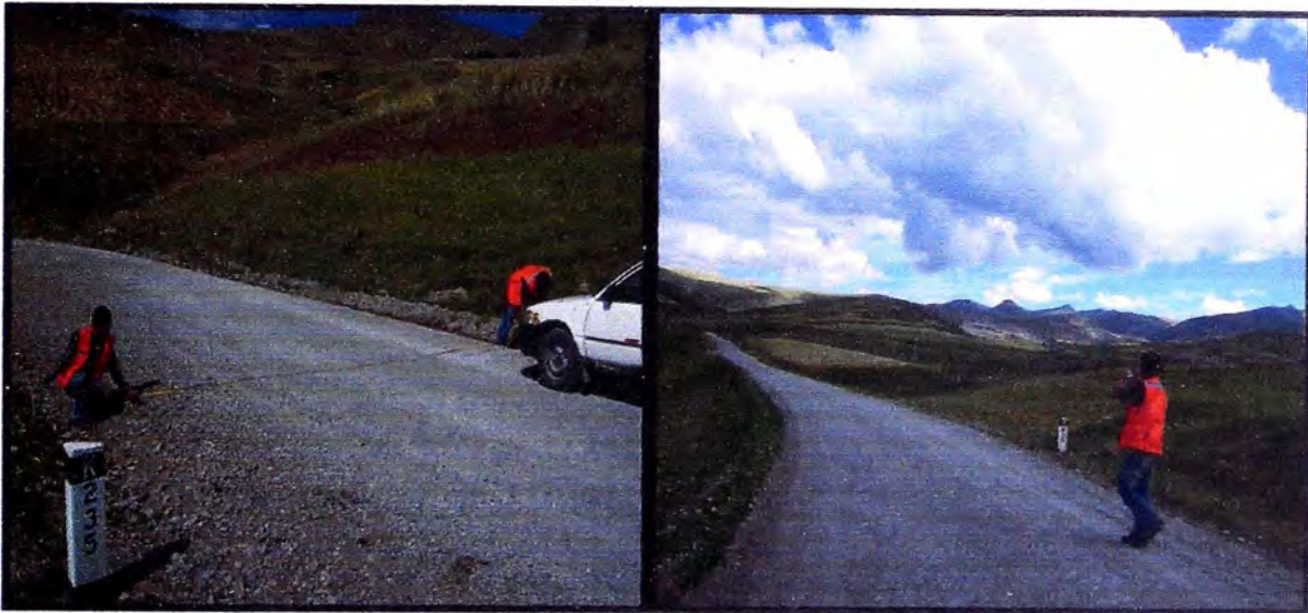
Foto N°1: Superficie de Rodadura Km.235+000
