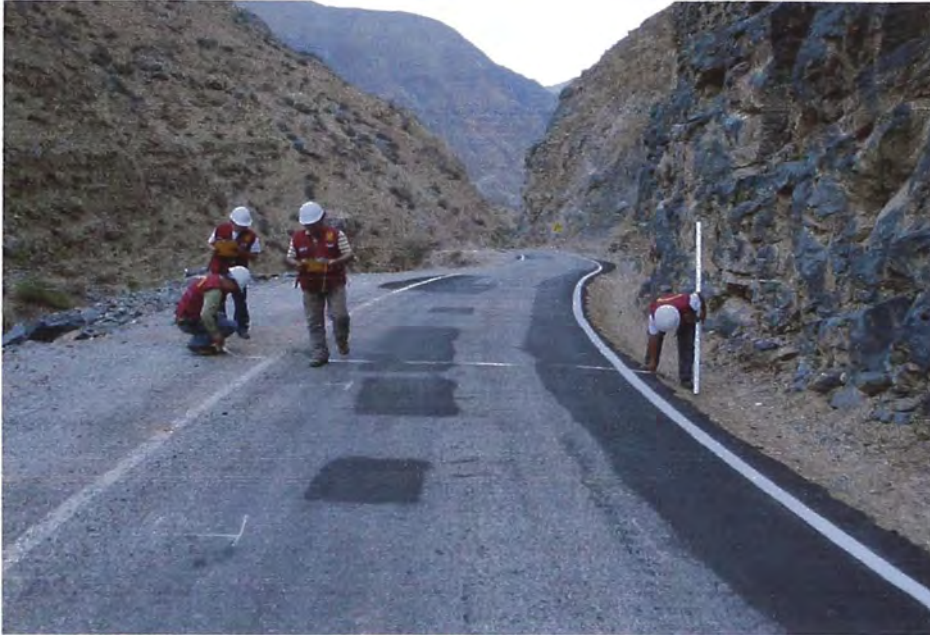
Fotografía N° 3.05: Bacheo y reparación de zanjas.
