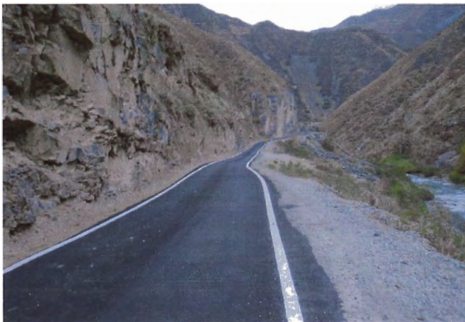
Fotografía N° 3.04: Vía totalmente reparada.
