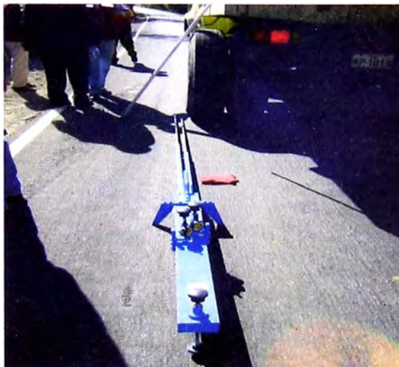
Figura N°3.01: Equipo Viga Benkelman
