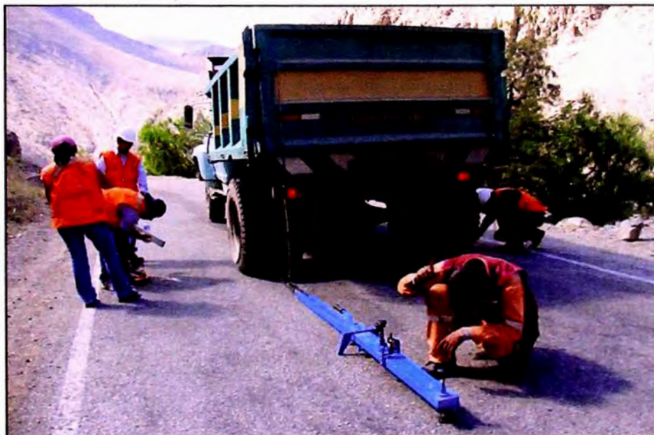
Foto N° 19: Superficie de rodadura - Km 109+600
