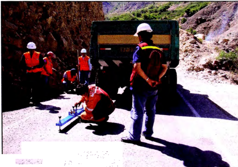
Foto N°3.8: Toma de datos con la Viga Benkelman
