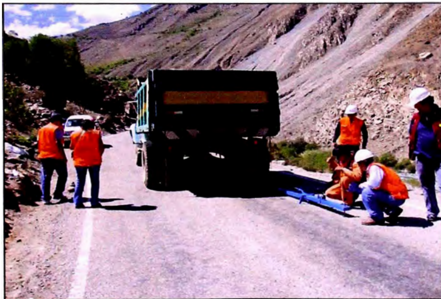
Foto N° 13: Superficie de rodadura - Km 108+400
