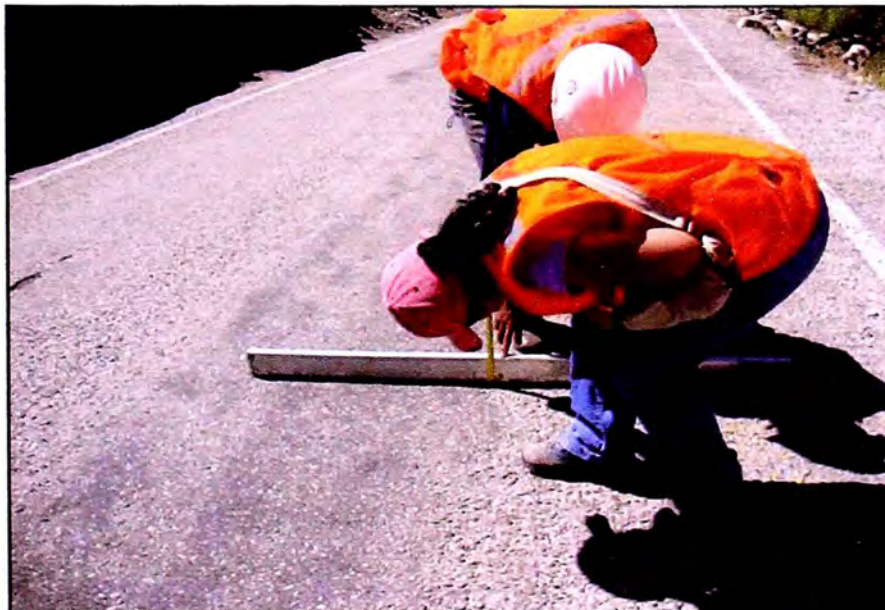
Foto N° 3.11: Lectura de Ahuellamiento
