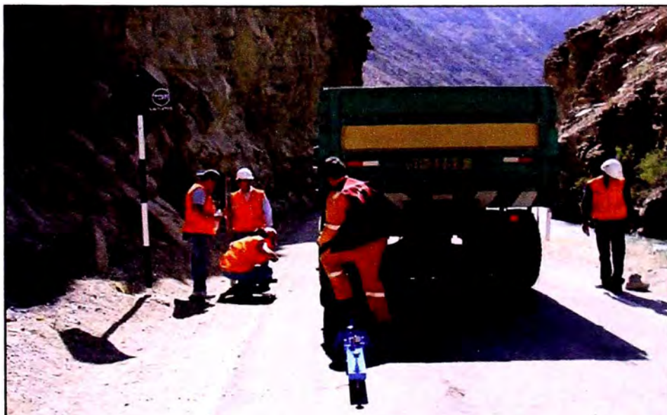
Foto N° 17: Superficie de rodadura - Km 109+200
