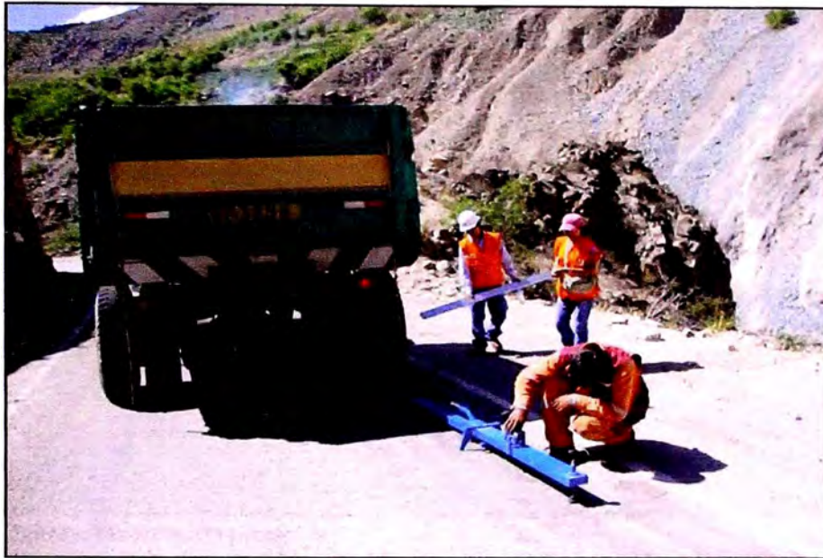
Foto N° 14: Superficie de rodadura - Km 108+600
