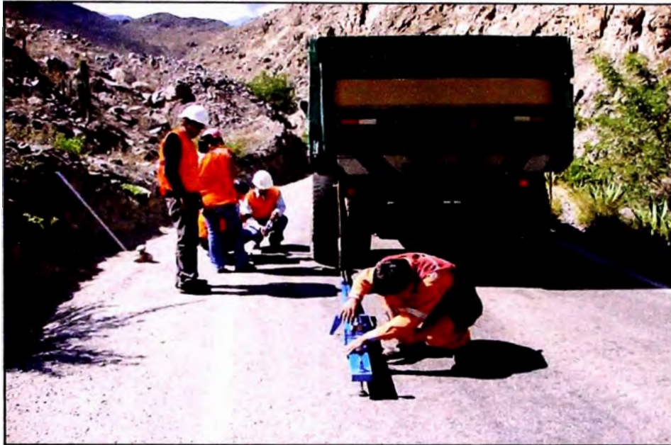
Foto N° 20: Superficie de rodadura - Km 109+800
