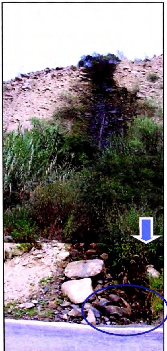
Foto N°2.4: Caída natural de agua – Drenaje
