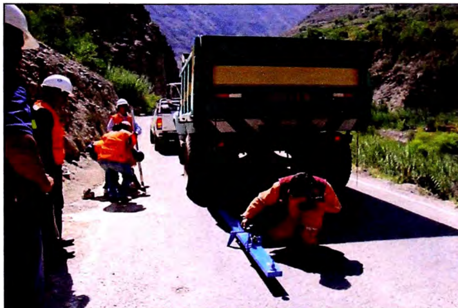
Foto N° 15: Superficie de rodadura - Km 108+800
