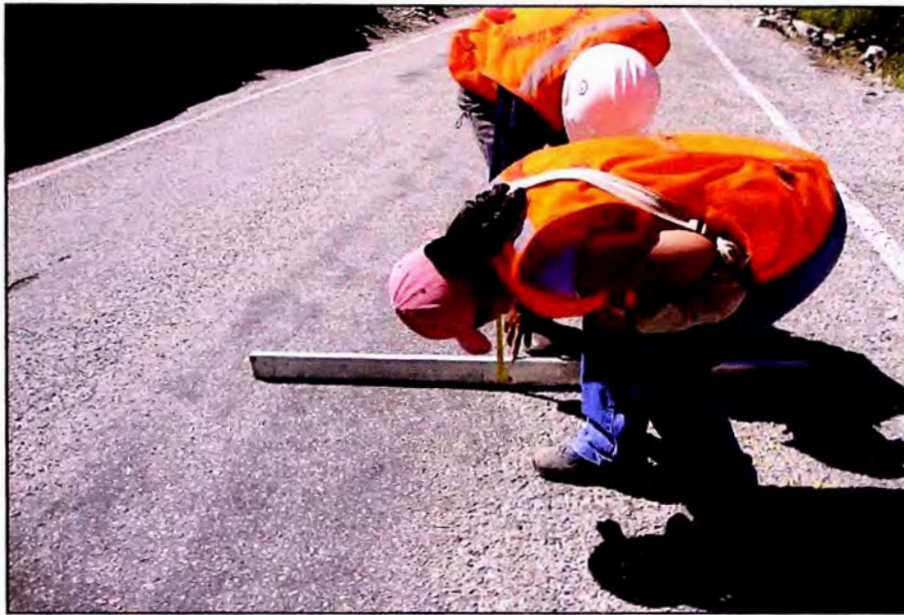
Foto N° 12: Superficie de rodadura - Km 108+200
