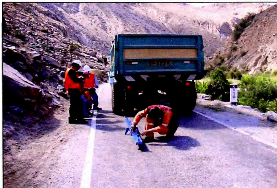
Foto N° 21: Superficie de rodadura - Km 110+000
