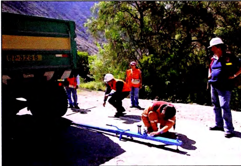
Foto N°3.9: Instalación del instrumento
