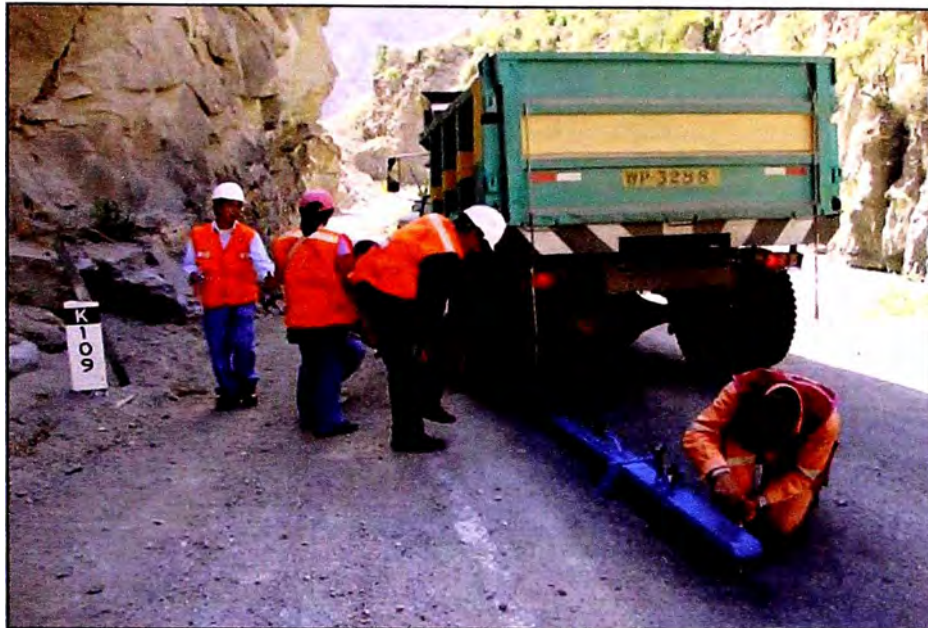
Foto N° 16: Superficie de rodadura - Km 109+000
