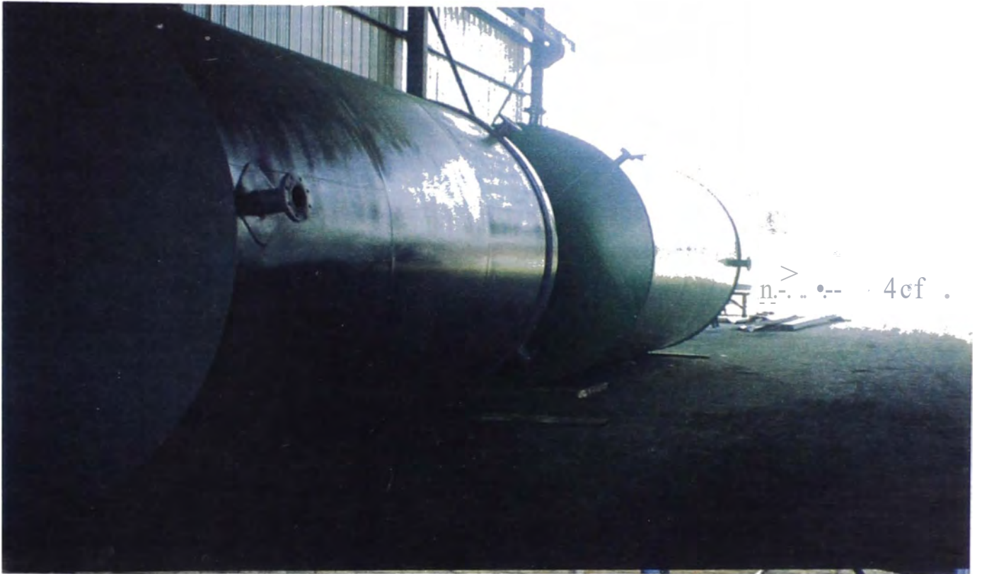
Figura N° 17 Pintado Exterior de Tanques para Combustible Sistema: Zinc - Epoxi / Poliamida
