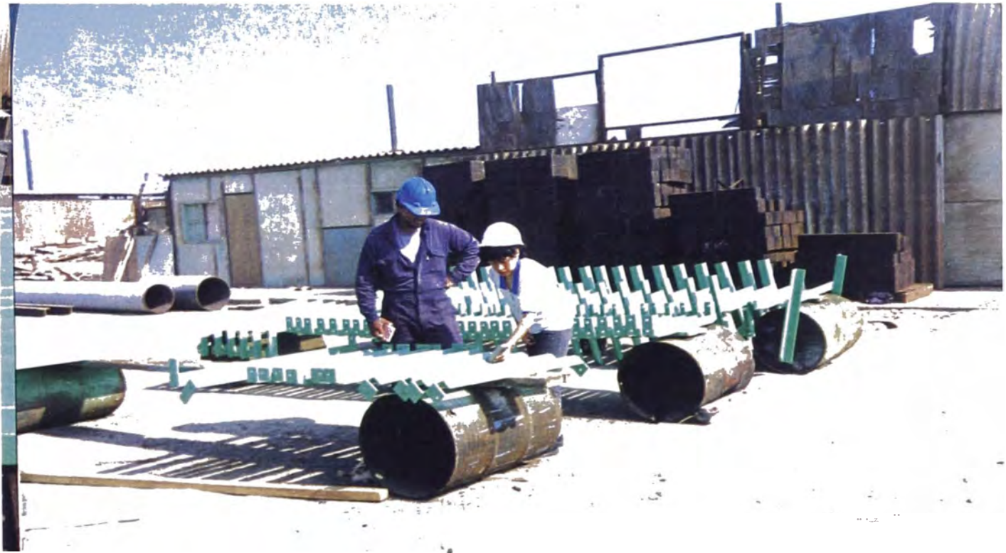
Figuras N° 20 y 21 Supervisión Técnica - Medición del Espesor de Película Seca
