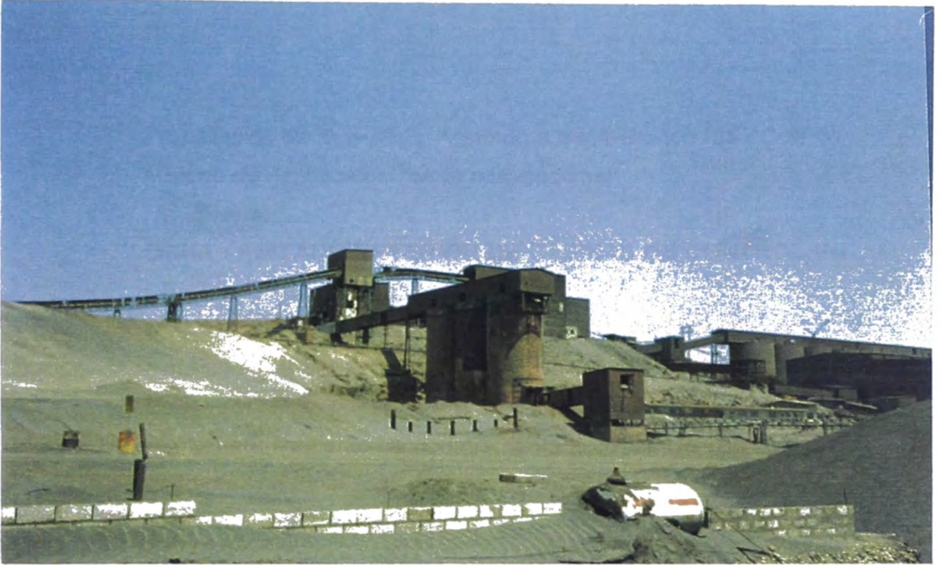
Figura N° 15 Pintado Obra: Fajas Transportadoras - SHOUGANG PERU Pto. San Andrés de Marcena
