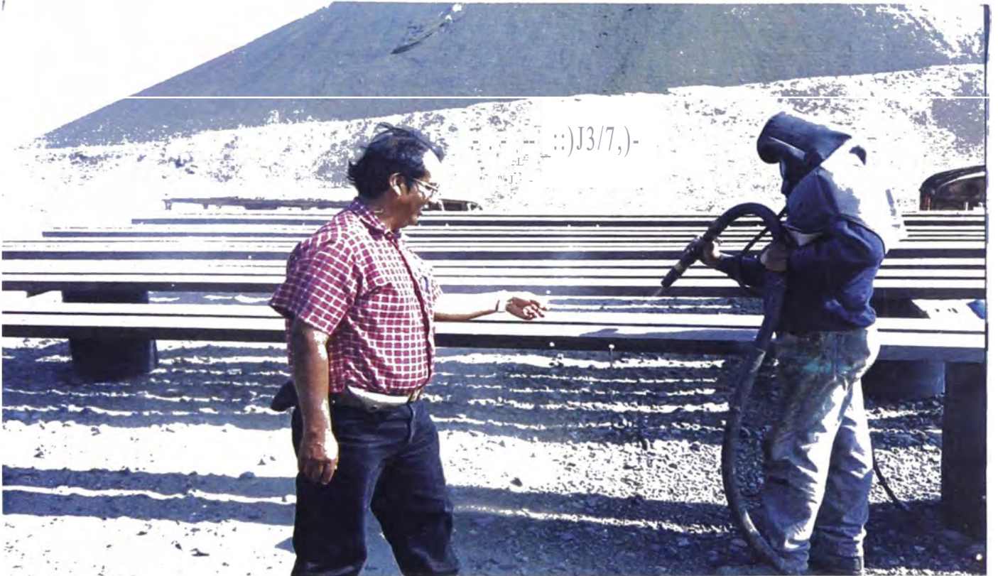
Figuras N° 18 y 19 Supervisión Técnica de la Preparación de Superficie
