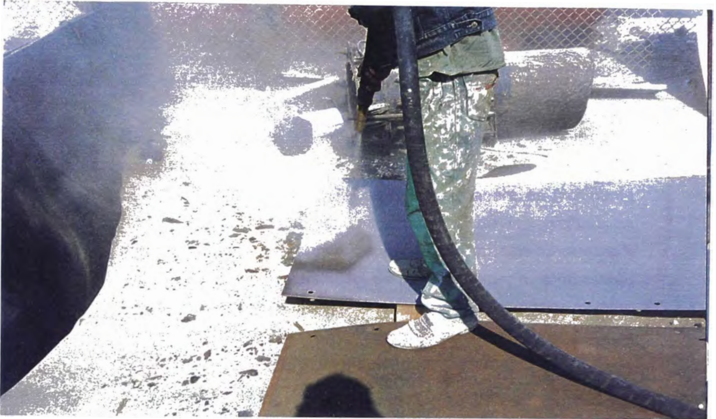
Figura N° 13 Preparación de Superficie - Limpieza Arenado a Metal Blanco SSPC-SP10
