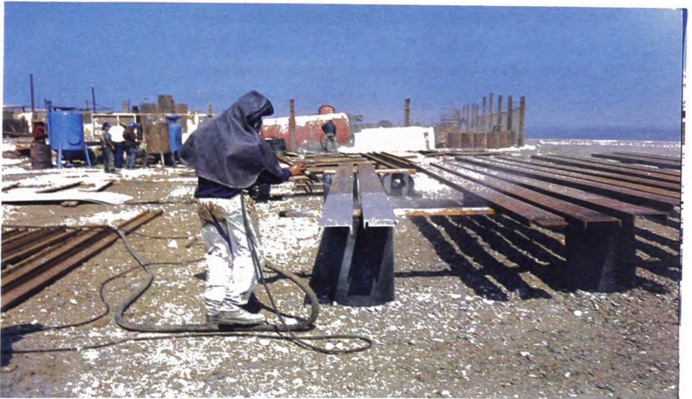
Figura N° 14 Limpieza de vigas metálicas - SHOUGANG San Andrés de Marcona
