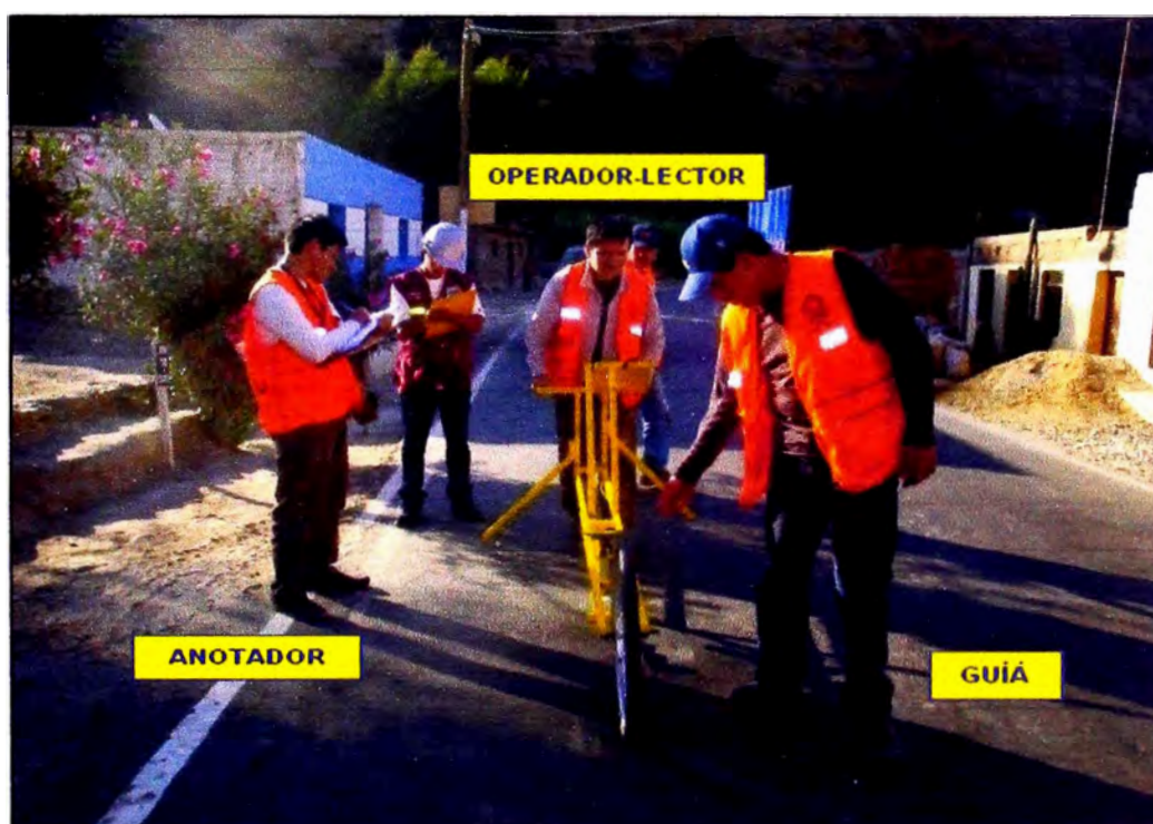
Figura N° 3.9 Ejecución del ensayo con equipo MERLIN
