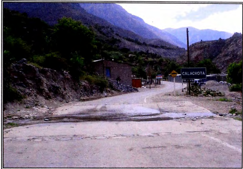
FOTO 09: Se observa estructura de baden, en la progresiva Km. 106+775.
