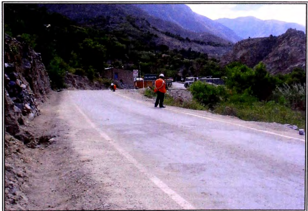
FOTO 10: Se observa dren natural con material filtrante, Km. 106+740.
