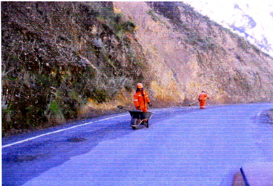
FOTO 04: Labores a Mantenimiento
