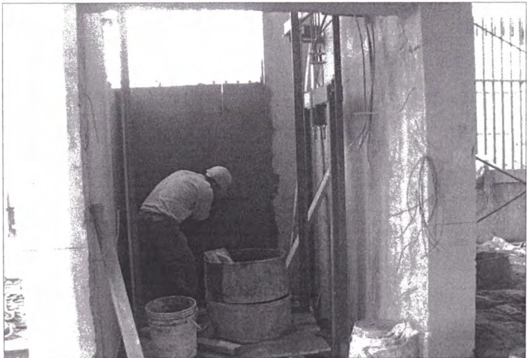
Foto N° 09 Vista de Tarrajeo de Muros
