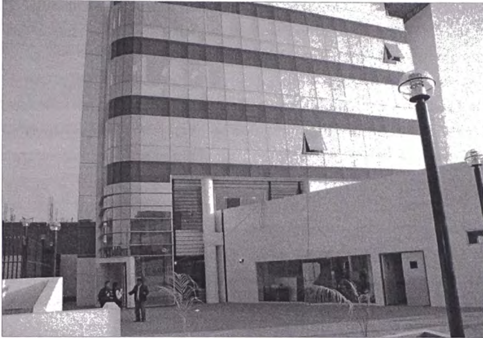
Foto N° 14 Vista de la edificación
