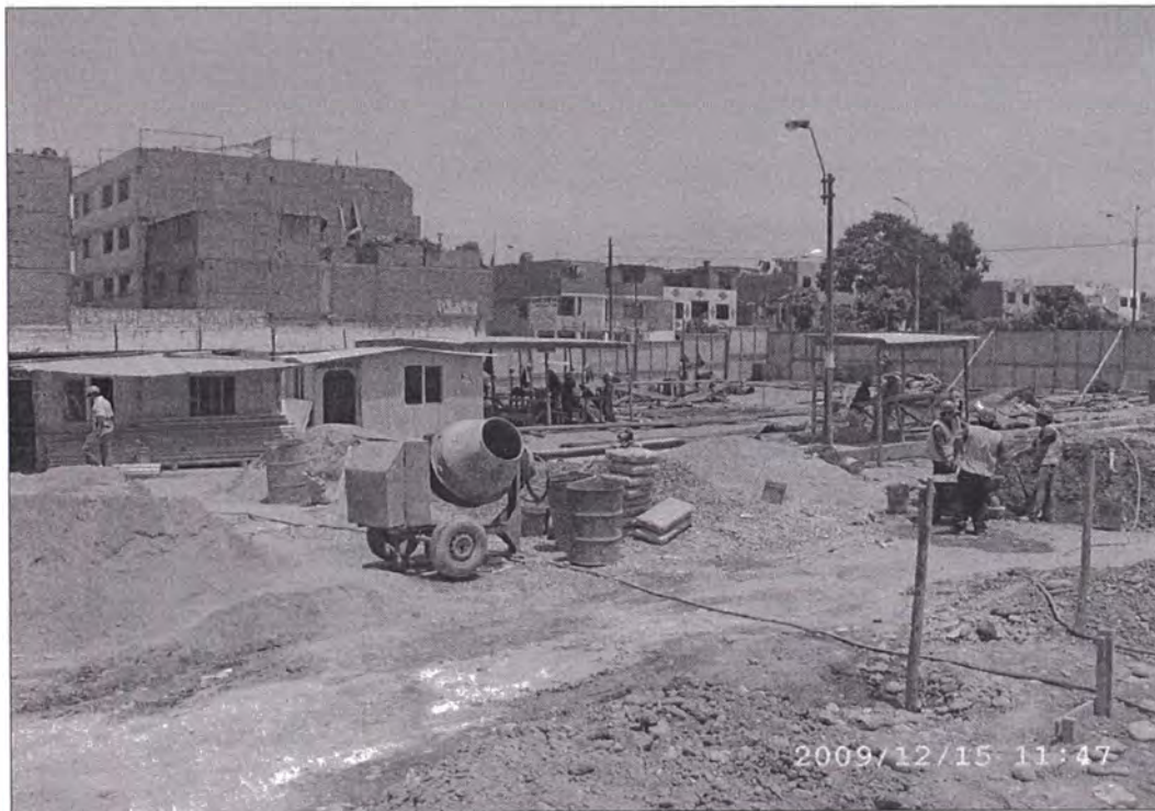
Foto N° 01 - Vista de las oficinas del Residente, Supervisor y Almacén.
