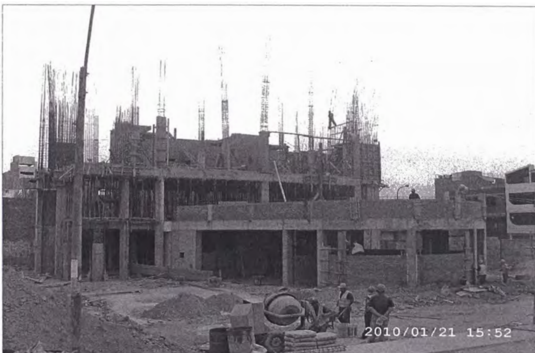
Foto N° 05 - Vista de la Construcción de muros de Albañilería.
