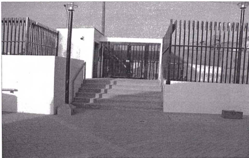
Foto N° 11 Vista del Piso de Adoquín en el Ingreso Principal
