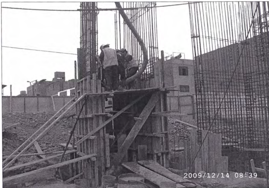
Foto N° 03 – Vista de Vaciado de concreto premezclado en placas
