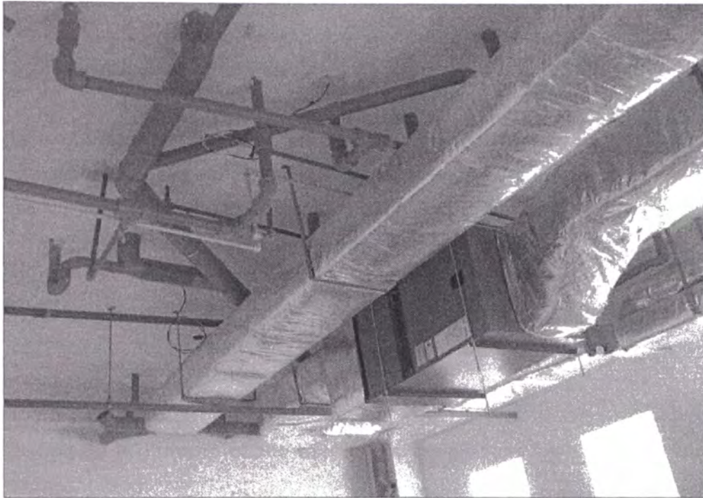
Foto N° 07 – Vista de Instalaciones Sanitarias (montaje de desagüe)
