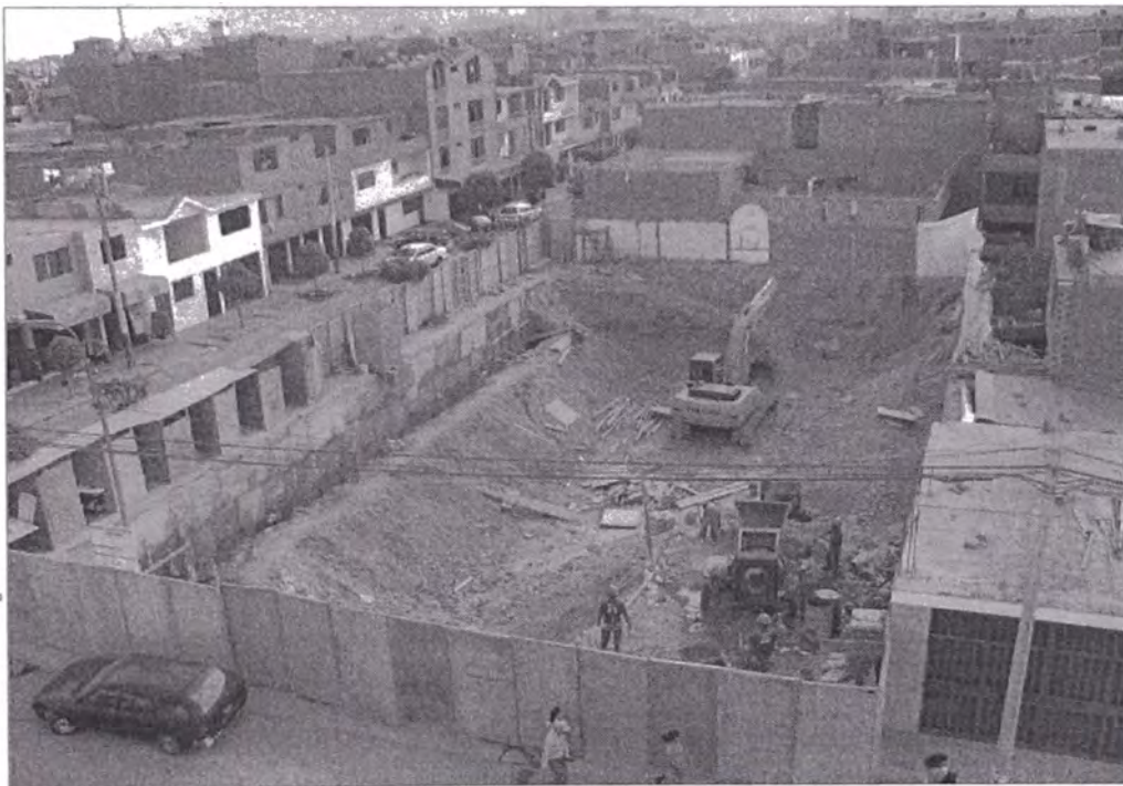
Foto N° 02 - Vista de los trabajos de Excavación Masiva
