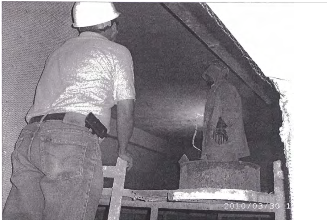
Foto N° 10 Vista de Tarrajeo de Cielorraso
