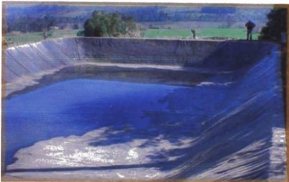
Figura N°4.16 Revestimiento de Laguna con Geomembrana
