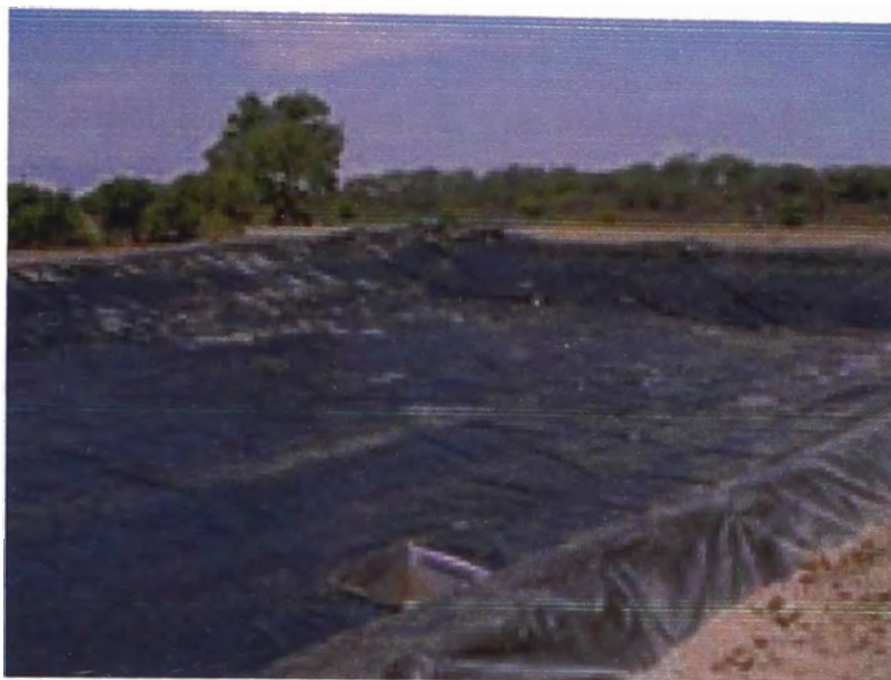
Figura N°4.15 Revestimiento del Talud y Fondo de laguna con Geomembrana
