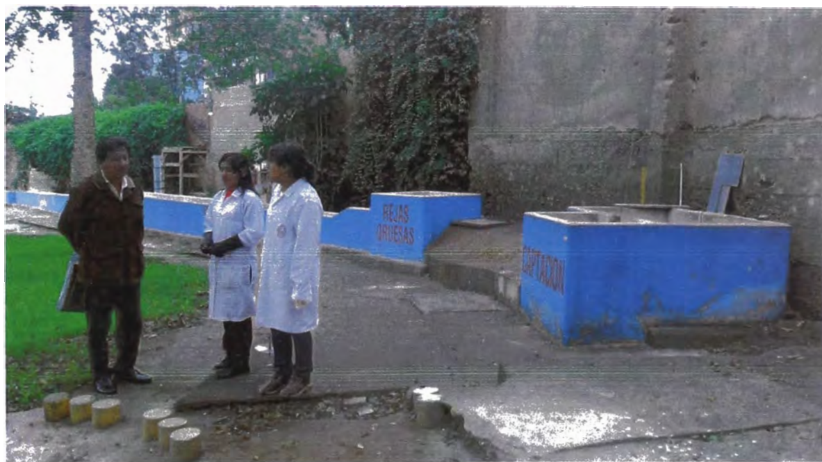
FOTO N° 6: VISITA AL PTAR - UNI, SISTEMA DE PRE TRATAMIENTO.
