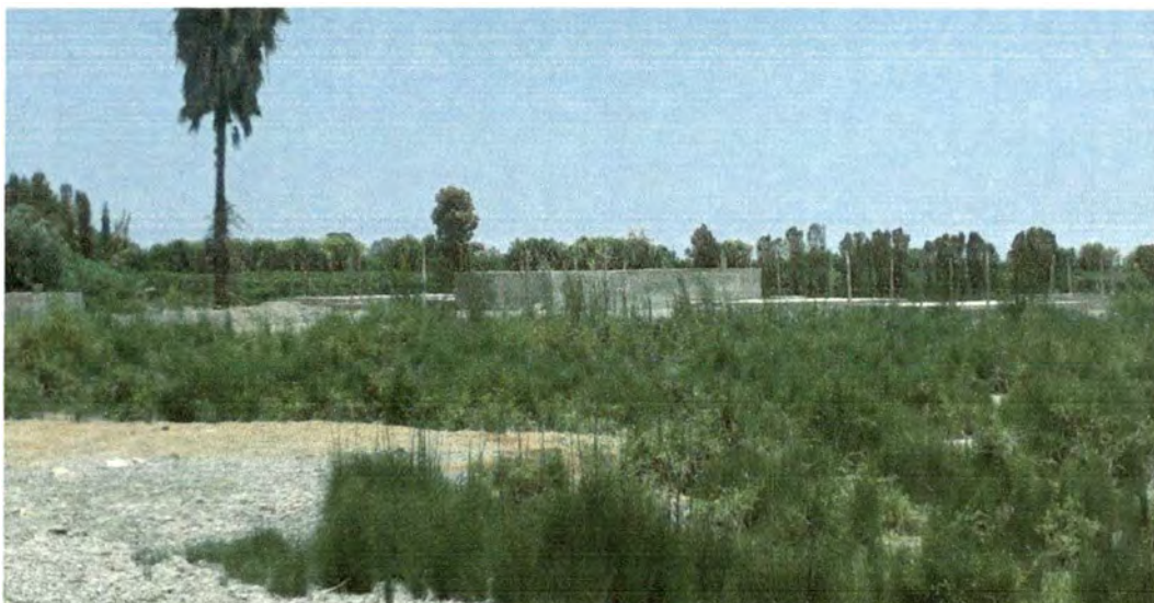
Foto N° 9: Planta de Tratamiento de Aguas Servidas.
