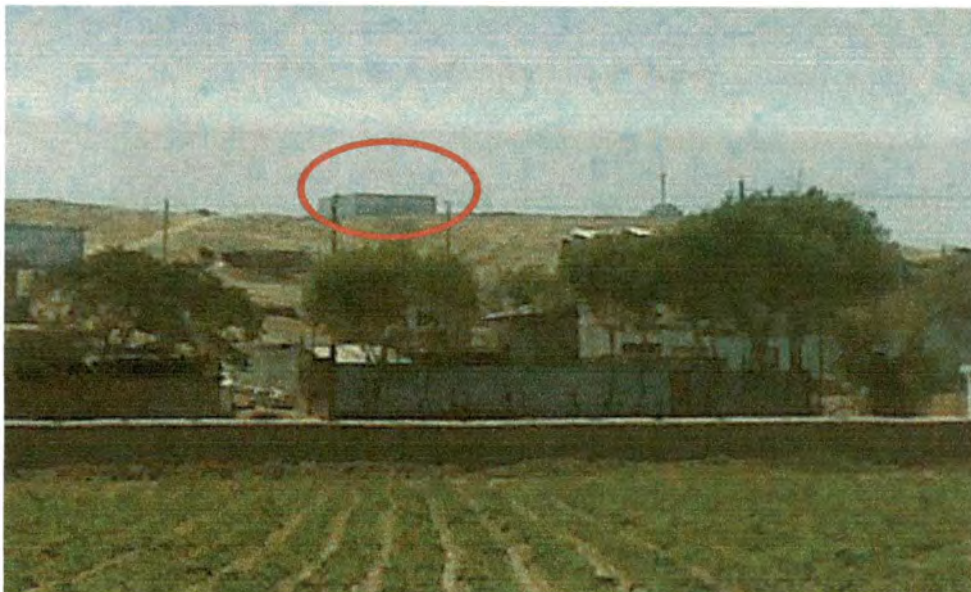
Foto N° 4: Reservorio de Almacenamiento de Agua Potable.
