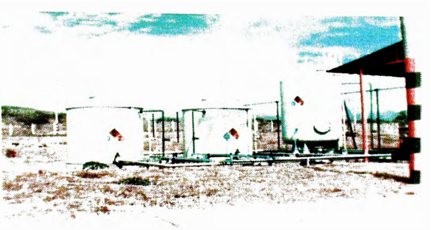
Tanques de almacenamiento de soda cáustica
