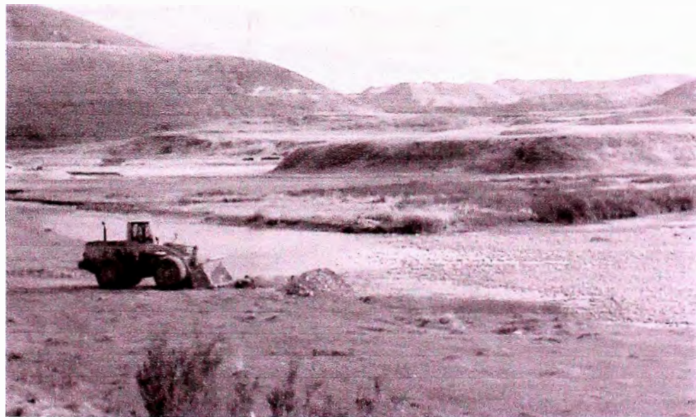
Foto N° 2: Vista panorámica de cantera Chupaca km 248+200
