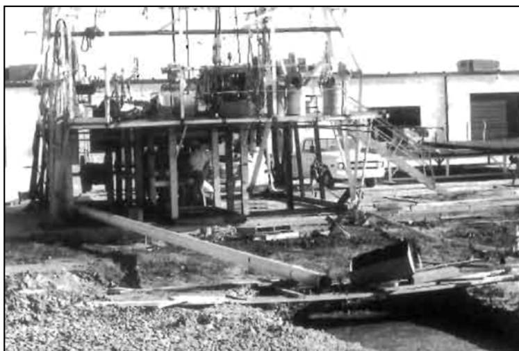
Figura 2 - 2. Salida del Lodo de Pozo a Superficie sin Equipos de Control de Sólidos
