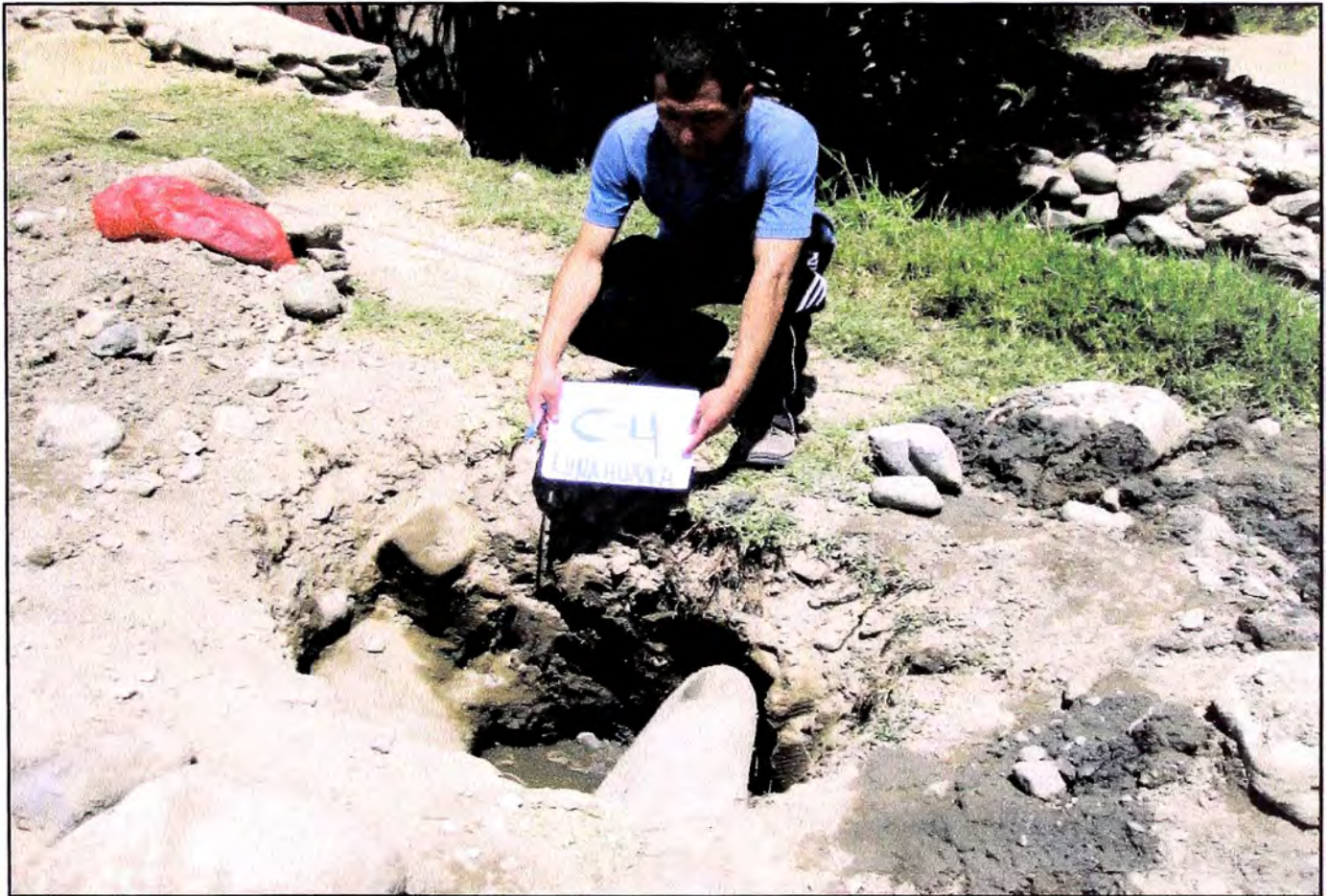
Foto N° 7: Se observa la Calicata C-4, de profundidad 1.50m, para la línea de distribución principal; presenta material grava limosa con bolonería de de 10"-15", también se observo presencia de agua ,donde su afloramiento es debido a un canal adyacente a la calicata.
