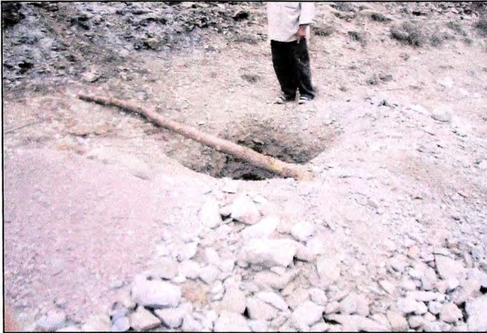
Foto N° 5: Se observa la calicata C-2, de profundidad 2.50m, para la estructura del reservorio apoyado; presencia de material coluvial con arenas mal gradadas, rocas fracturadas y angulosas, presencias de humedad en un lado de la calicata.
