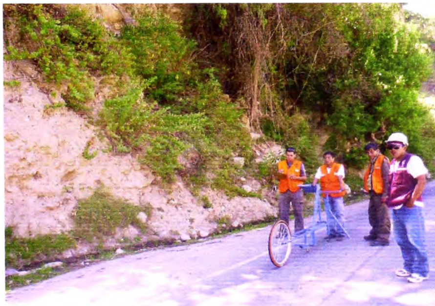
Foto N°2: Toma de datos sobre el ahuellamiento en el lado derecho de la vía.
