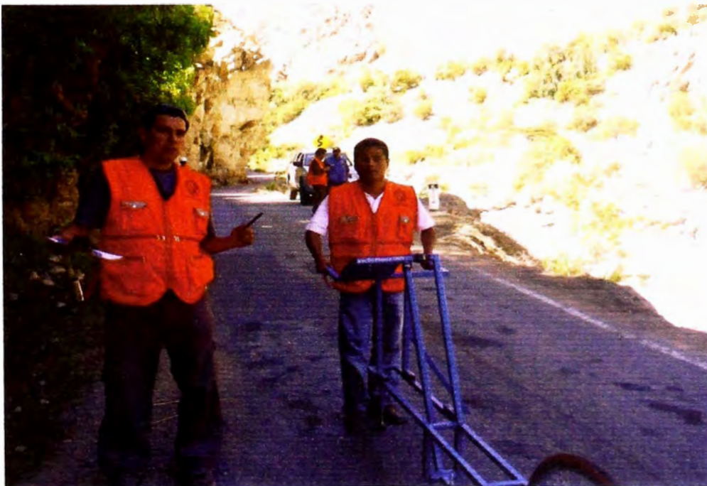
Fig. 3.02 Tramo representativo de la sección a evaluar (Fuente: Propia)
