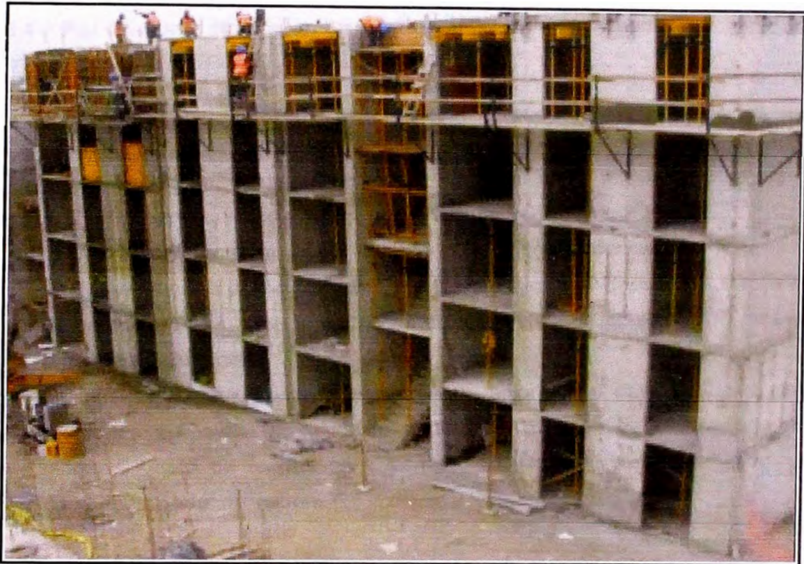
Figura N° 3.3: Procesos constructivos placas de ductilidad limitada – fin
