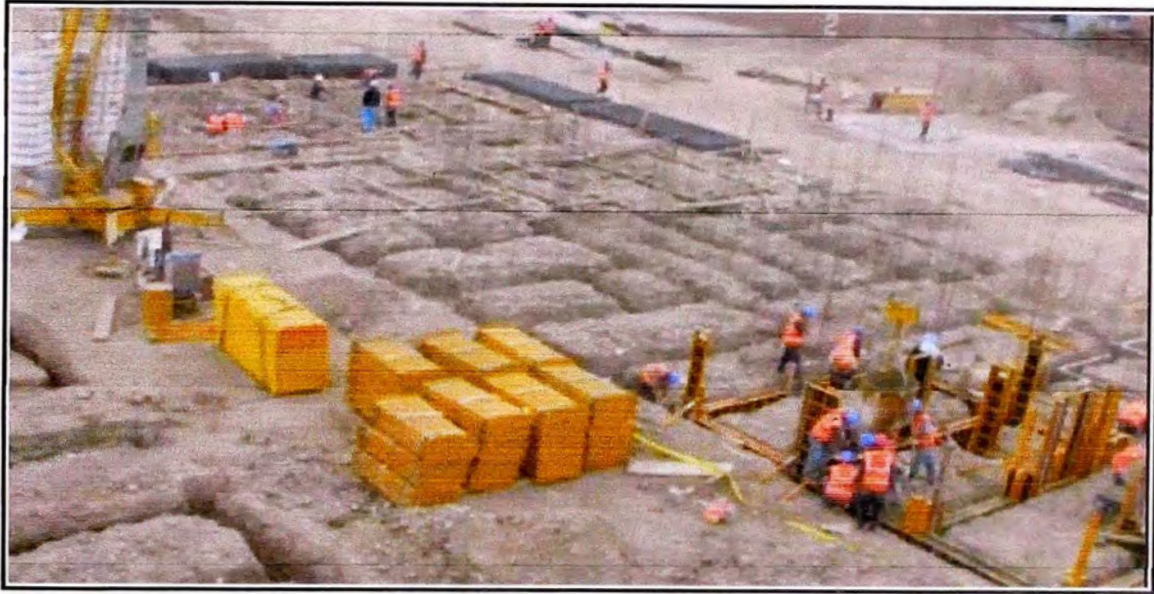
Figura N° 3.1: Procesos constructivos placas de ductilidad limitada - inicio
