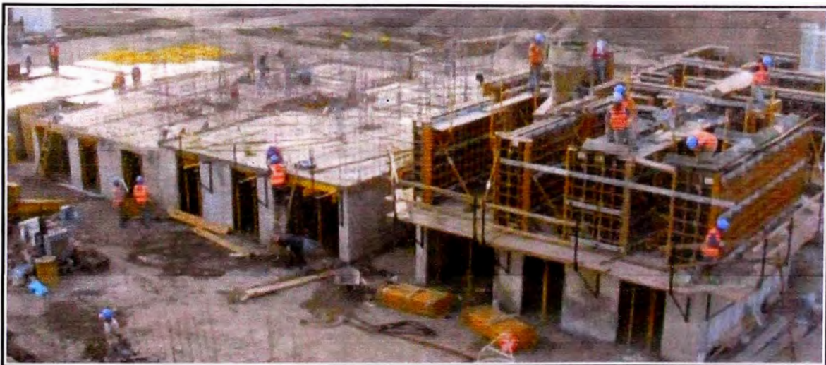
Figura N° 3.2: Procesos constructivos placas de ductilidad limitada – durante
