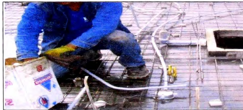
Figura 3.25: Taponeo de cajas y pases eléctricos
