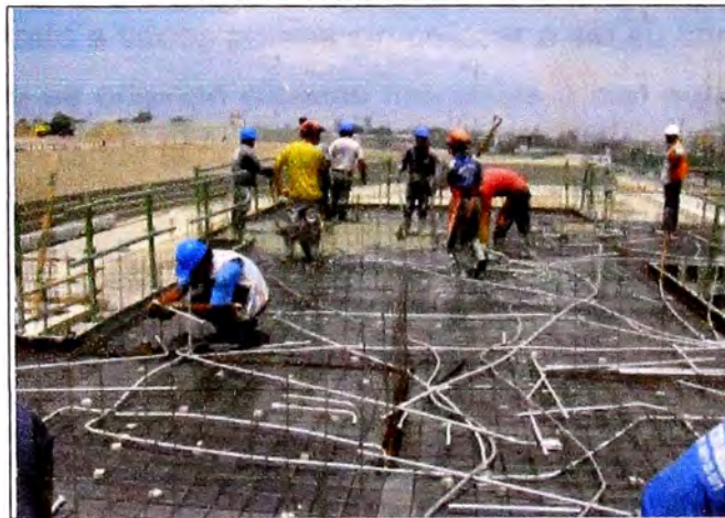
Figura 3.21: Trazo de Tuberías y Accesorios
