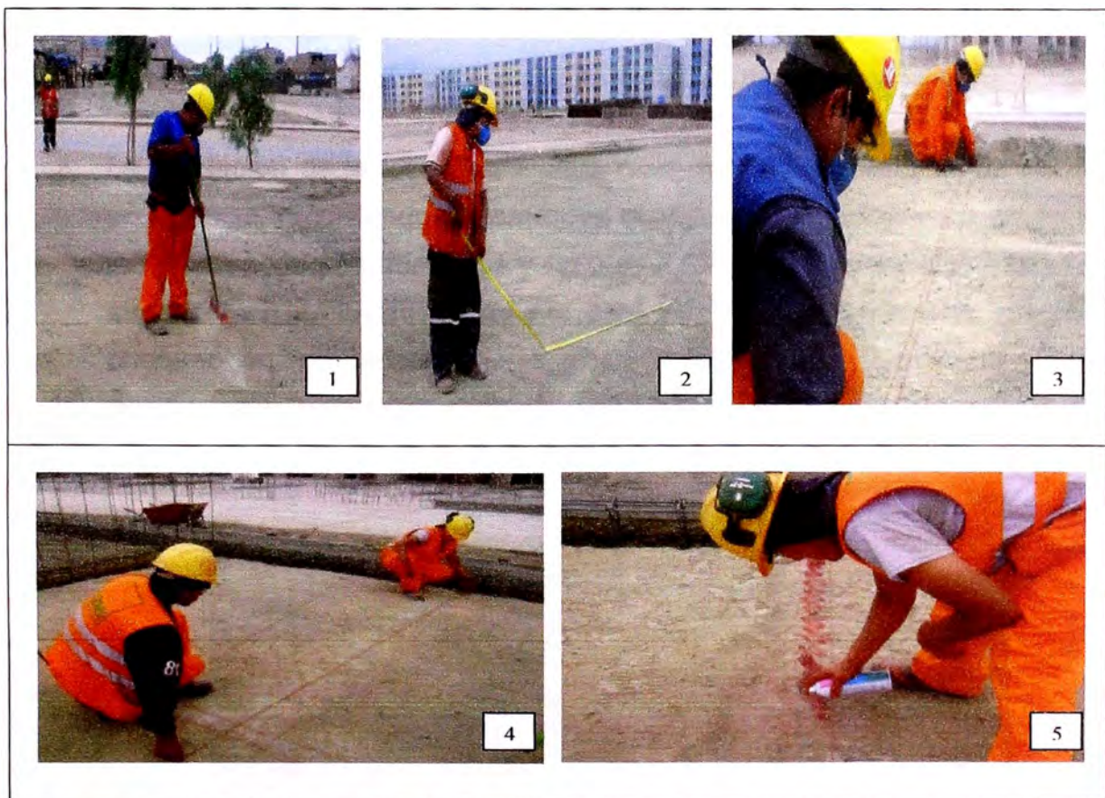
Figura 3.3: Control de Trazo Topográfico
