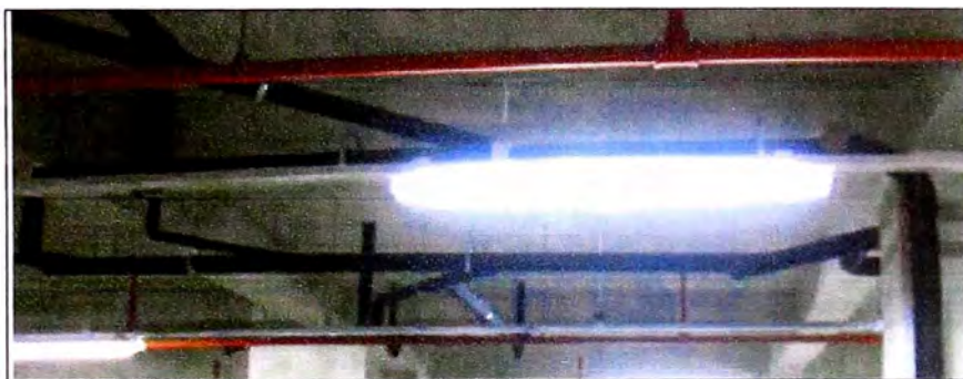
Figura 3.31: Verificación de pendiente en tubería de desagüe
