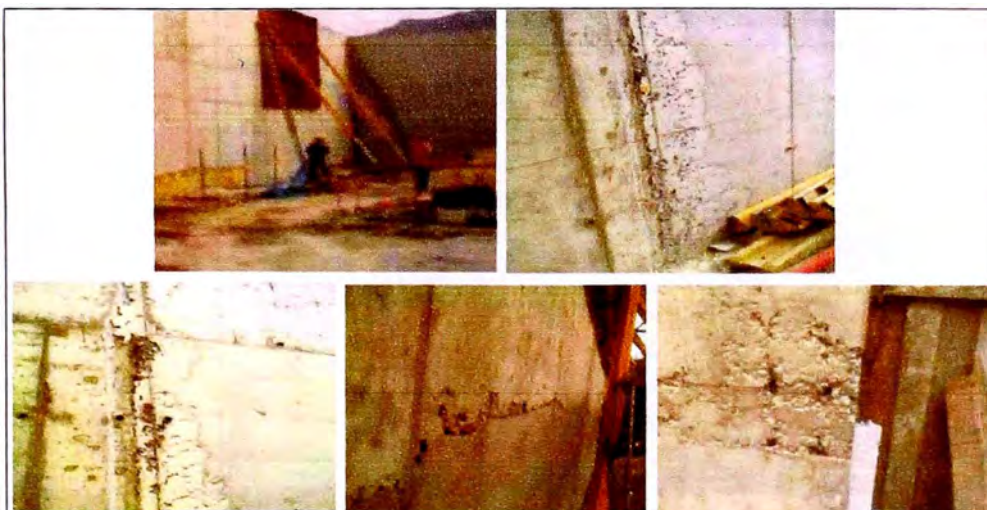
Figura 3.18: Junta de vaceado entre muros
