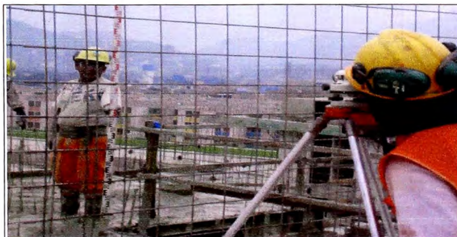
Figura 3.5: Nivelación de Losas
