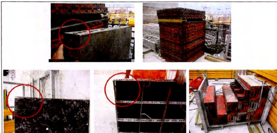
Figura 3.10: Estado de Conservación de Encofrado Metálico
