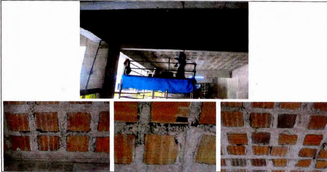
Figura 3.19: Vaceado de Losas Aligeradas
