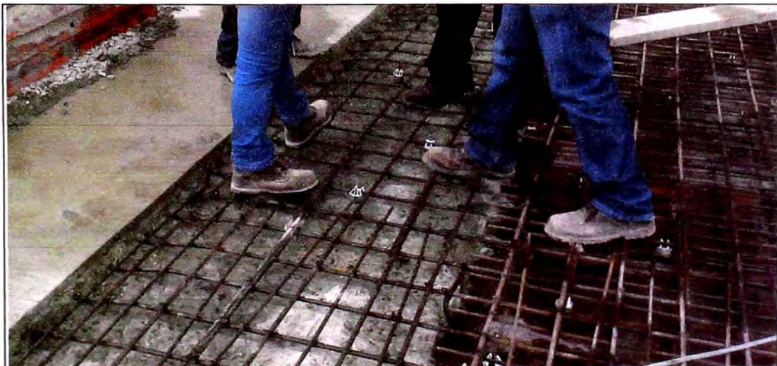
Figura 3.8: Verificación en Nivel de Acero de Refuerzo
