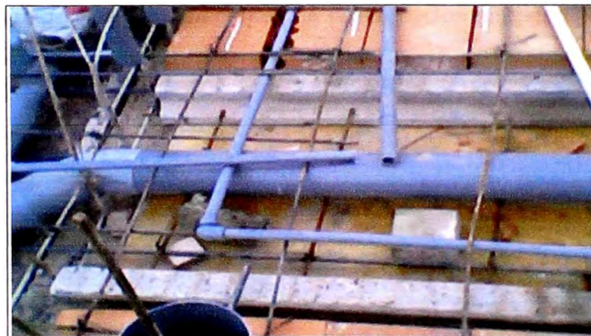
Figura 3.29: Verificación del recorrido y recubrimiento de tuberías
