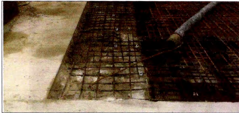
Figura 3.9: Verificación en Nivel de Acero de Refuerzo
