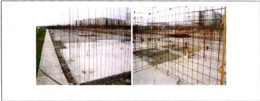
Figura 3.4: Vaceado de Platea de Cimentación
