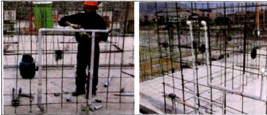
Figura 3.28: Prueba de instalaciones sanitarias
