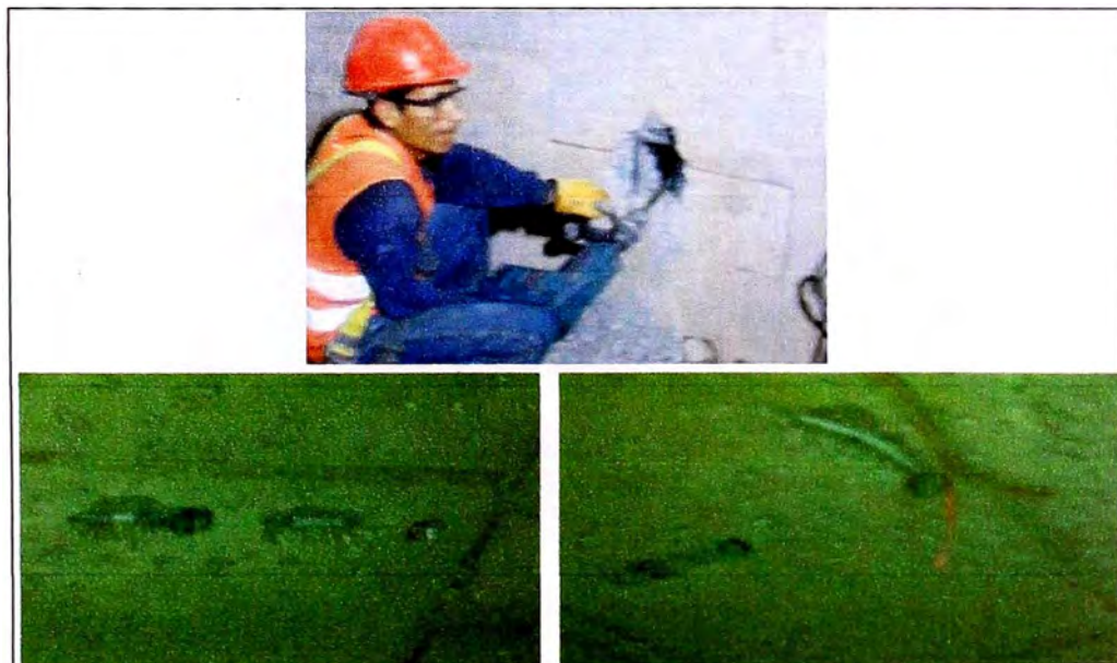
Figura 3.23: Picado de concreto por reubicación de instalaciones
