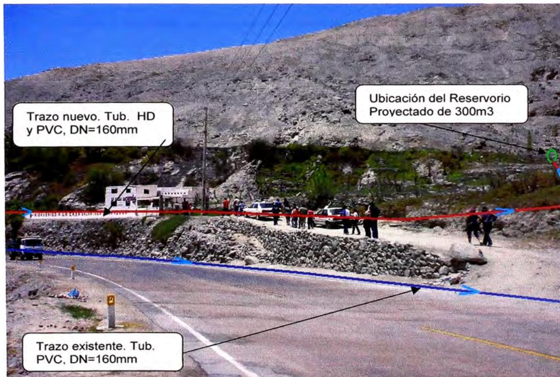
Trazo nuevo. Tub. HD y PVC, DN=160mm
