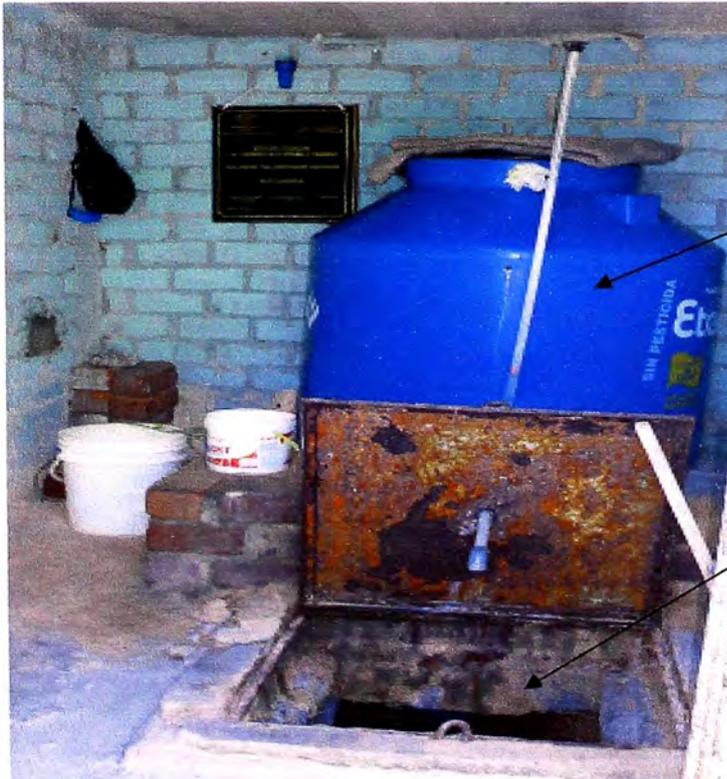
Tanque de 400lt, donde se hace la solución con Hipoclorito de calcio, con su tubo de control de nivel. La cloración se hace por goteo en la caja de reunión.
