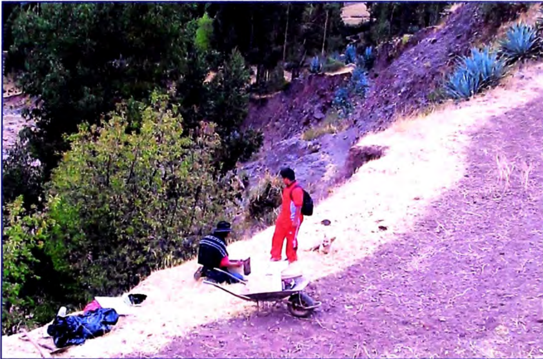
Foto N° 11. – Transporte de muestras, para la impermeabilización.
