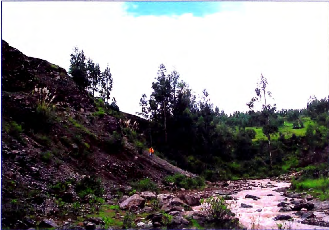
Foto N° 3. – Zona de estudio a inmediaciones de la sección C-C'.
