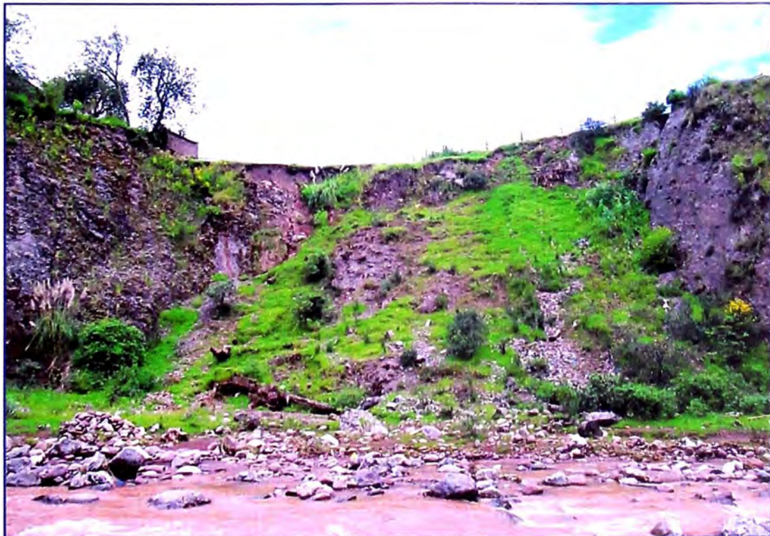
Foto N° 4. – Deslizamiento utilizado para el Retroanálisis, sección D-D'.
