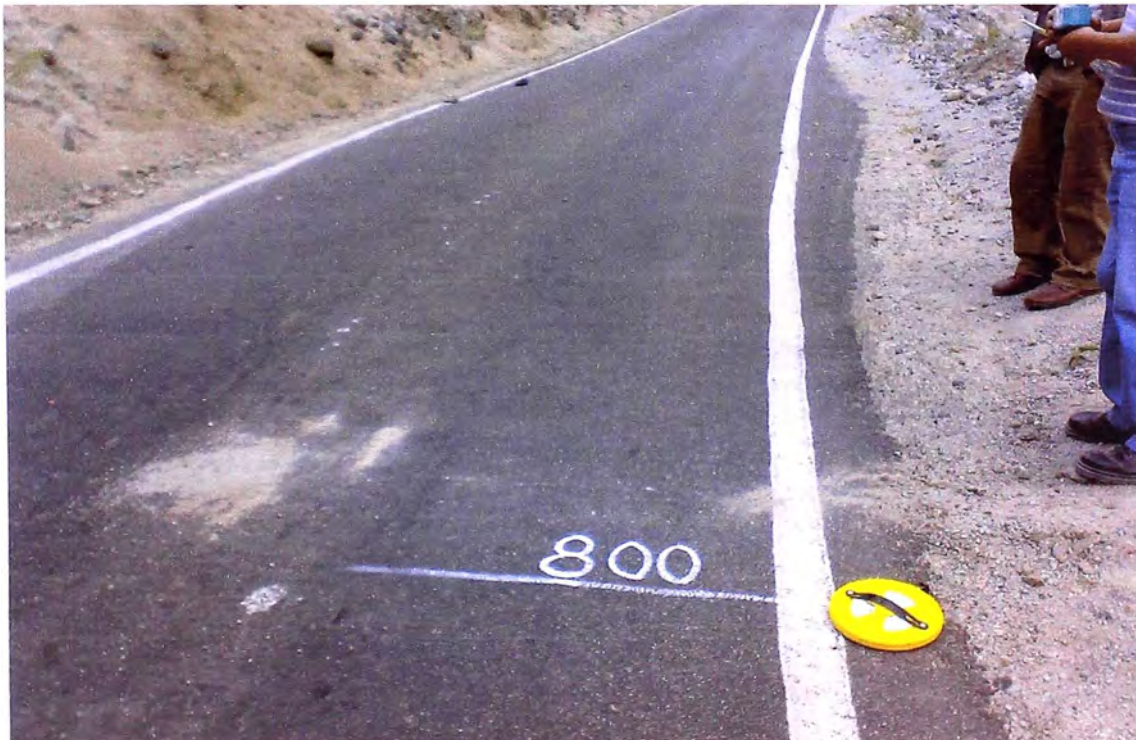
Foto N°2: Vía con tratamiento superficial (Monocapa+Slurry) Prog: 100+800 Km
