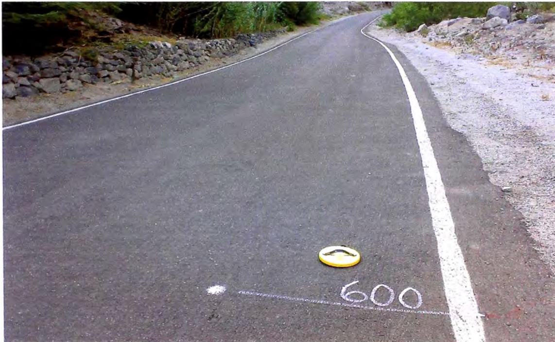
Foto N°2: Vía con tratamiento superficial (Monocapa+Slurry) Prog: 100+800 Km
