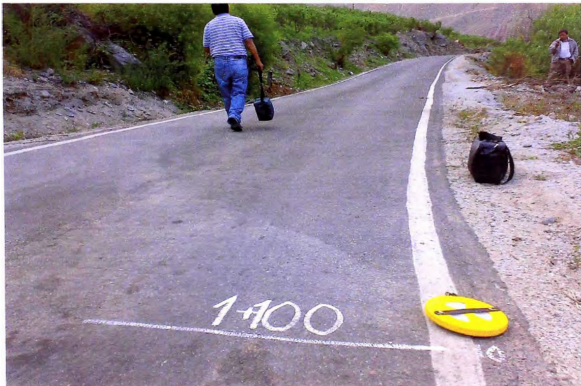
Foto N°4: Vía con tratamiento superficial (Monocapa+Slurry) Prog: 101+100 Km
