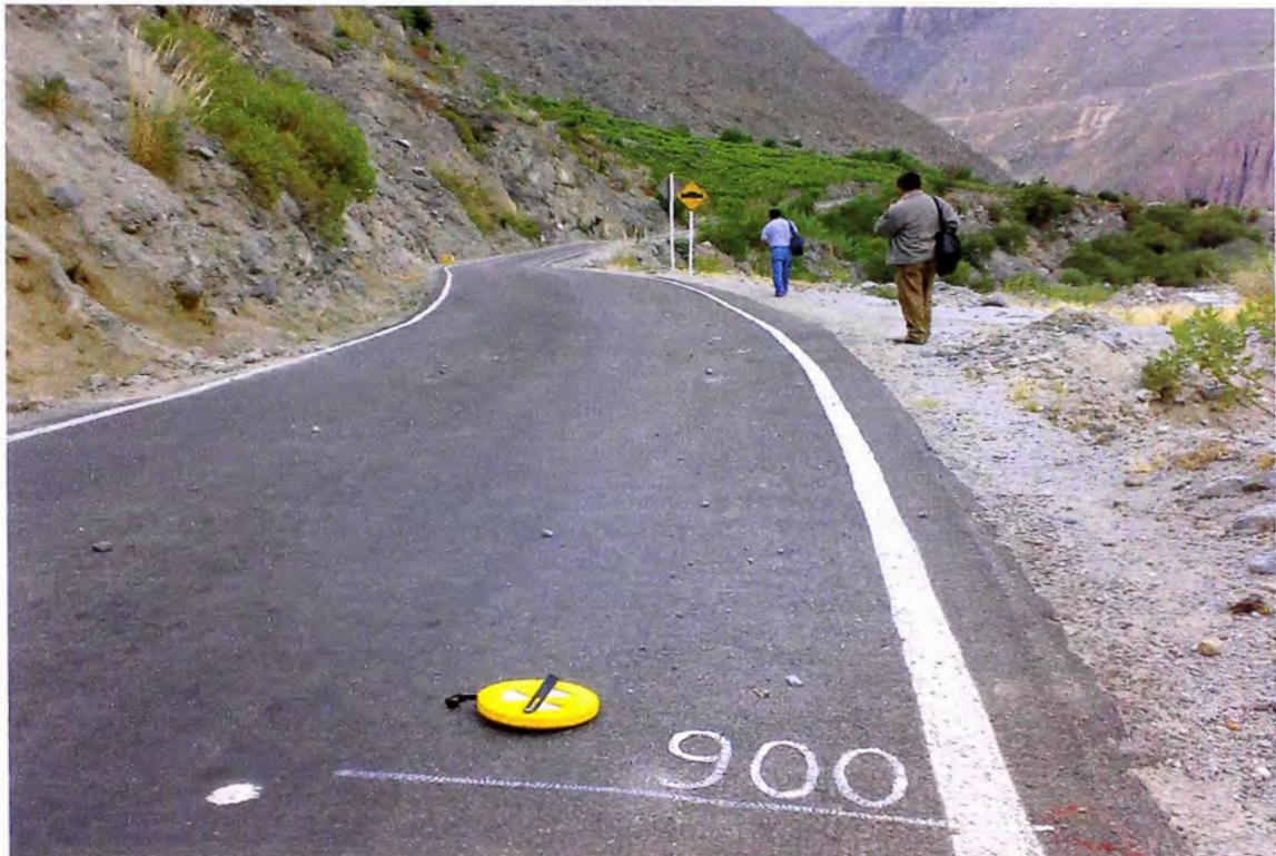
Foto N°4: Vía con tratamiento superficial (Monocapa+Slurry) Prog: 101+100 Km
