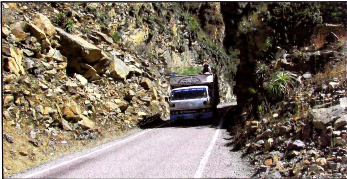
En la Figura 2.12: Observamos que en este tramo de la vía es imposible que más de un vehículo pase a la vez.
