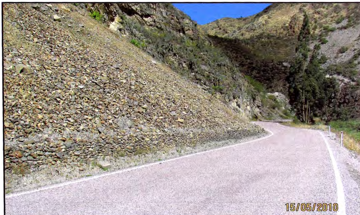
Figura N° 2.7: Deslizamiento de material rocoso suelto en el Km 144+000.
