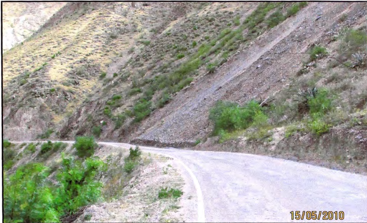
Figura N° 2.6: Deslizamiento de material granular suelto en el Km 139+000.
