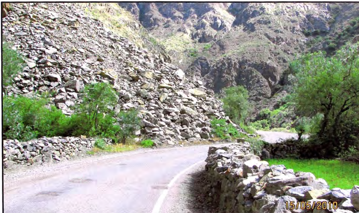
Figura 2.8: Deslizamiento de material rocoso suelto en el Km 145+000.
