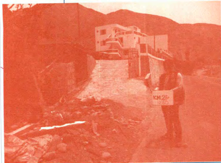
I.A: DESMONTE DE CONSTUCCION
