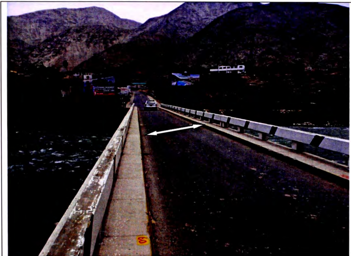
Foto N°- 2.5. Ancho de Calzada del Puente Sosci. El ancho de la calzada del puente permite el tránsito vehicular en una sola dirección por falta de otro carril. Véase el tránsito de un auto vehicular comparado al ancho existente de la plataforma del puente.
