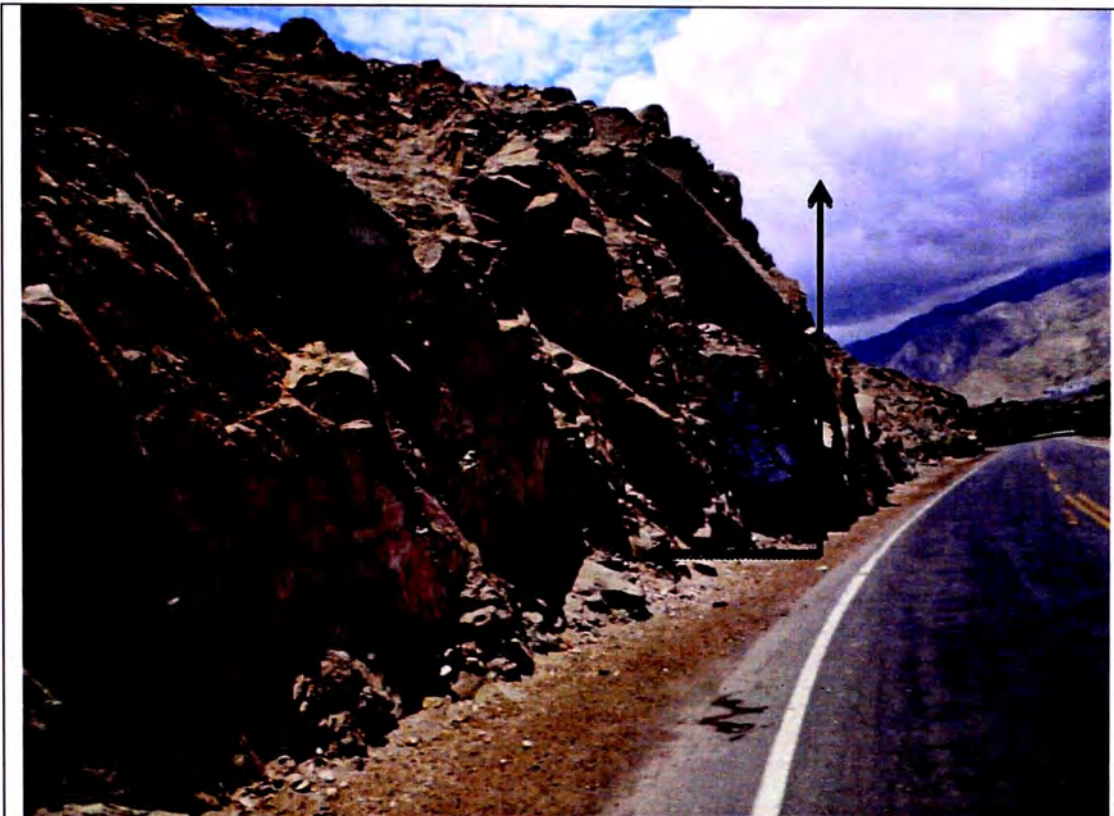
Foto N°- 3.8. Vista de Bermas y Taludes. Sobre la progresiva km 27+600, el talud que está al margen derecho del río Cañete, forman ángulos casi de 90^\circ con la carpeta asfáltica, no hay cunetas proyectadas.
