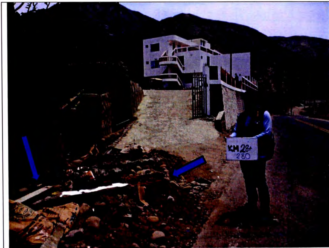
Foto N°- 4.1. Descuido Poblacional. En la progresiva km 28+280, se observa los desechos de construcción acumulado sobre la berma de la vía. Rellenando restos que obstruyen al drenaje adyacente.
