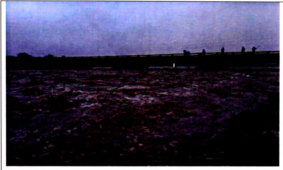
Foto N°- 1.5. Evento Extraordinario. Se muestra el nivel histórico alcanzado por el río Cañete el día 07/02/2012, la luz entre el nivel del agua y la plataforma inferior del puente Socsi expresa la impresión de peligro que causa el caudal 358.20 m 3 /seg. Causando cambios en las riveras aledañas del río.
