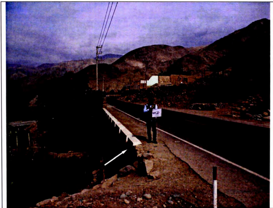
Foto N°- 2.12. Muro en Progresiva: km 28+540. El muro está en perfectas condiciones de servicio, en los tramos que necesitan, se podría diseñar el mismo modelo, según estudios.
