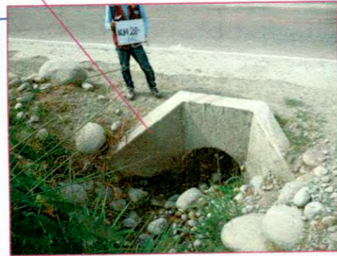
ALCANTARILLA Y DRENAJE
