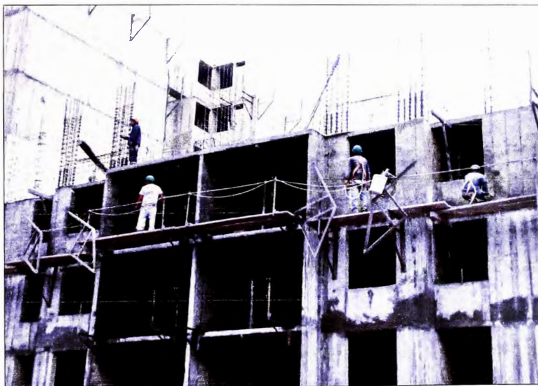
FIGURA N° 1.03: Construcción de edificación con muros de ductilidad limitada.
