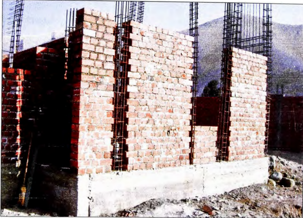
FIGURA N°1.01: Edificación típica con albañilería confinada.
