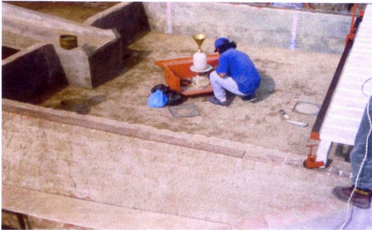
Fotografía N° 03: Fase I – Ejecución de la prueba del cono de arena para determinar la densidad seca del material.
