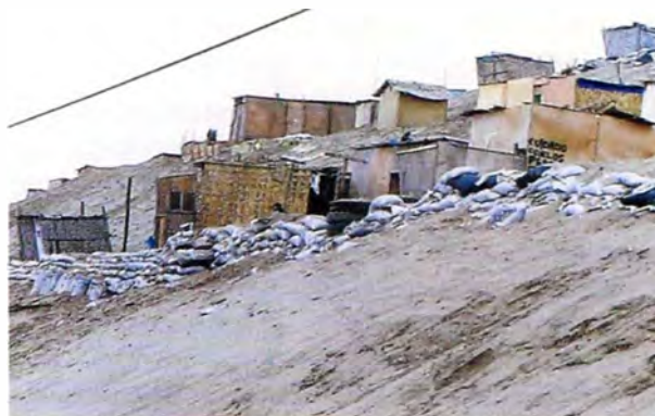
Figura 5. Vivienda en ubicaciones de riesgo.
