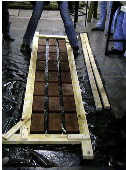
Figura 1. Racionalización: Los entrepisos de losetas de ladrillo, los muros de bloque y los corredores facilitan la circulación en obra. Zona 1, 710 viviendas. Instituto CEDAS Fuente: Archivo Kruk, 2015.
