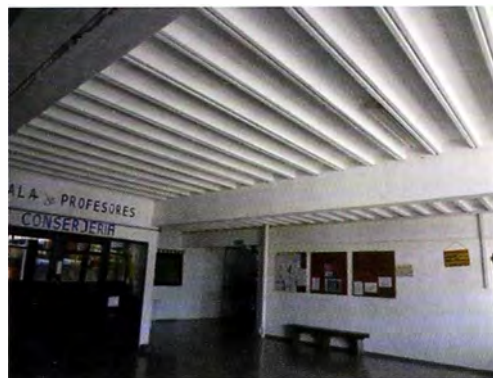
Figura 6. Entrepiso de prelosas nervadas de microhormigón.
