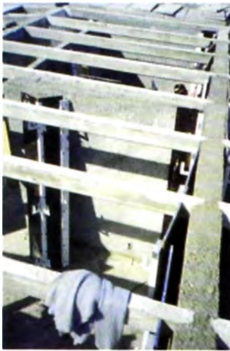
Figura 14. Cubierta de componentes premoldeados livianos de microhormigón. Sistema Consur 1.
