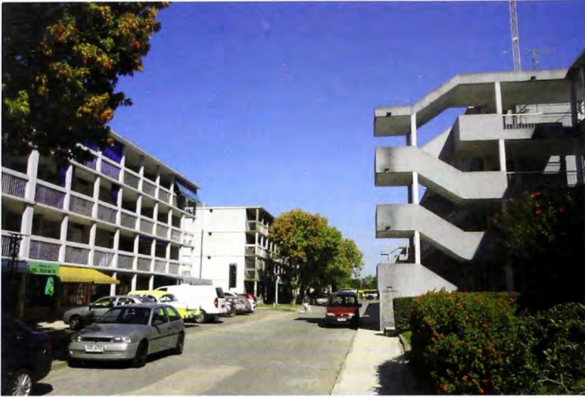
Figura 1. Racionalización: Los entrepisos de losetas de ladrillo, los muros de bloque y los corredores facilitan la circulación en obra. Zona 1, 710 viviendas. Instituto CEDAS Fuente: Archivo Kruk, 2015.
