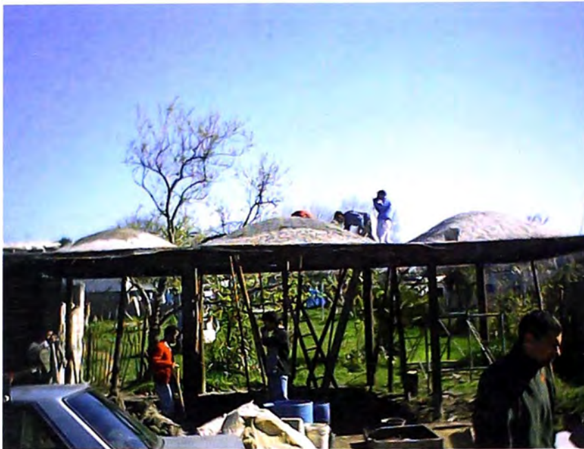
Figura 11. Cubiertas de vivienda con cúpulas de microhormigón. Fuente: Cátedra de Construcción, UdeLaR con el Movimiento Tacófilo.
