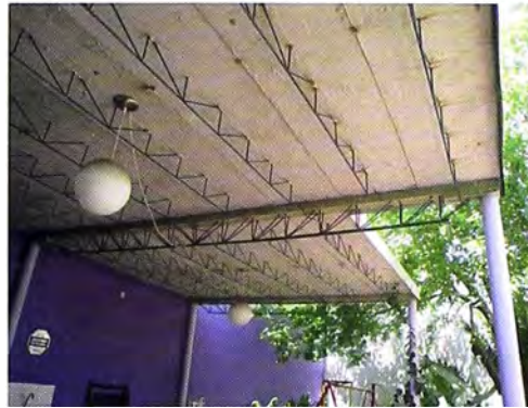
Figura 15. Losetas nervadas de microhormigón moldeadas a pie de obra. 290x50x3 cm. Sistema Consur 2.
