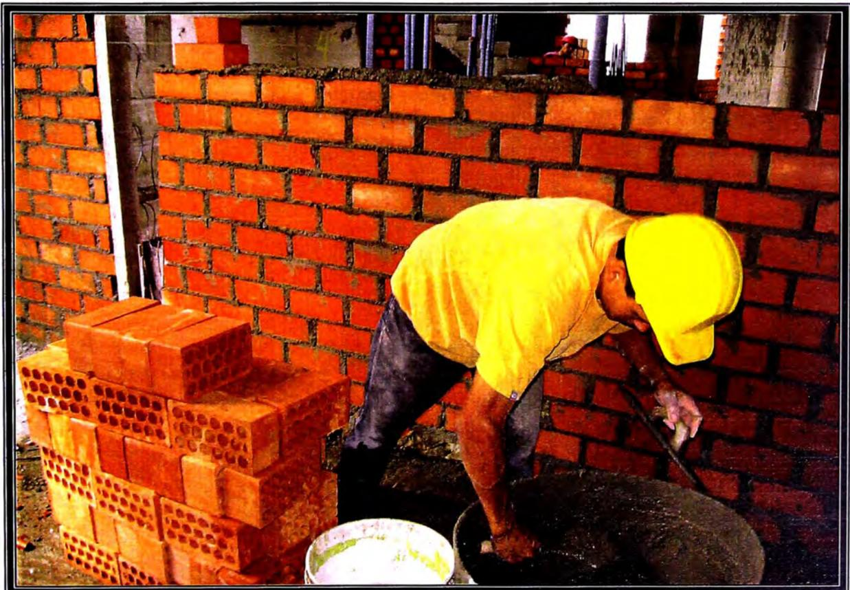
FOTO N° 40 OPERARIO BATIENDO MEZCLA EN UNA BATEA, SE OBSERVA LA DISTANCIA ENTRE LA BATEA Y EL NIVEL DE ASENTADO.
