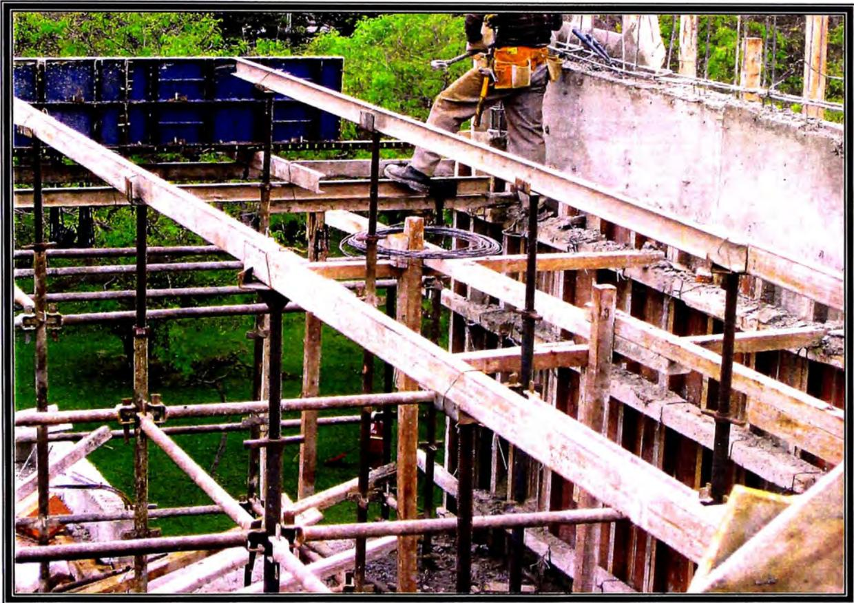
FOTO N° 21 SOLERAS METÁLICAS (CANALES) TRANSVERSALES A LAS VIGUETAS.
