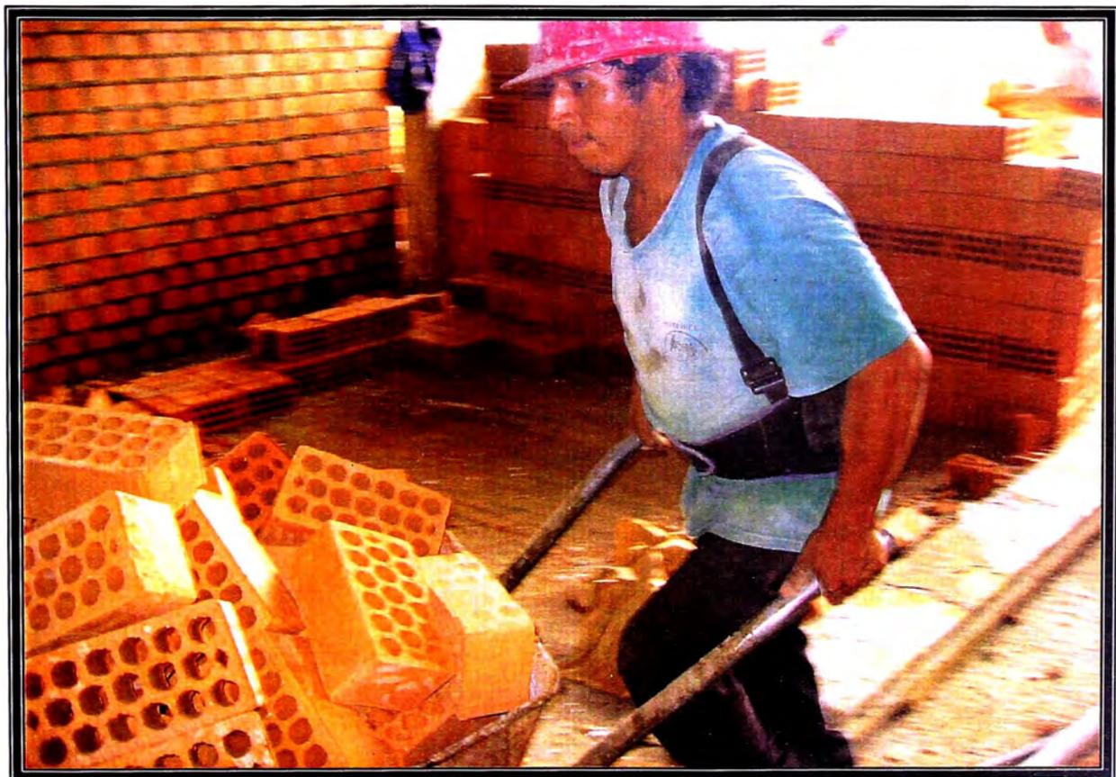
FOTO N° 34 TRANSPORTE DE LADRILLO KK 18 HUECOS, AMONTONADOS EN BUGGIE.
