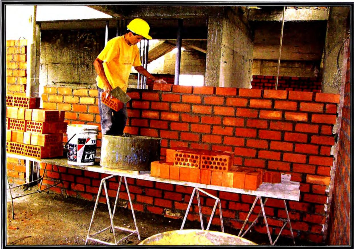
FOTO N° 37 OPERARIO COLOCANDO LADRILLOS EN PARED DE SOGA.
