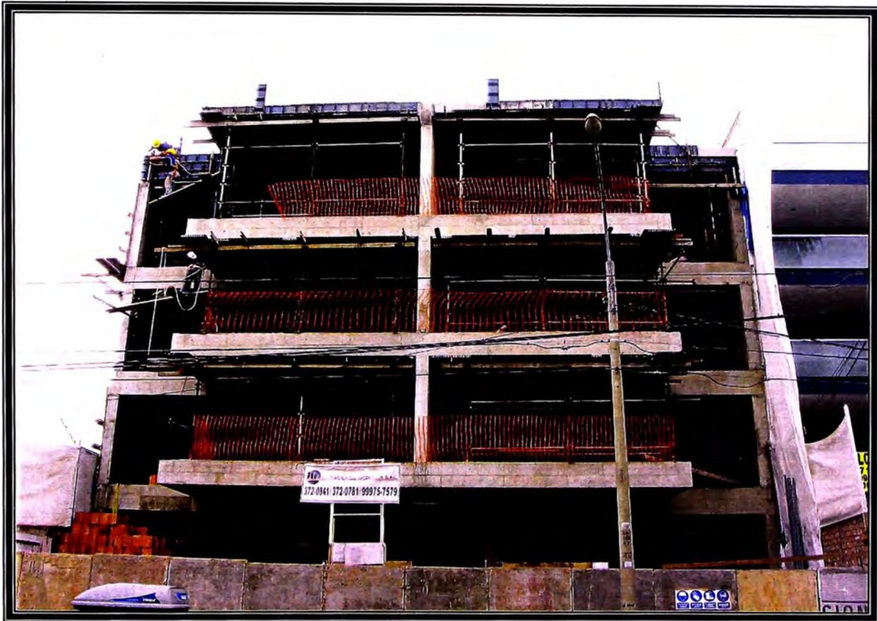
FOTO N° 33 VISTA FRONTAL DEL EDIFICIO AL USARSE ENCOFRADO METÁLICO.
