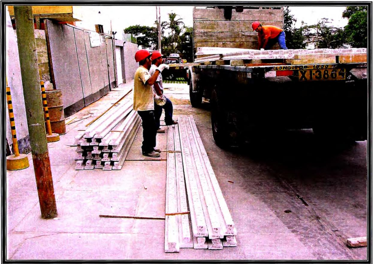
FOTO N° 01      DESCARGUE DE VIGUETAS PREFABRICADAS A LA OBRA POR EL PERSONAL DE FIRTH.
