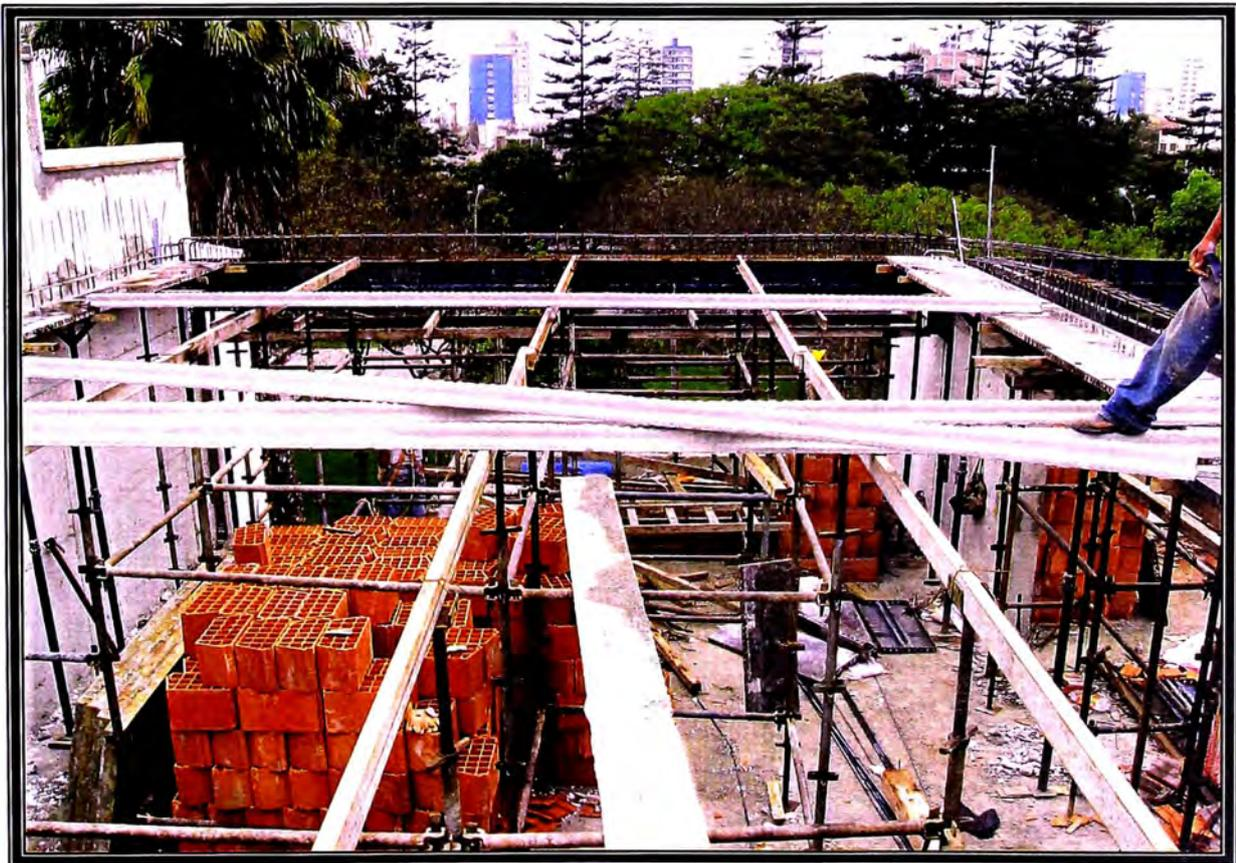
FOTO N° 22 COLOCACIÓN DE VIGUETAS FIRTH SOBRE SOLERAS METÁLICAS.
