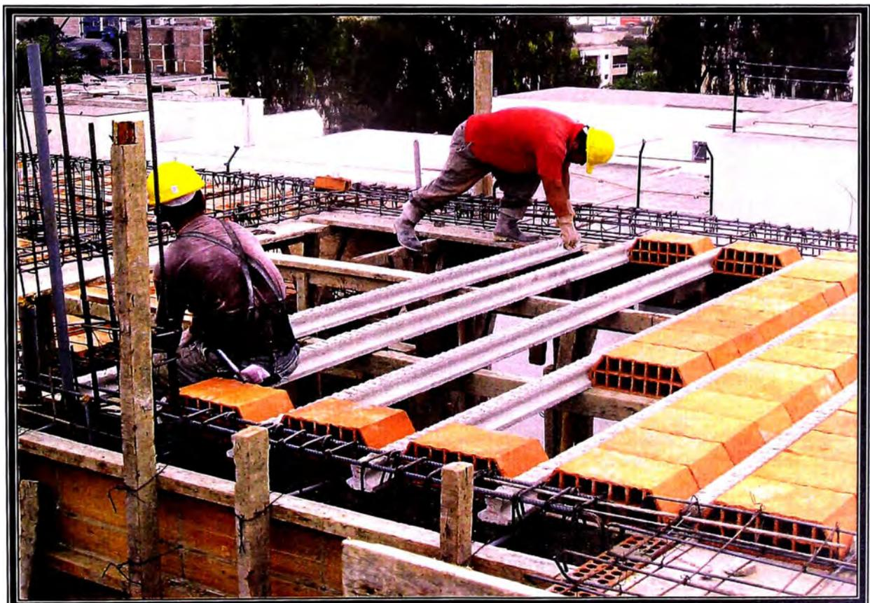
FOTO N° 08 COLOCACIÓN DE VIGUETAS.
