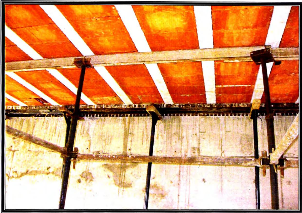
FOTO N° 23 DETALLE DE CANAL QUE ES SOPORTADO POR UN PUNTAL METÁLICO.
