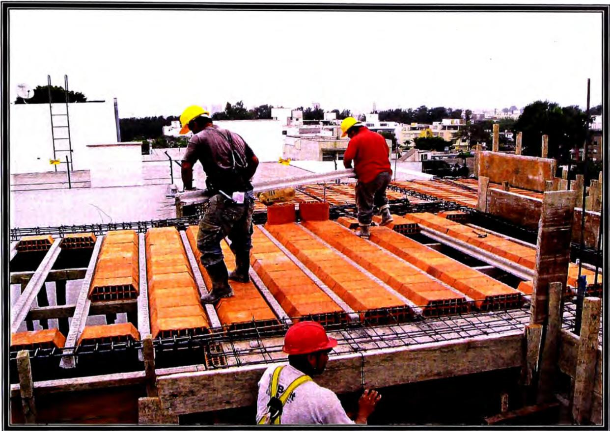
FOTO N° 07 TRANSPORTE DE VIGUETAS PREFABRICADAS FIRTH EN LA LOSA ALIGERADA.
