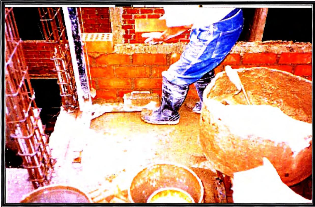
FOTO N° 45 ASENTADO DE LADRILLOS HACIENDO USO DEL ESCANIPIO.
