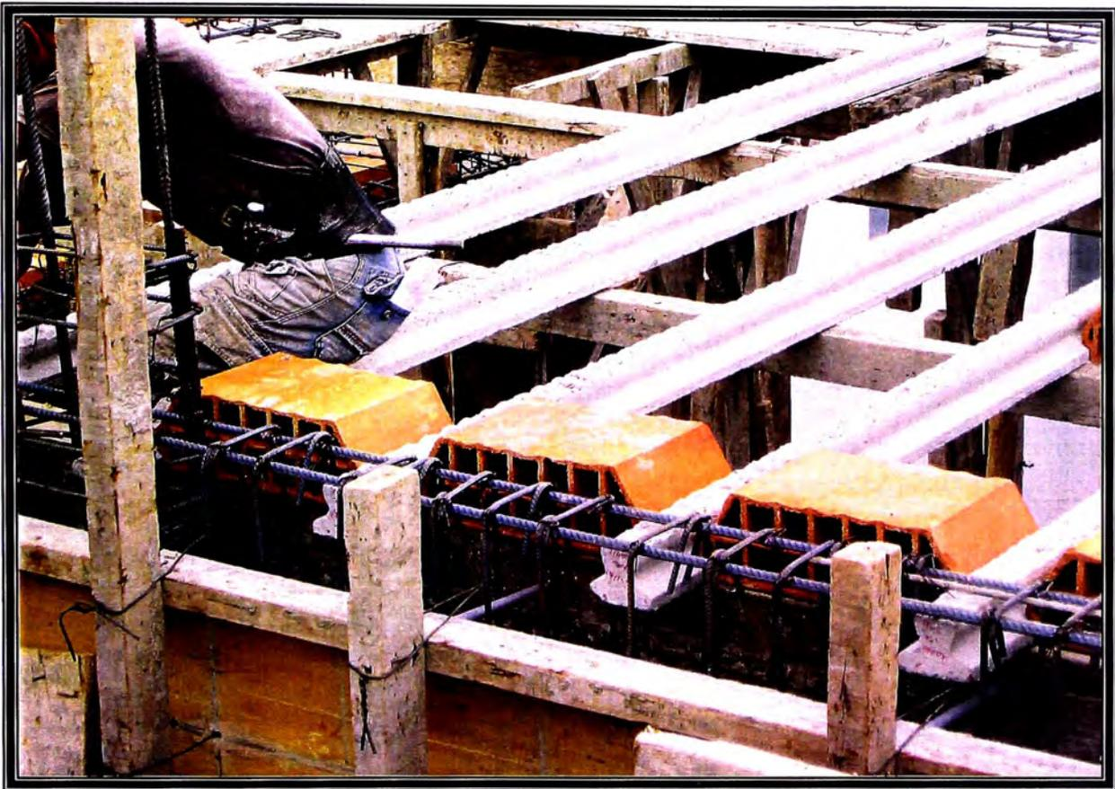
FOTO N° 09      OBSERVAMOS QUE LAS BOVEDILLAS FUNCIONAN COMO ELEMENTOS DISTANCIADORES.
