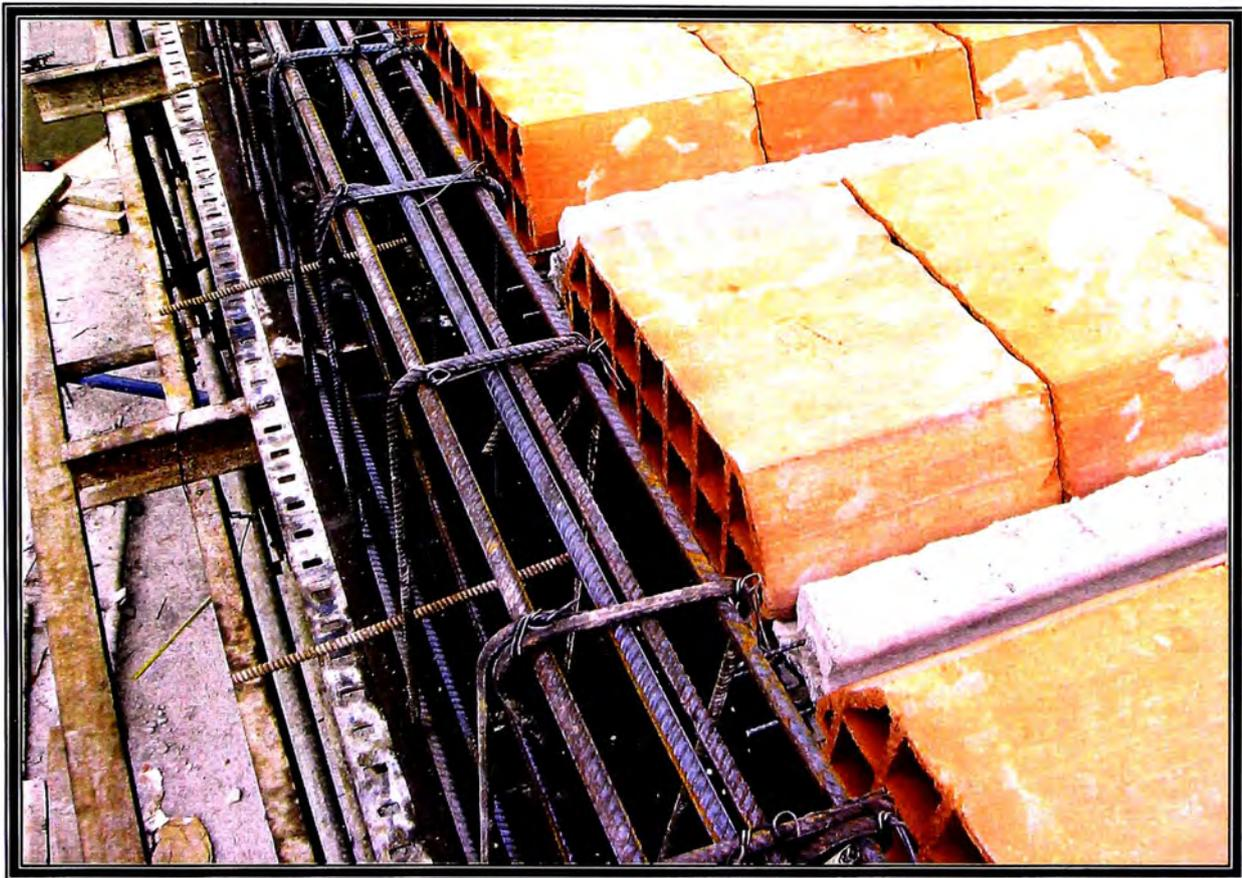
FOTO N° 31 LOSA CON VIGUETAS PREFABRICADAS Y ENCOFRADO METÁLICO UNISPAN.
