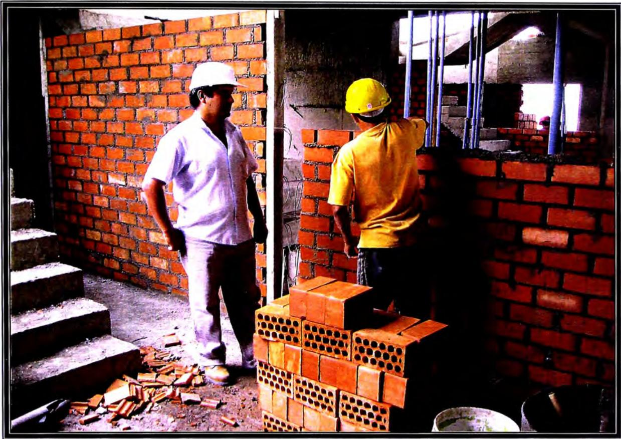
FOTO N° 41 INGENIERO RESIDENTE VERIFICANDO LA CORRECTA COLOCACION DE LOS LADRILLOS.
