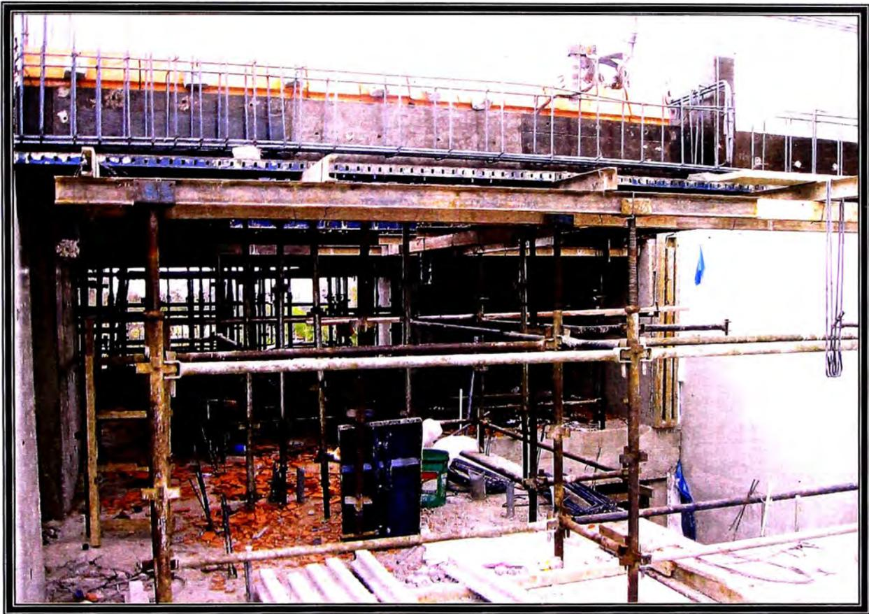
FOTO N° 25 FONDO DE VIGA METÁLICA UNISPAN.
