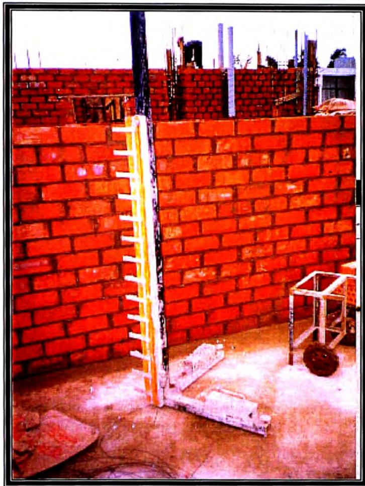
FOTO N° 43 ESCANIPLO, HERRAMIENTA QUE SIMPLIFICA LAS OPERACIONES DE ASENTADO DE LADRILLOS.
