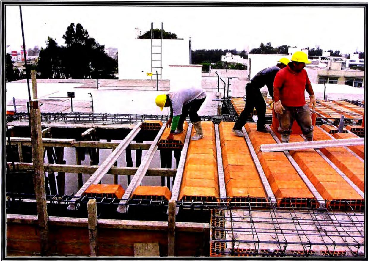
FOTO N° 11 COLOCACIÓN DE BOVEDILLAS.
