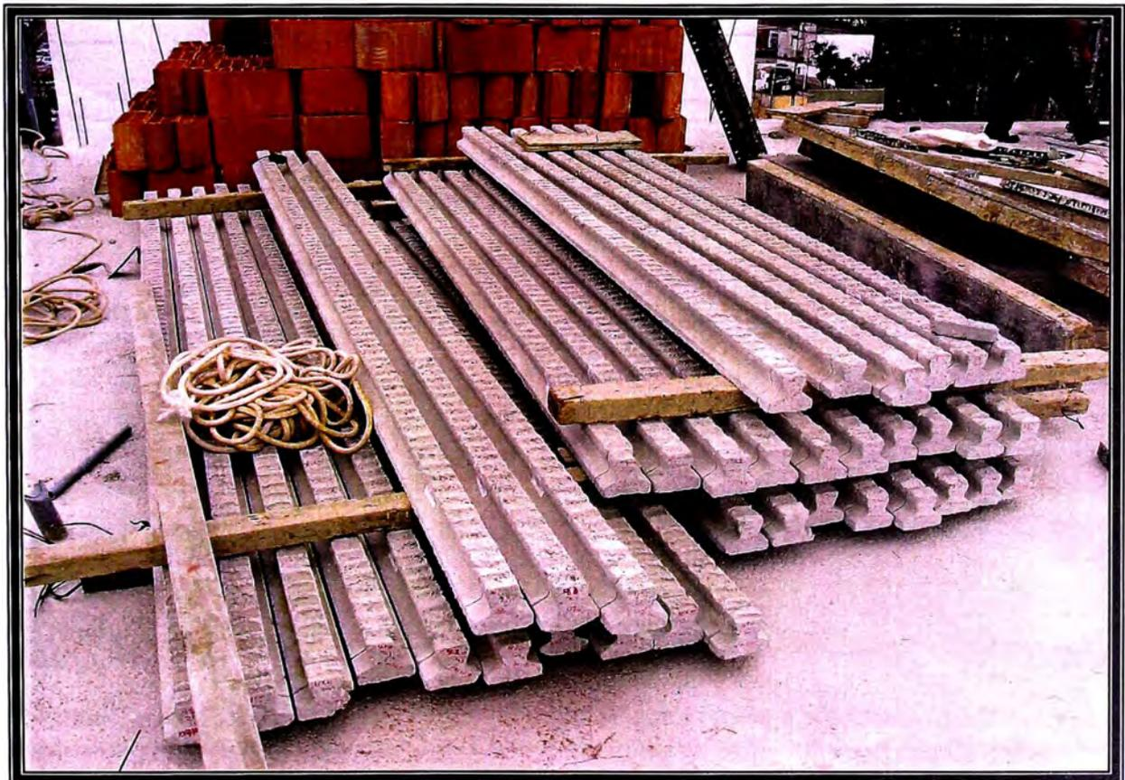
FOTO N° 02      APILADO DE VIGUETAS PREFABRICADAS.
