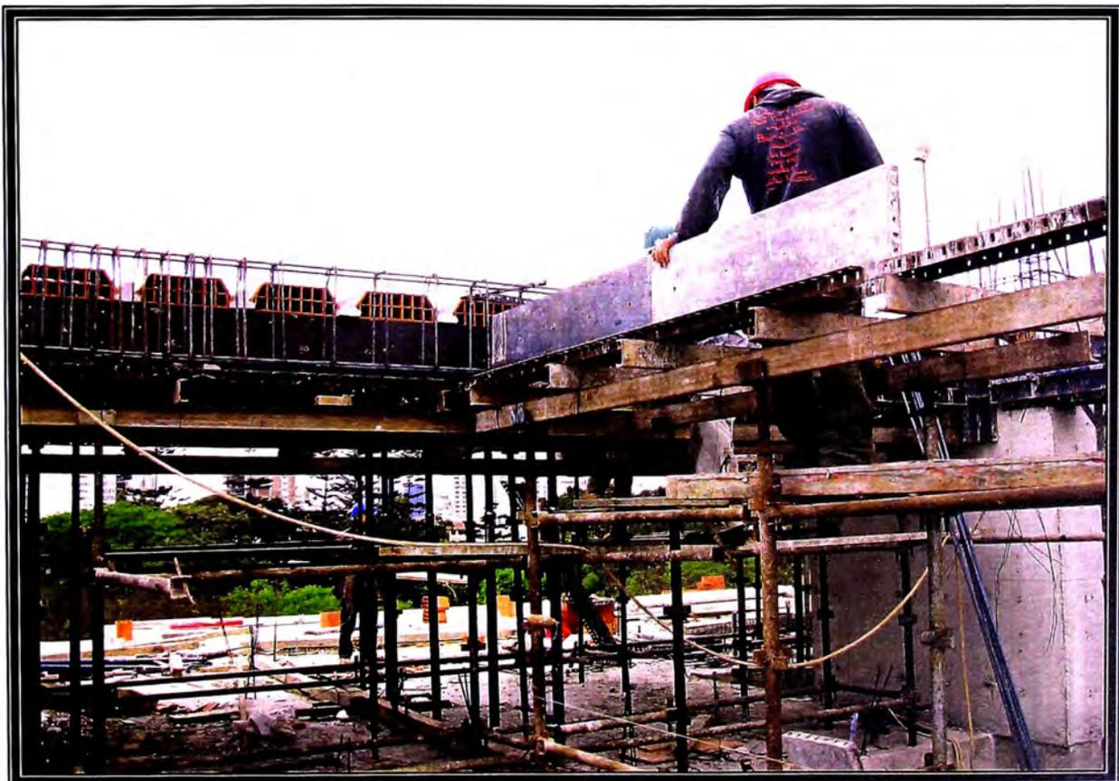
FOTO N° 32 LOSA CON VIGUETAS PREFABRICADAS Y ENCOFRADO METÁLICO UNISPAN.
