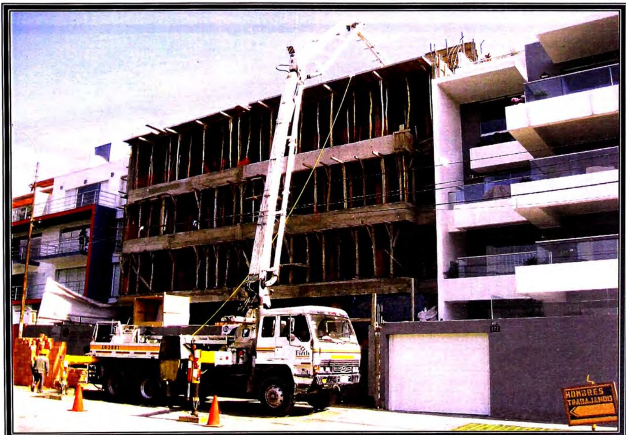
**FOTO N° 18** USO DE CONCRETO PREMEZCLADO FIRTH PARA EL VACIADO DE LA LOSA, SE APRECIA LA VISTA FRONTAL DEL EDIFICIO (ENCOFRADO DE MADERA).
