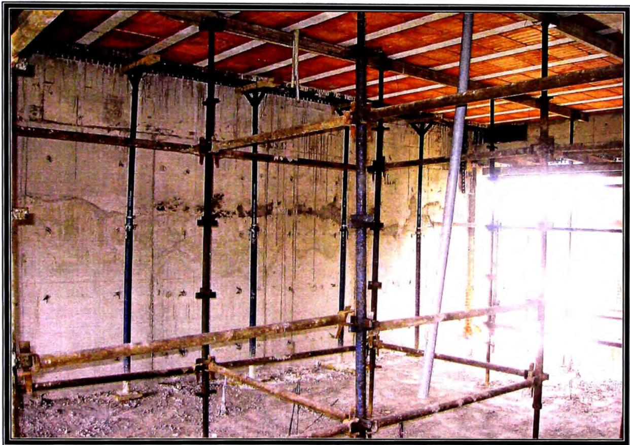
FOTO N° 19 SISTEMA DE SOPORTE UNISPAN PARA LOSA ALIGERADA USANDO VIGUETAS PREFABRICADAS.
