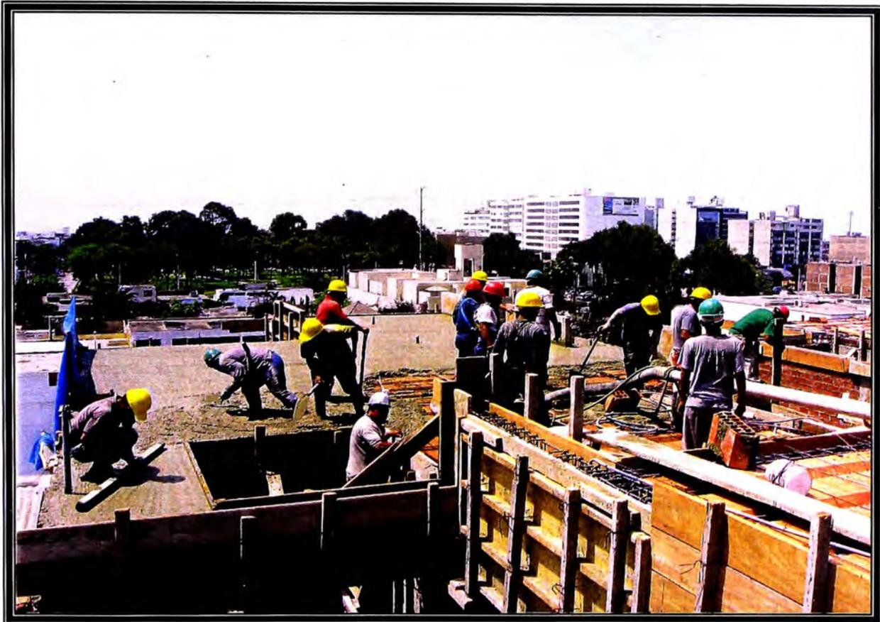
**FOTO N° 17** VACIADO DEL CONCRETO DEL TECHO, SE OBSERVA EL REGLEADO PARA MANTENER EL NIVEL DEL MISMO.
