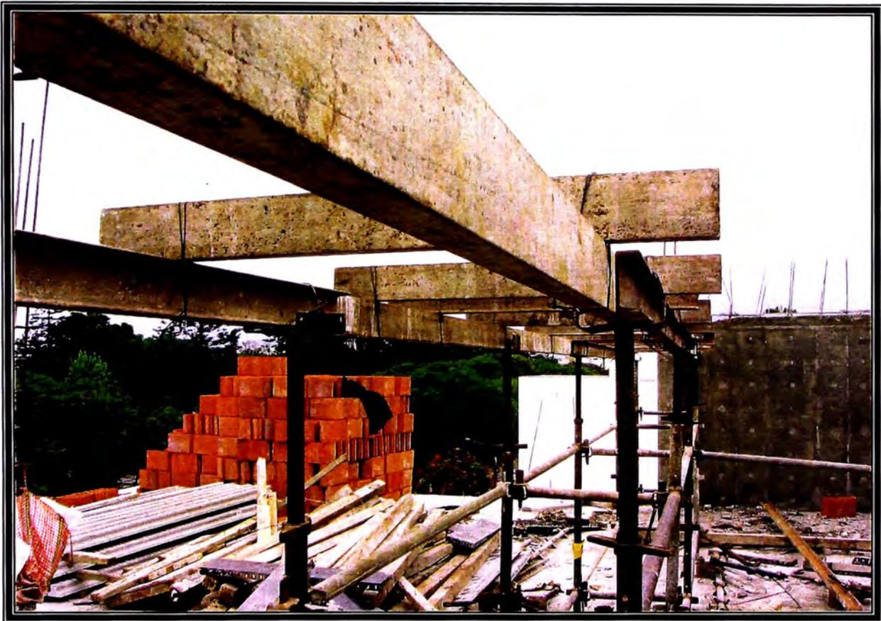
FOTO N° 27      DETALLE DEL FONDO DE VIGA UNISPAN.
