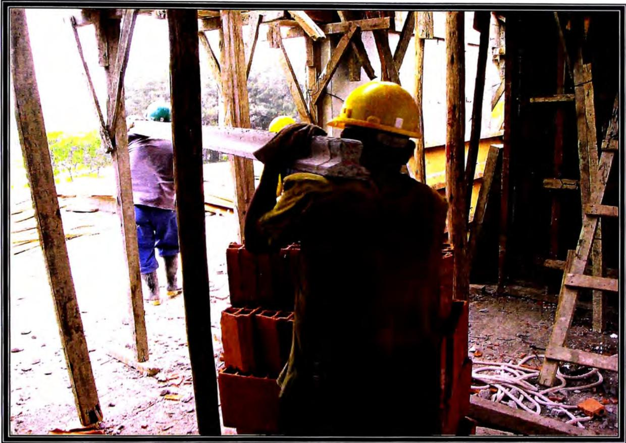
FOTO N° 05 TRANSPORTE DE VIGUETAS PREFABRICADAS FIRTH.
