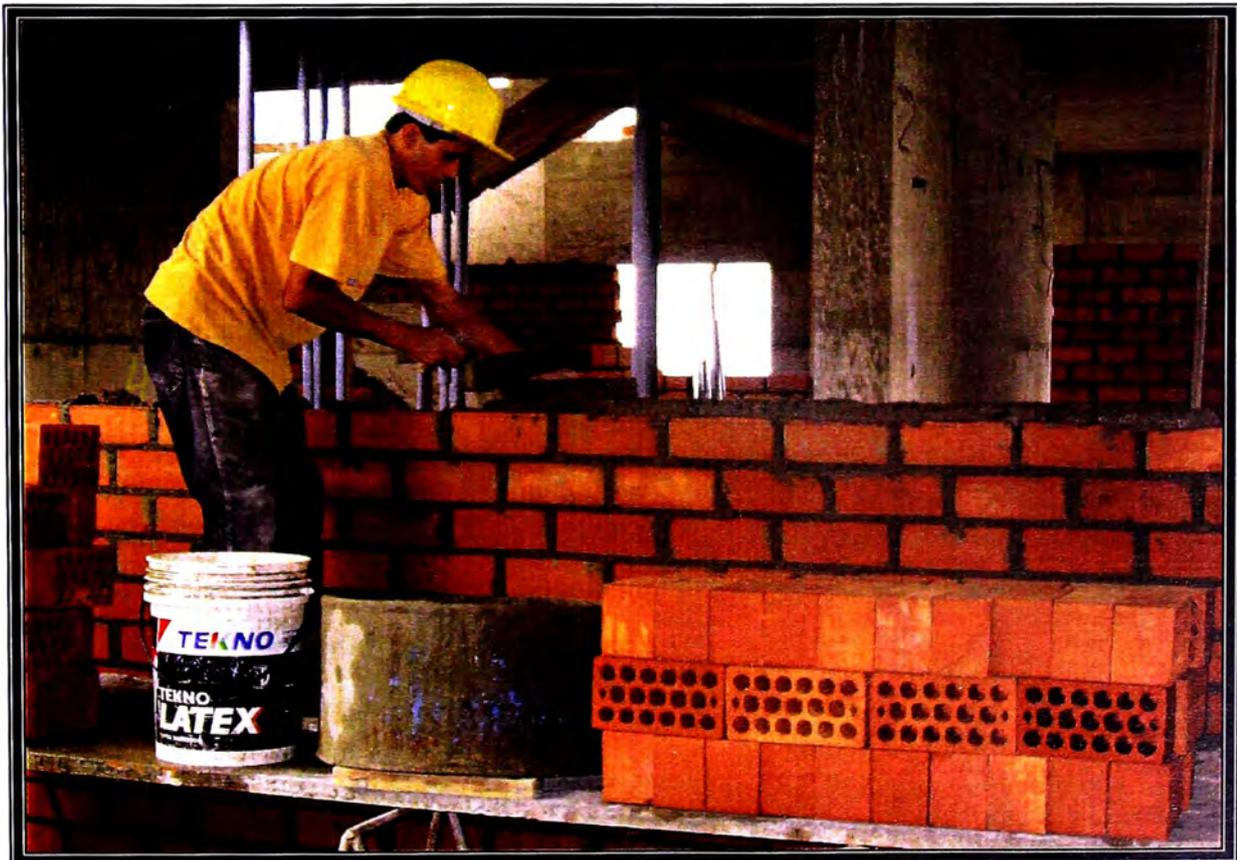
FOTO N° 36 OPERARIO COLOCANDO MORTERO EN PARED DE SOGA.
