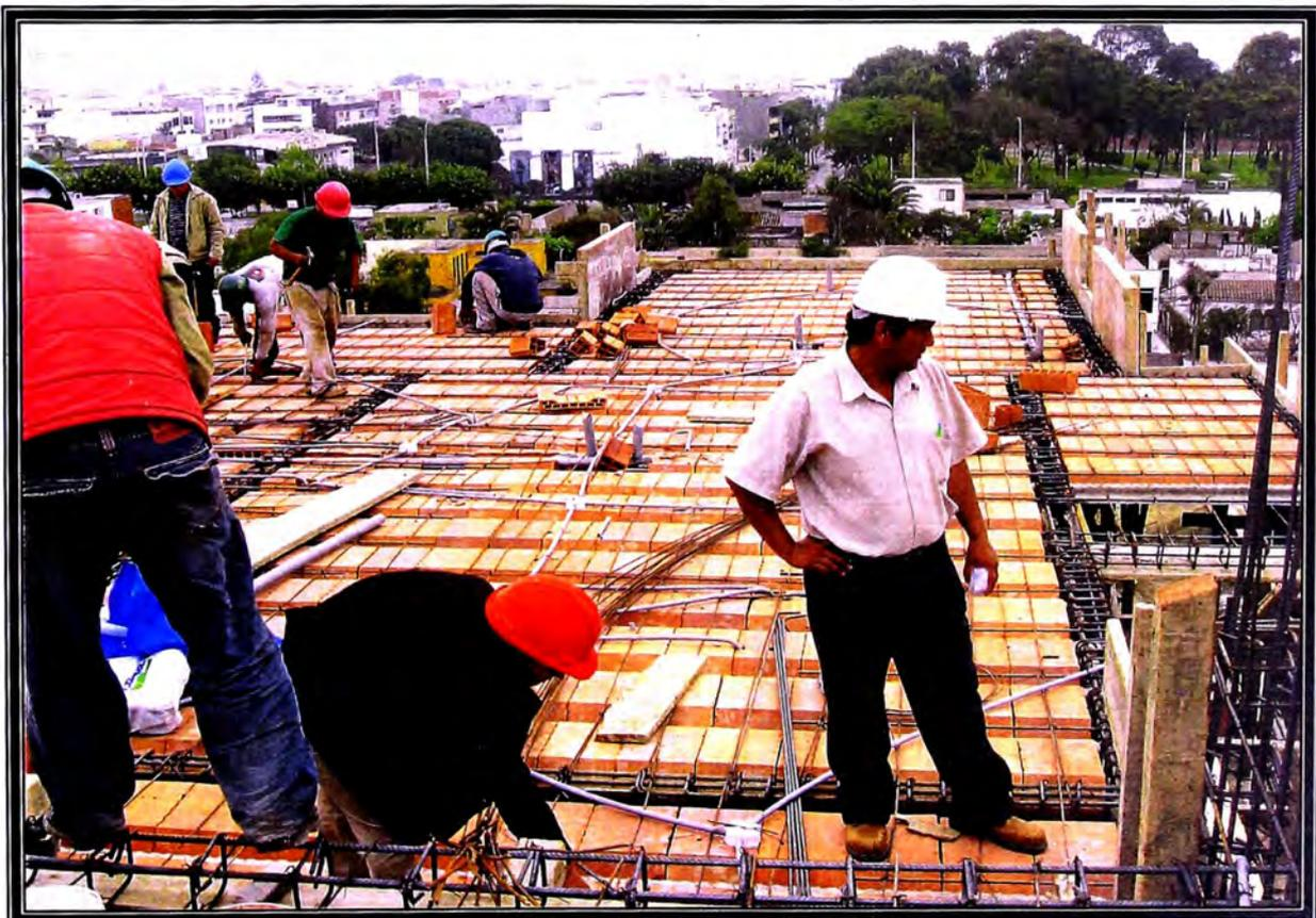
FOTO N° 16 REMATE DE LA PARTE ELÉCTRICA Y FIERRO DE TEMPERATURA, SE OBSERVA AL INGENIERO RESIDENTE SUPERVISANDO EL PROCESO CONSTRUCTIVO.
