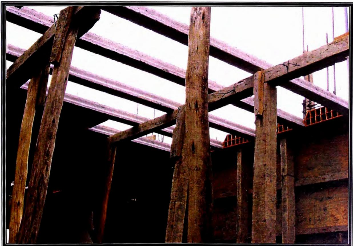
FOTO N° 04 ENCOFRADO DE LOSA ALIGERADA EMPLEANDO PUNTALES Y SOLERAS DE MADERA.
