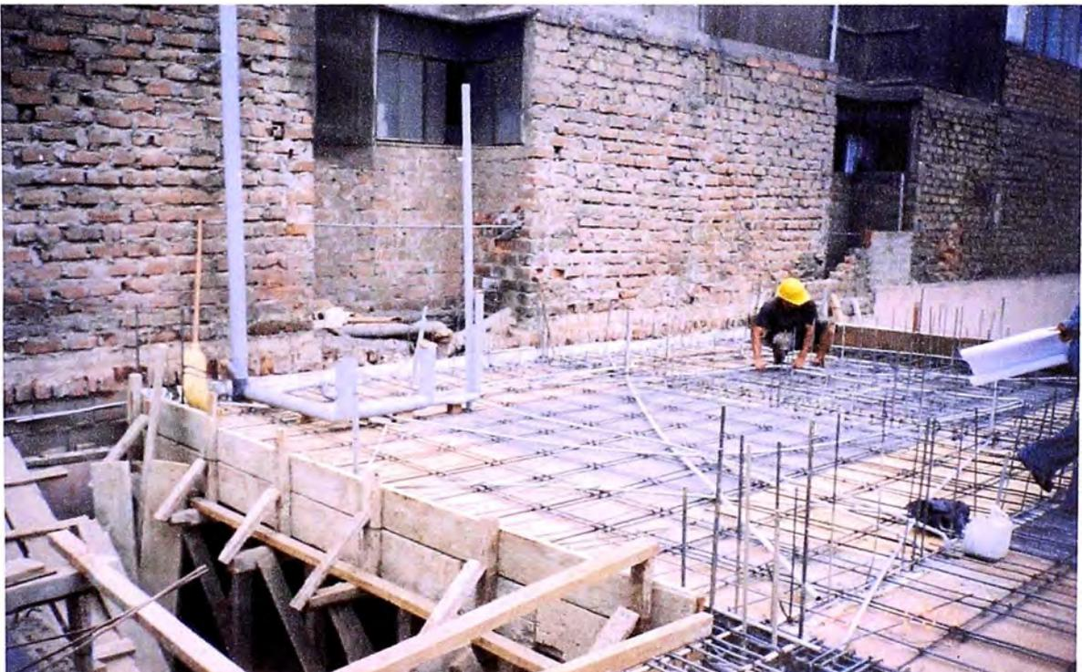
**Foto N°6** Tendido de tubería de instalaciones eléctricas y Sanitarias
