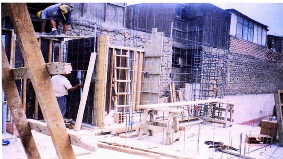
**Foto N°13 y N°14** Observamos al personal de obra realizando el encofrado de las placas y losa maciza, en las placas se observa a un operario colocando la caja de distribución que quedará empotrada en la pared.
