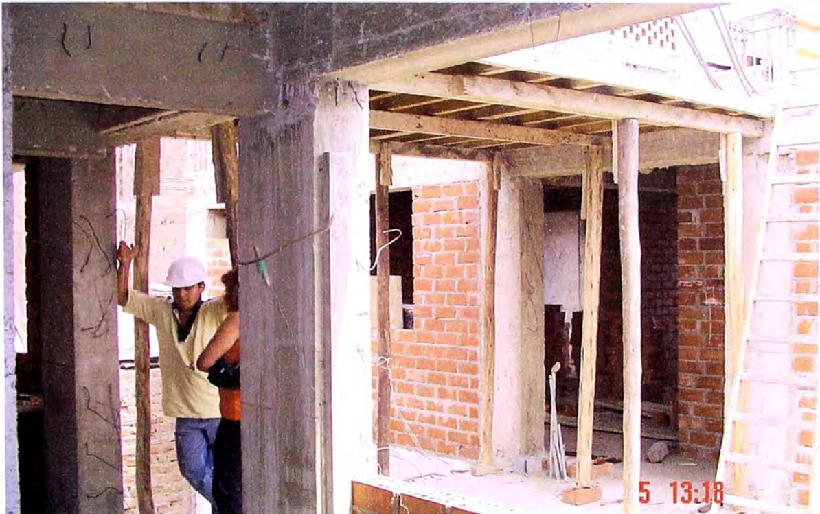
**Foto N° 1** Observamos el encofrado de la losa de conexión entre el tercer y cuarto bloque
