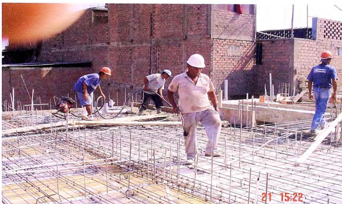
**Foto n° 15** Vaciado de la losa de 12cm, observamos el enmallado de doble dirección, se puede apreciar también algunas cintas colocadas entre panel y panel con la finalidad de menguar el paso del concreto por las juntas y evitar trabajos adicionales de limpieza.
