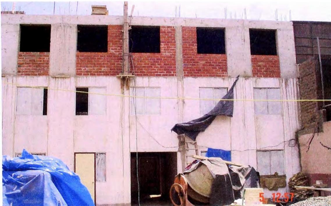
**Foto N°16** En esta foto podemos apreciar los trabajos de albañilería como tabiquería
