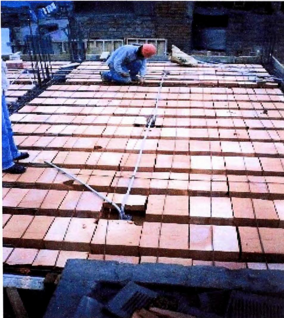
**Foto N°2** Se observa el encofrado el techo aligerado con ladrillo huecos de 15x30x30
