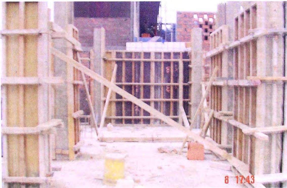
**Foto N° 1.** Se aprecia la forma como han sido encofradas las placas y columnas, el uso de los bastidores y barrotes horizontales de 2"x3" de madera tornillo. Es preciso indicar que estos paneles antes de ser utilizados han sido limpiados de cualquier elemento de concreto y posteriormente colocada desmoldante si así lo amerita.
