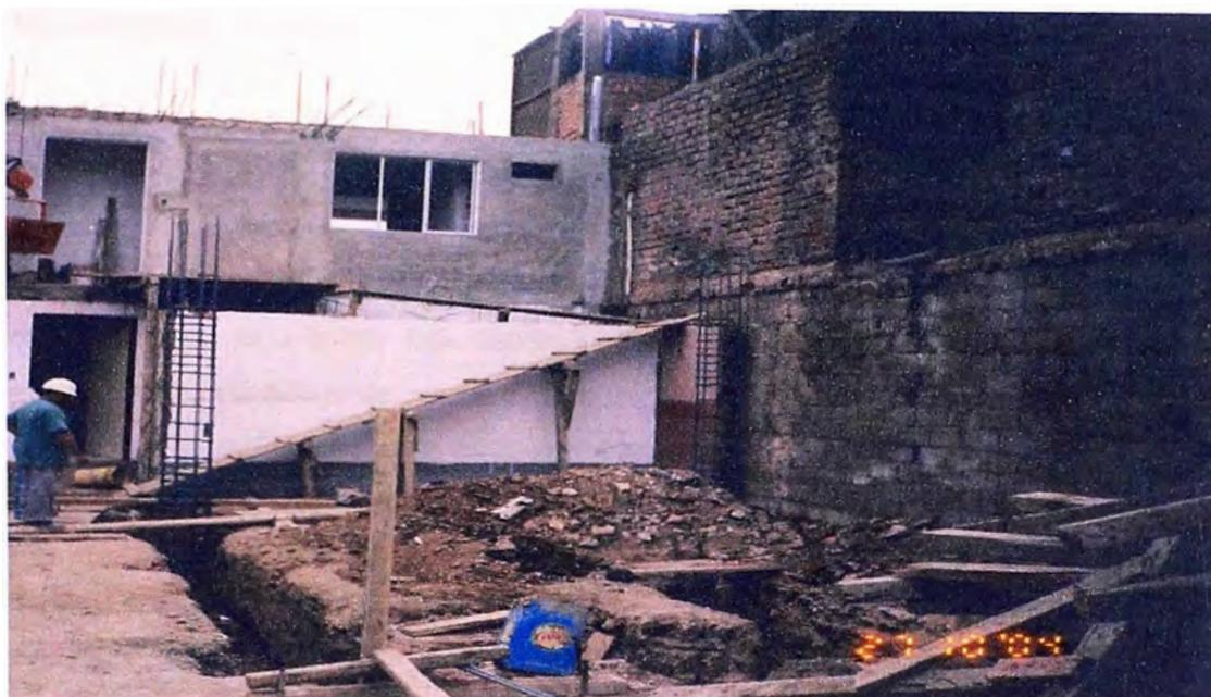
**Foto N°10** Se aprecia la excavación de los cimientos y la acumulación de material excedente que luego serán eliminados por el personal obrero
