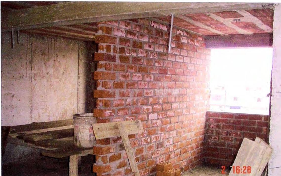
**Foto N°4** Observamos el armado de los andamios para el tarrajeo del cielorraso, que es una partida ejecutada posterior a la albañilería, además del endentado en la propia albañilería
