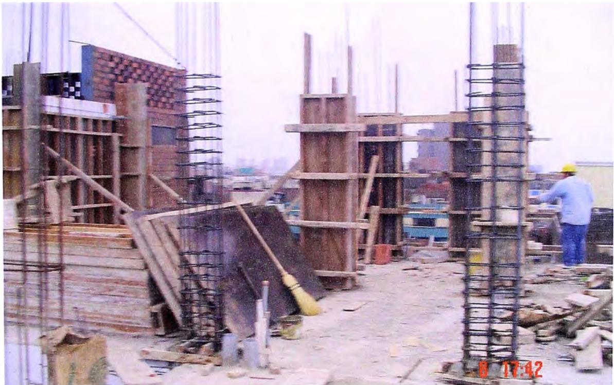
**Foto N°3** Corresponde al encofrado de las placas y columnas del bloque N°4
