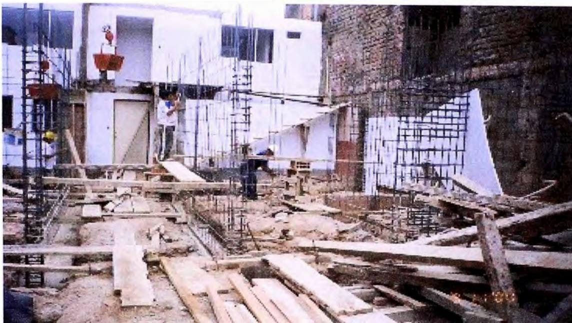
**Foto N°12** Se puede apreciar al personal realizando el trabajo de enmallado de las placas con fierro de 8mm
