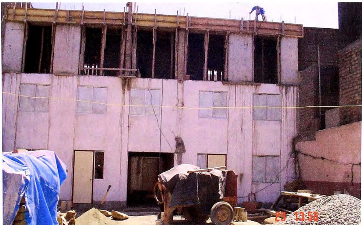
**Foto N°4** vaciado de losa del tercer piso del Bloque 3 (Sistema de Ductilidad
