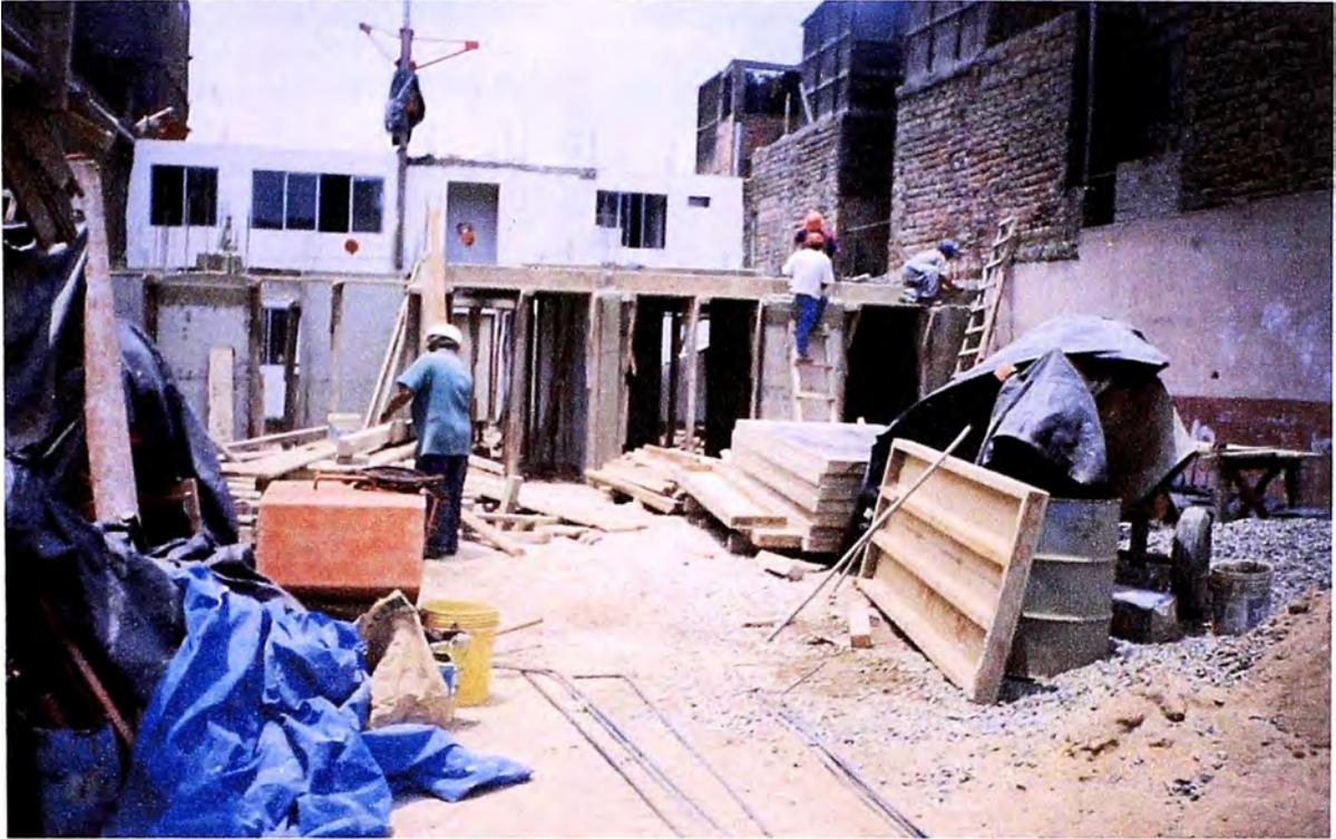
**Foto N°5** Encofrado de losa y vigas del Bloque 3
