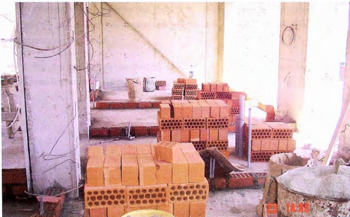
**Foto N°3** Emplantillado de los muros de albañilería para el asentado respectivo en los ambientes de dormitorio; observándose lo reducido de las ambientes
